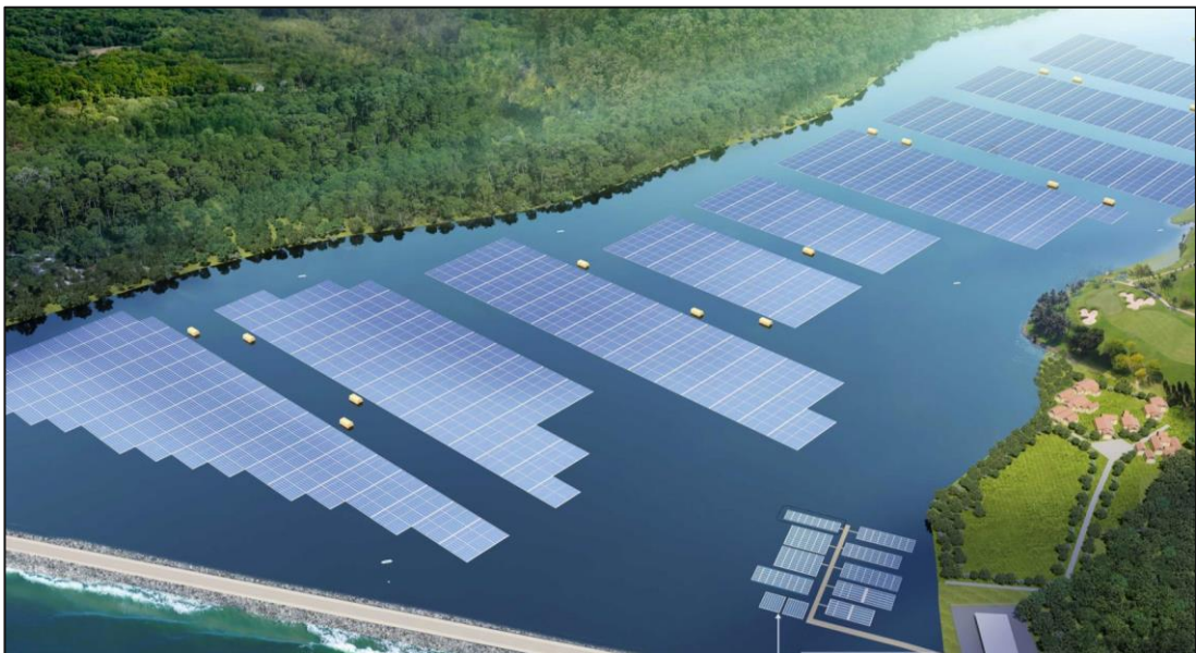
Abbildung 9: Schwimmende Anlage
