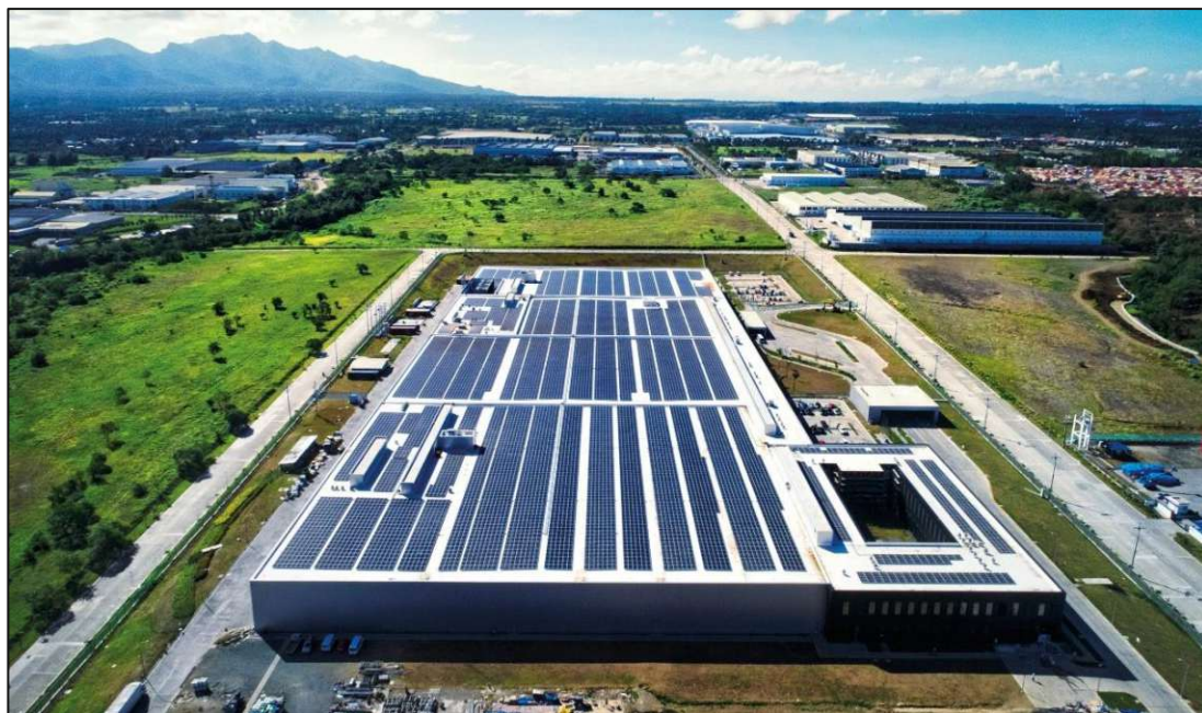
Abbildung 10: Flachdachanlage
