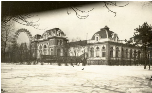
Abb. 43 BVA vom Süd-Osten mit Mittelrisalit und Südpavillon, um 1935-1943
