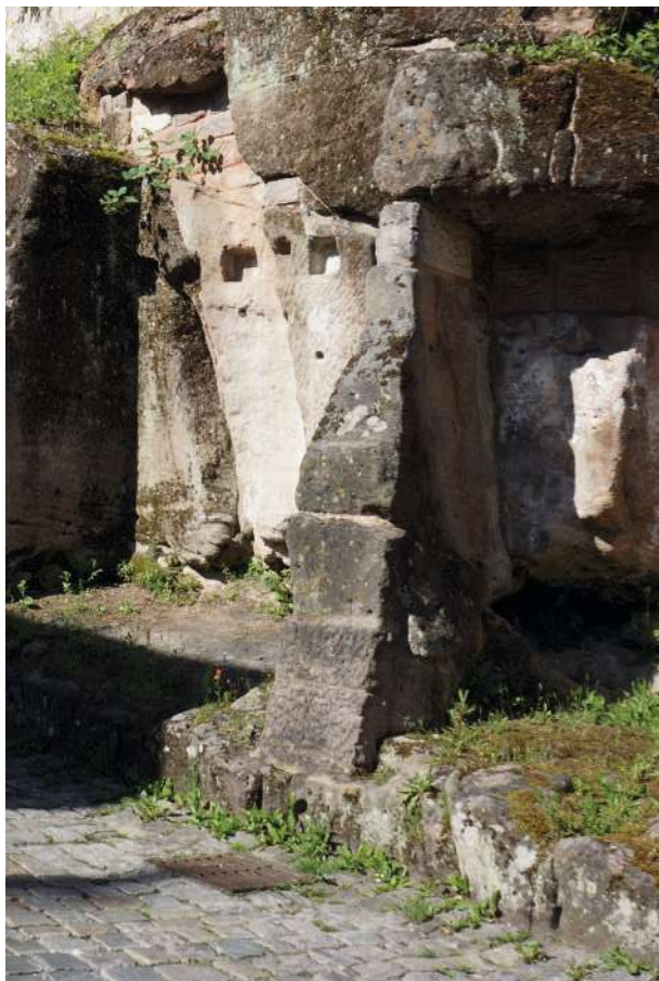
Abb.12: Überreste des östlichen Nebentors in der Burgstraße
