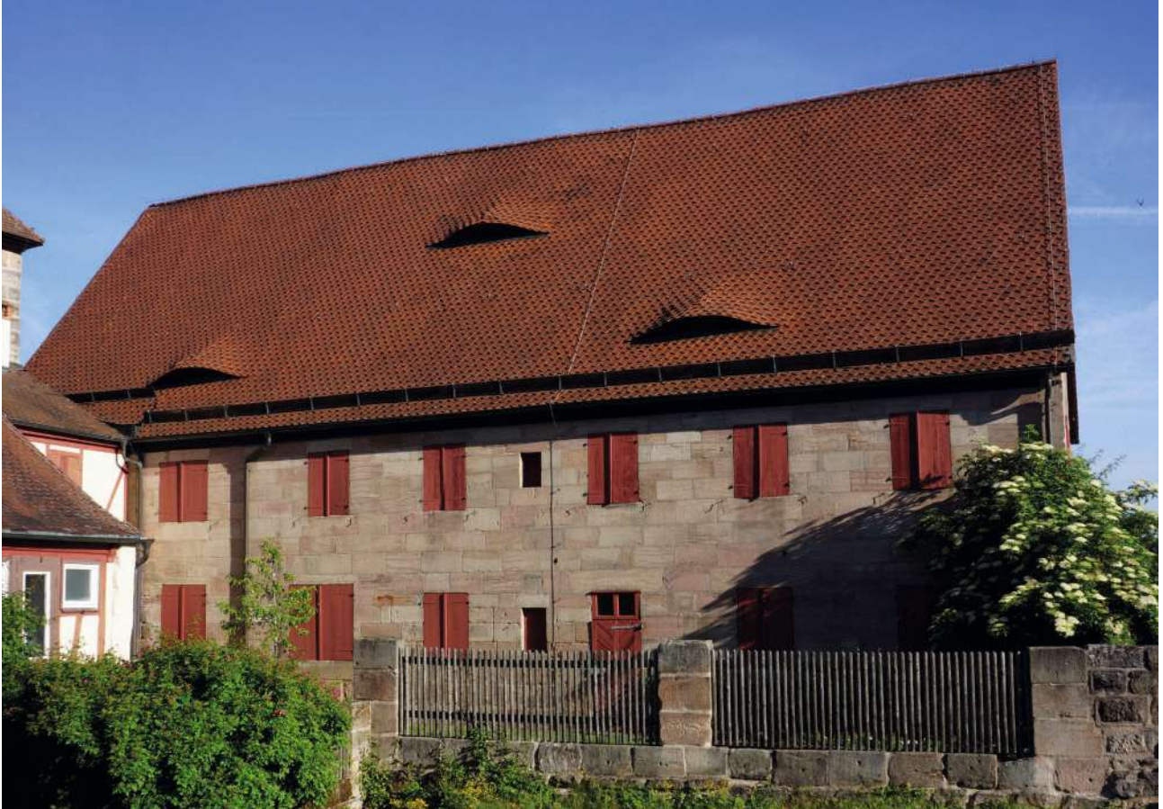
Abb.165: Südansicht des alten Landschulhauses
