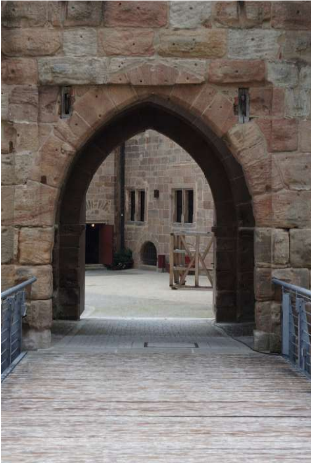
Abb.152: Kernburgtor mit Blick nach Norden
