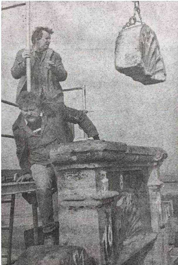
Abb.69: Arbeiten am Renaissance-Giebel, 1990
