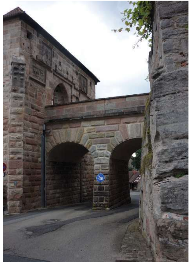
Abb.36: Westansicht des Torzwingers
