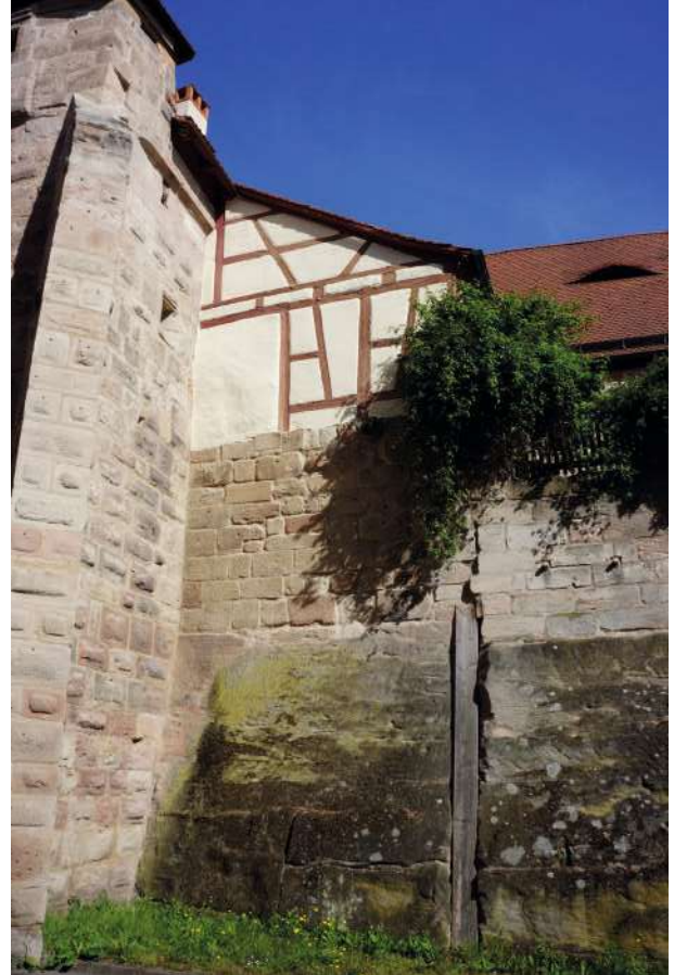
Abb.10: Anstehender Fels am Graben der Vorburg
