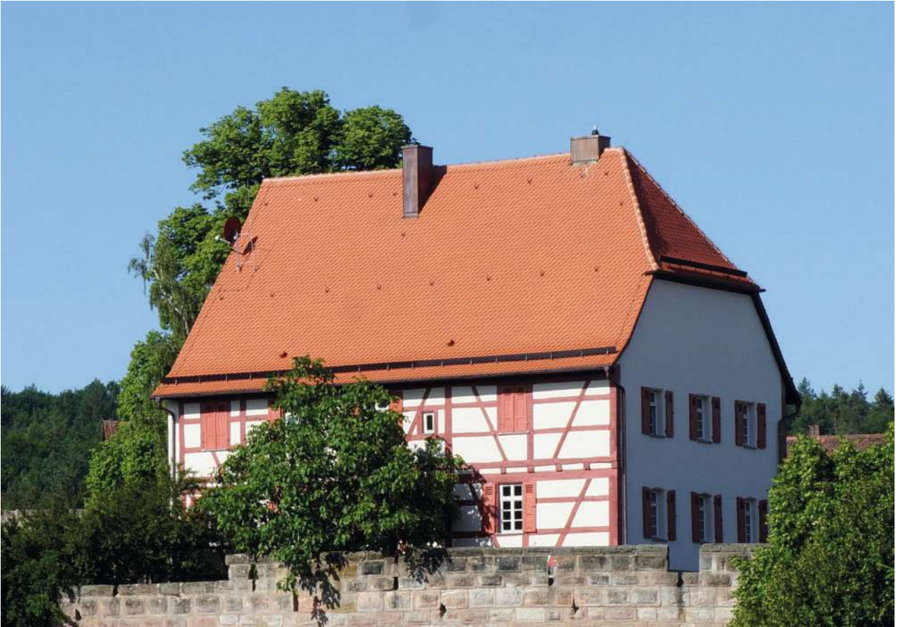
Abb.168: Nordostansicht des Pfarrhauses
