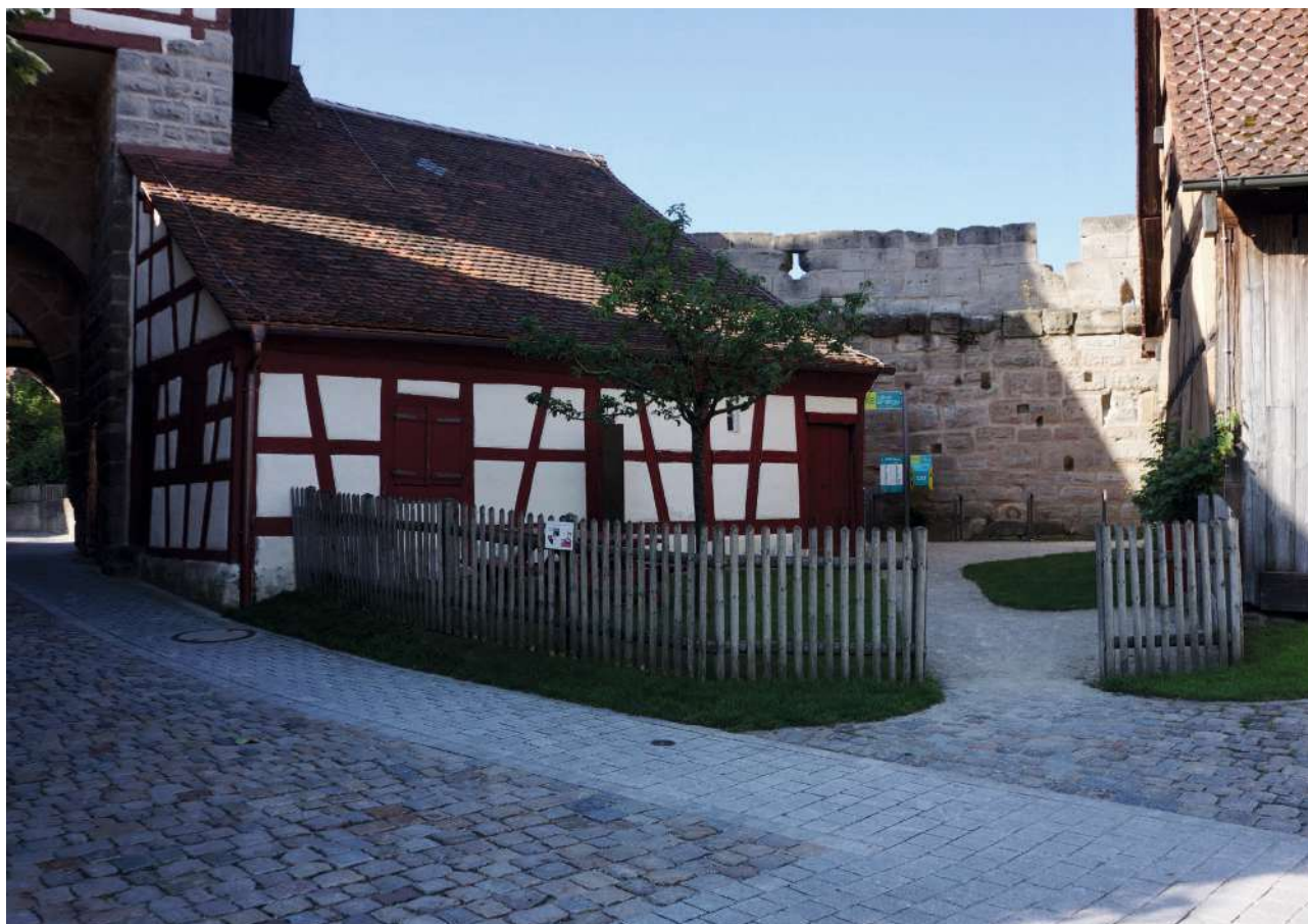
Abb.191: Nordostansicht des einstigen Waschhauses
