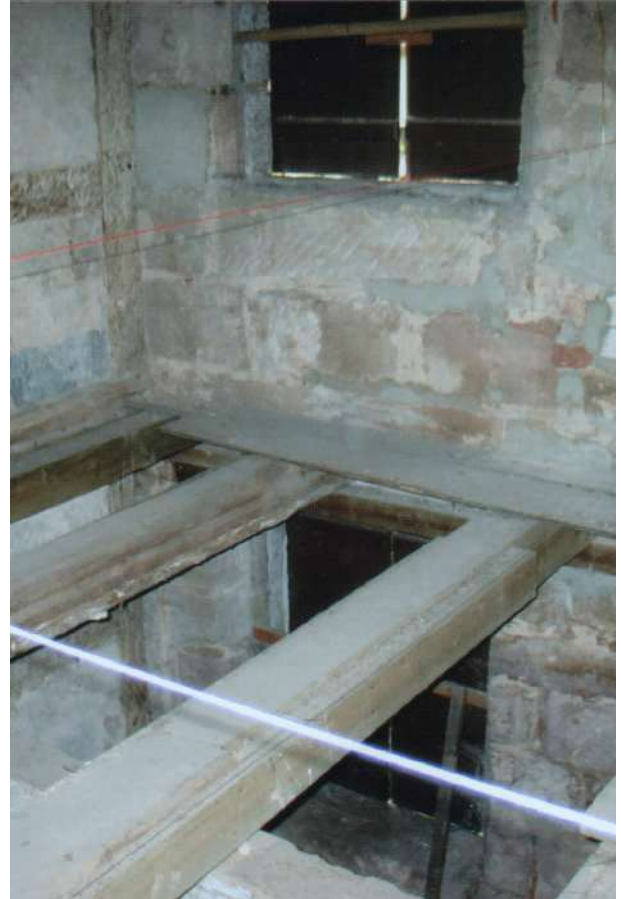
Abb.175: Obergeschoss im alten Schulhaus, Bauaufnahme 2003
