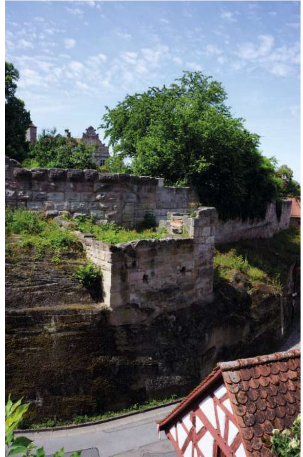
Abb.34: Die Streichwehr an der Südostspitze
