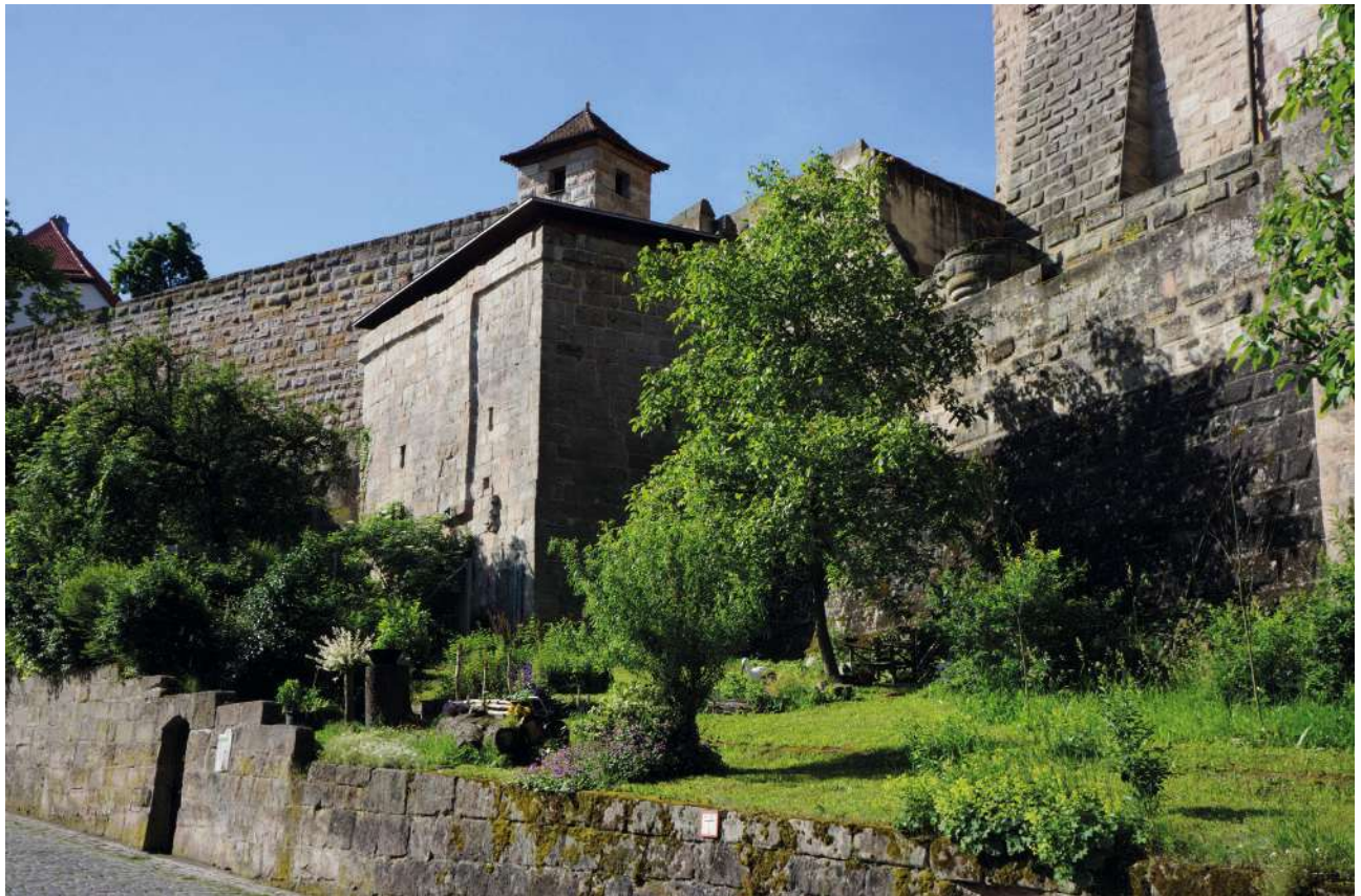
Abb.29: Die Streichwehr am östlichen Ende „Kühler Grund“
