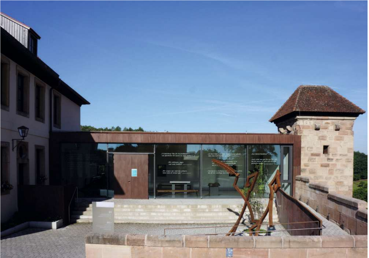
Abb.179: Ostansicht des Anbaus der einstigen Vogtei
