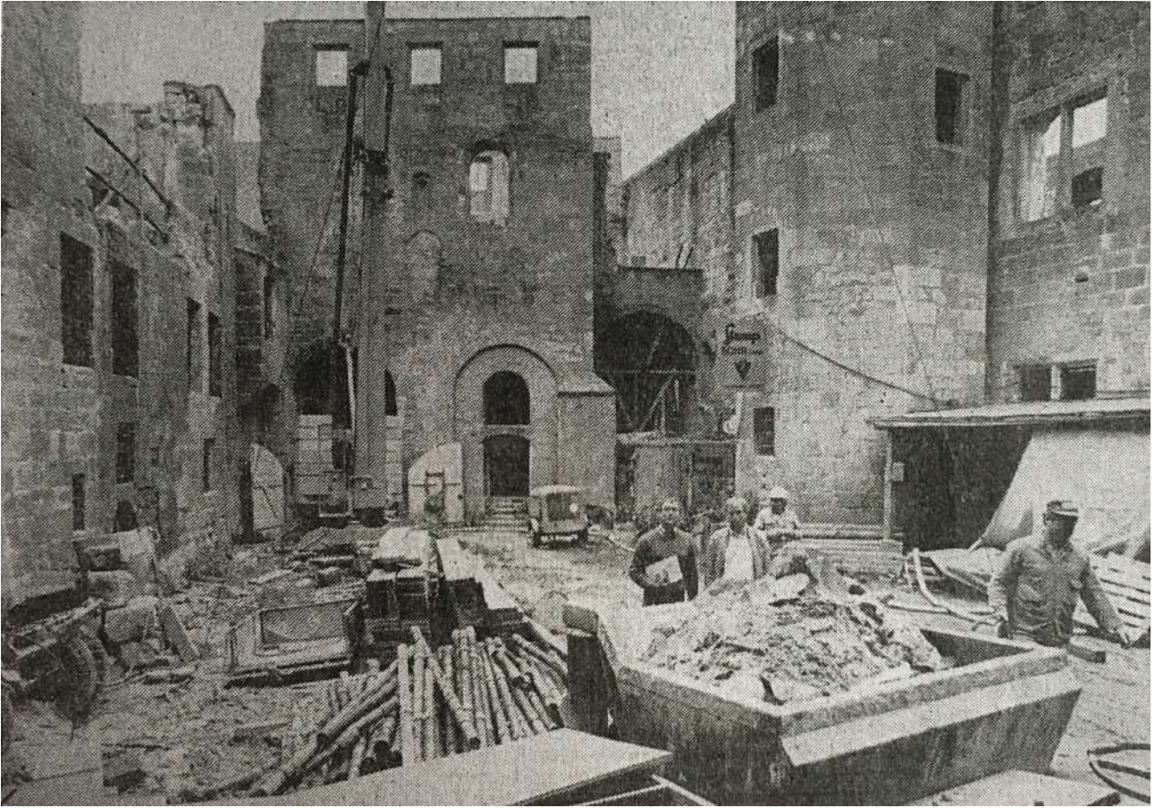
Abb.66: Aufbauarbeiten im vorderen Burghof, 1986
