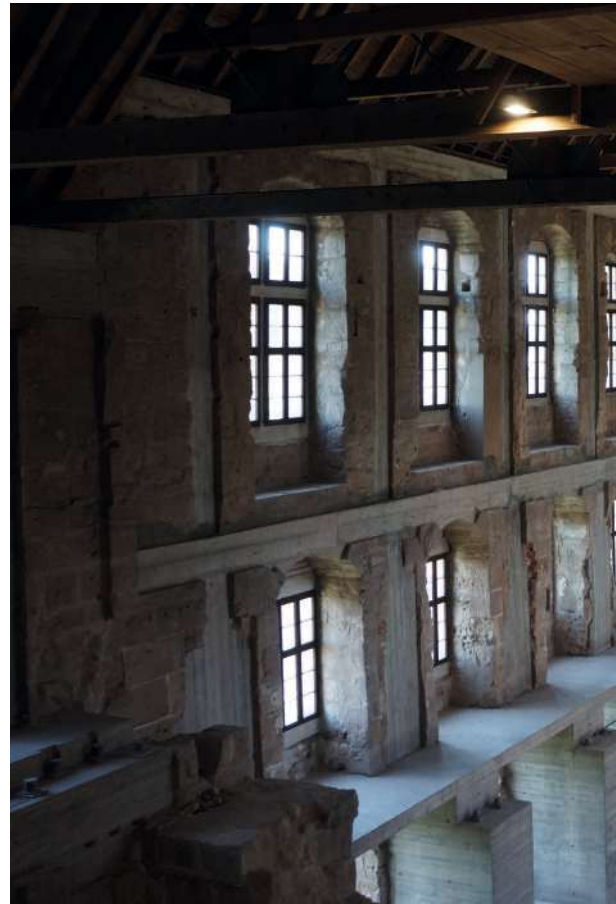
Abb.70: Betonbänder zur statischen Sicherheit
