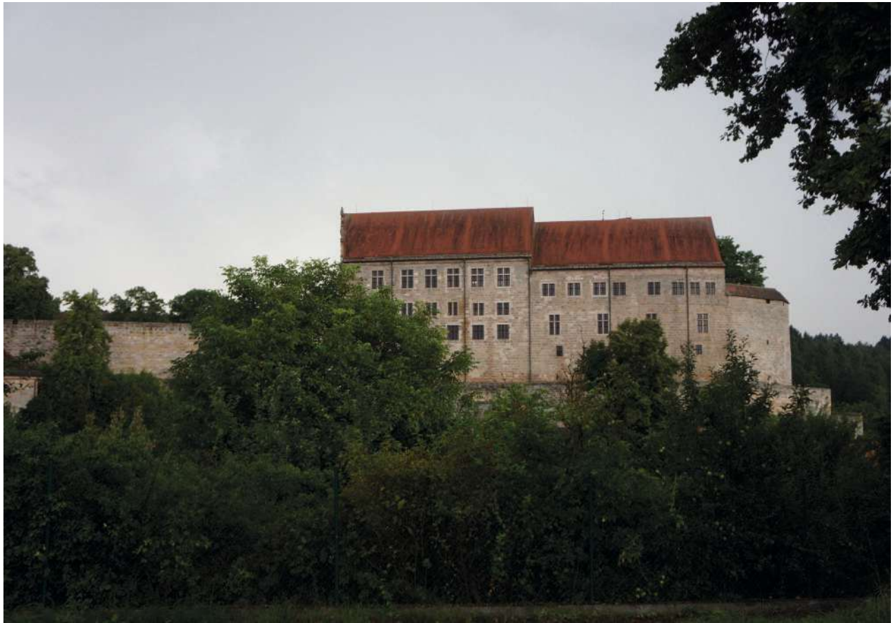
Abb.138: Blick auf die Ostfassade der Burg
