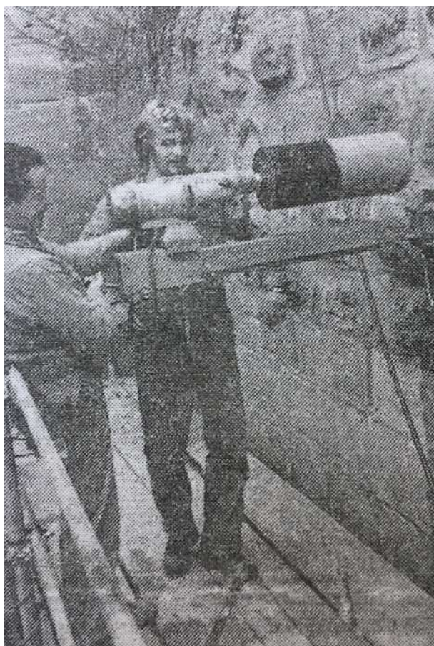
Abb.64: Vorarbeiten für die Vernadelung, 1983
