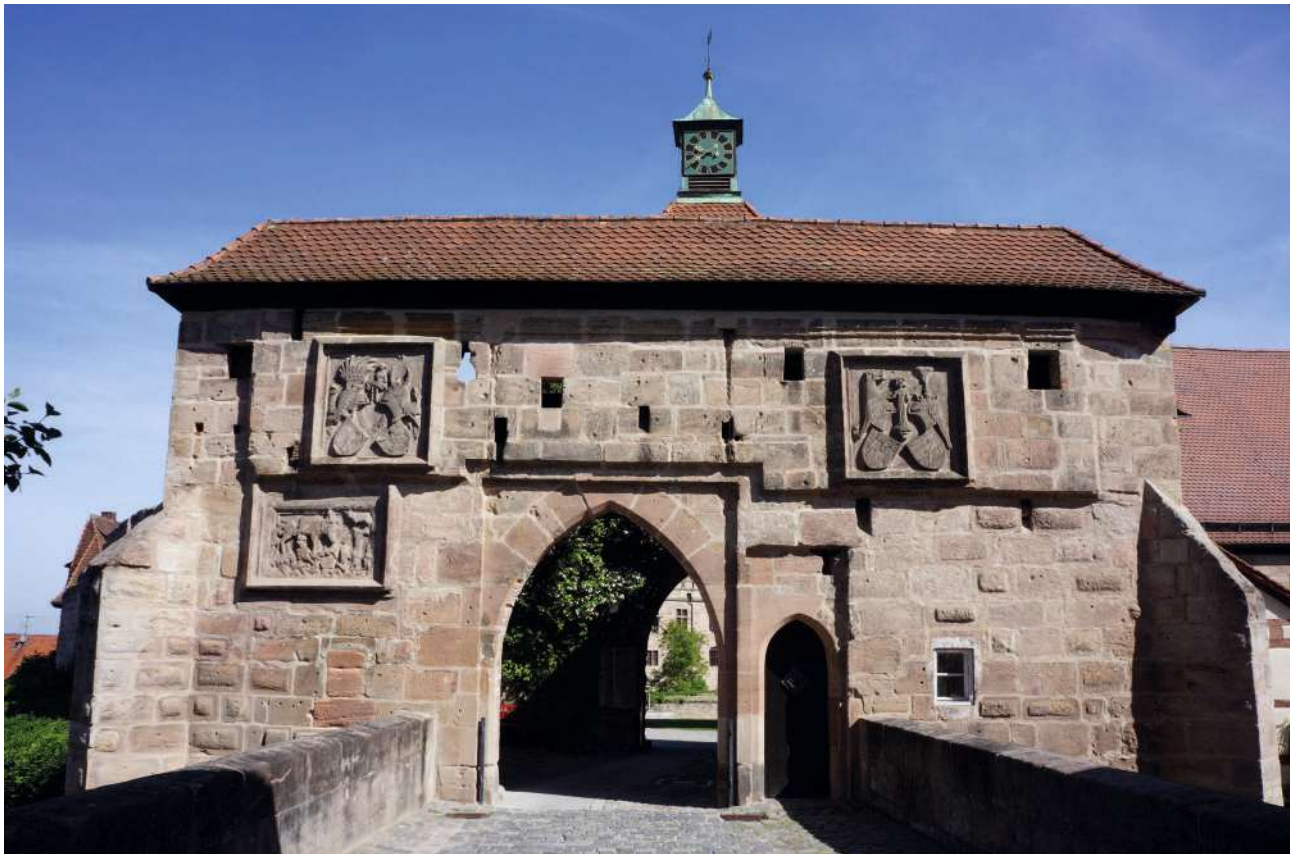
Abb.38: Südwestansicht des Torzwingers
