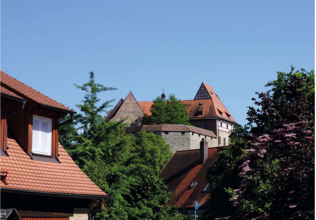
Abb.15: Nordansicht von der Dachlandschaft der Cadolzburg
