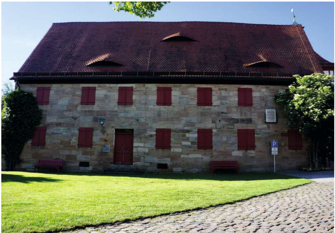
Abb.162: Nordansicht des alten Landschulhauses
