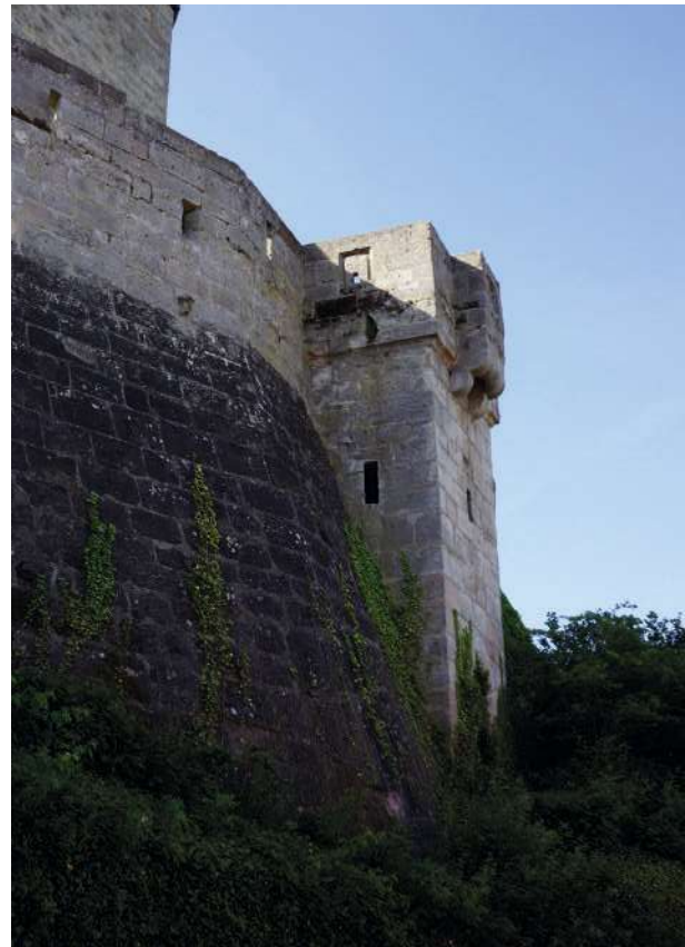
Abb.27: Die Streichwehr an der Nordwestspitze
