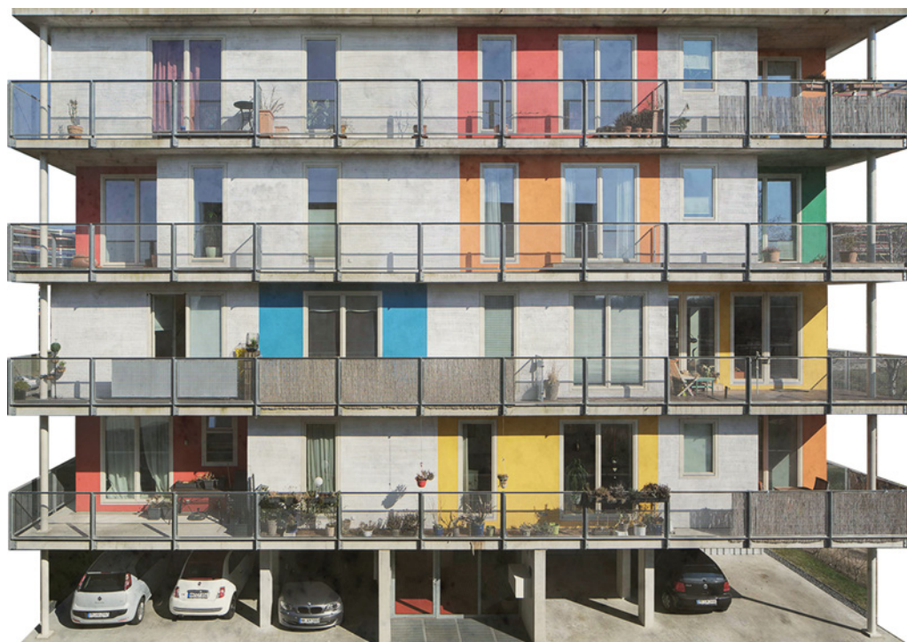
Abb. [29] Außenperspektive des ausgebauten Wohnhauses. Fertigstellung 2013. Quelle: BeL – Soziale tät für Architektur.
