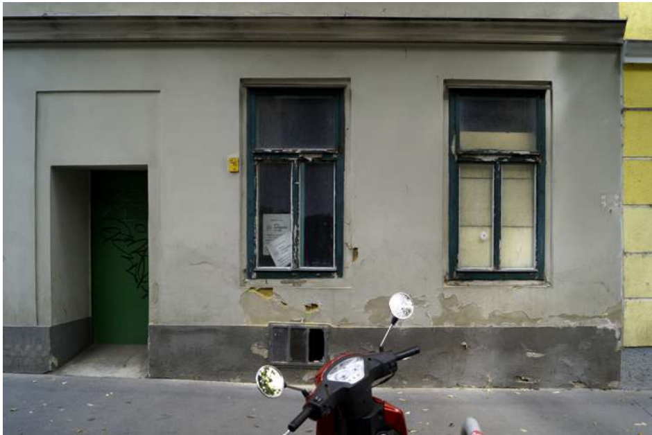
Abb. 46 Koppstraße 58, 16. Bezirk eigene Aufnahme
