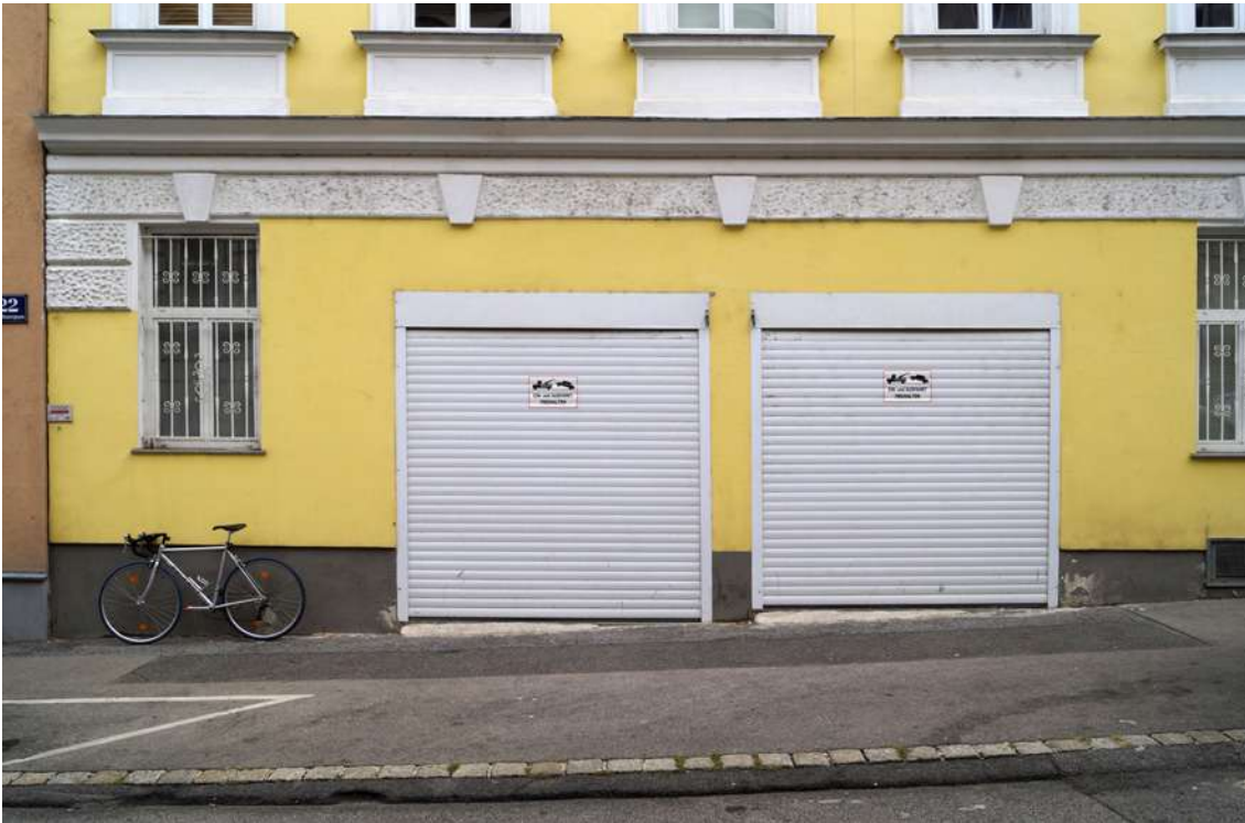
Abb. 27 Garageneinbau Ganglbauergasse 20, 16. Bezirk eigene Aufnahme
