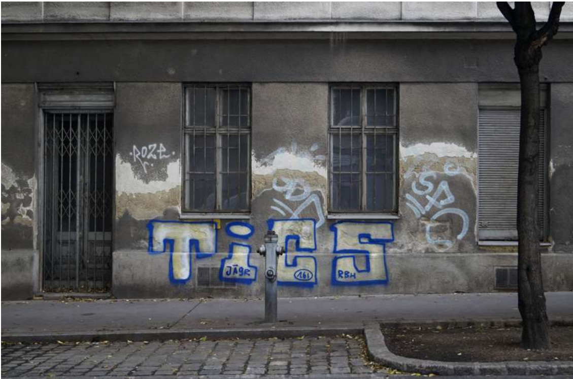
Abb. 42 Koppstraße 57, 16. Bezirk eigene Aufnahme
