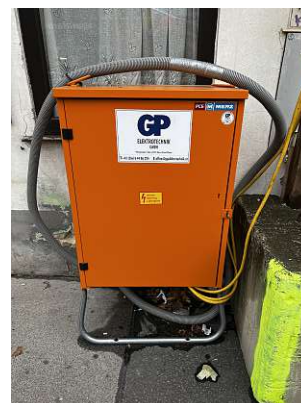
(b) Anschlussverteilerkasten
