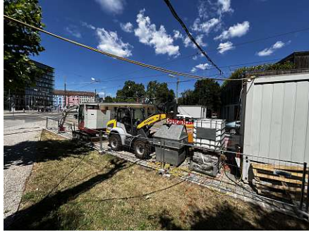
(a) E-Bagger Huppenkothen TB260E und der E-Radlader Wacker-Neuson WL20e
