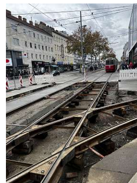
Abb. 3.4: Beispielhafte Gleiserneuerung auf der Baustelle Simmeringer Hauptstraße
