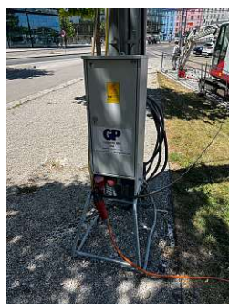
(a) Baustromanschluss
