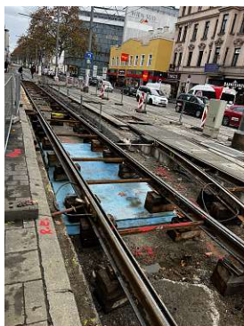
Abb. 3.4: Beispielhafte Gleiserneuerung auf der Baustelle Simmeringer Hauptstraße
