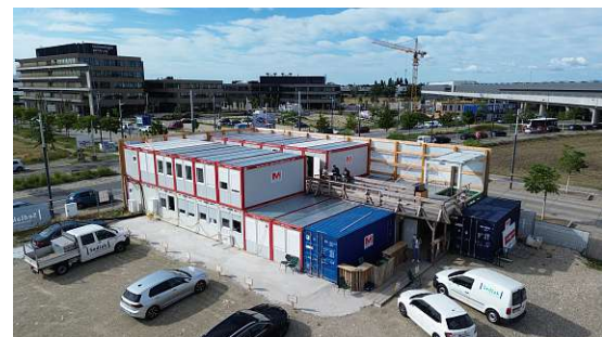
(b) Baustelleneinrichtung in der Seestadt
