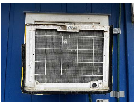
(a) Alulamellen von Kompaktklimagerät
