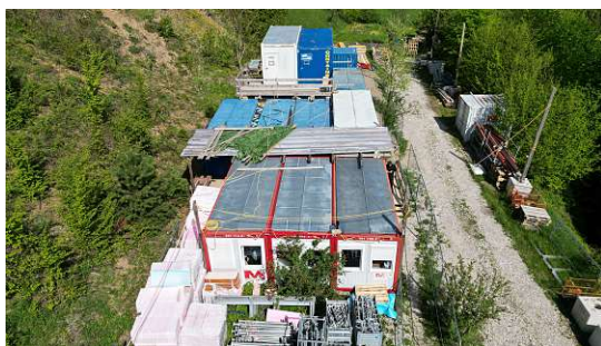
(a) Baustelleneinrichtung in Kaltenleutgeben
