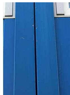
(b) Spalt zwischen zwei Containern
