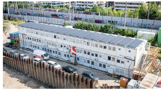
(b) PV-Anlage auf Containerburg [81]
