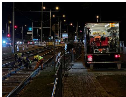
Abb. 4.1: Klein-LKW als mobile Werkbank
