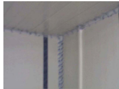
(b) Anschlussbereich MIT Abdichtung
