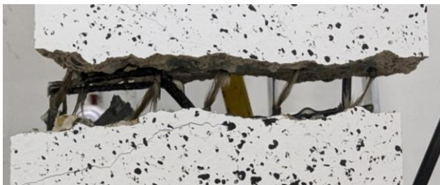
Abb. 6.8: Zugbruchversagen der Bewehrung des Versuchskörpers D19/V2-B
