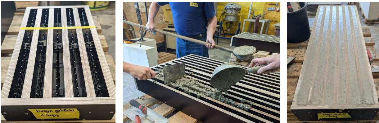
Abb. 6.2: Betonage bei der Firma Doka GmbH
