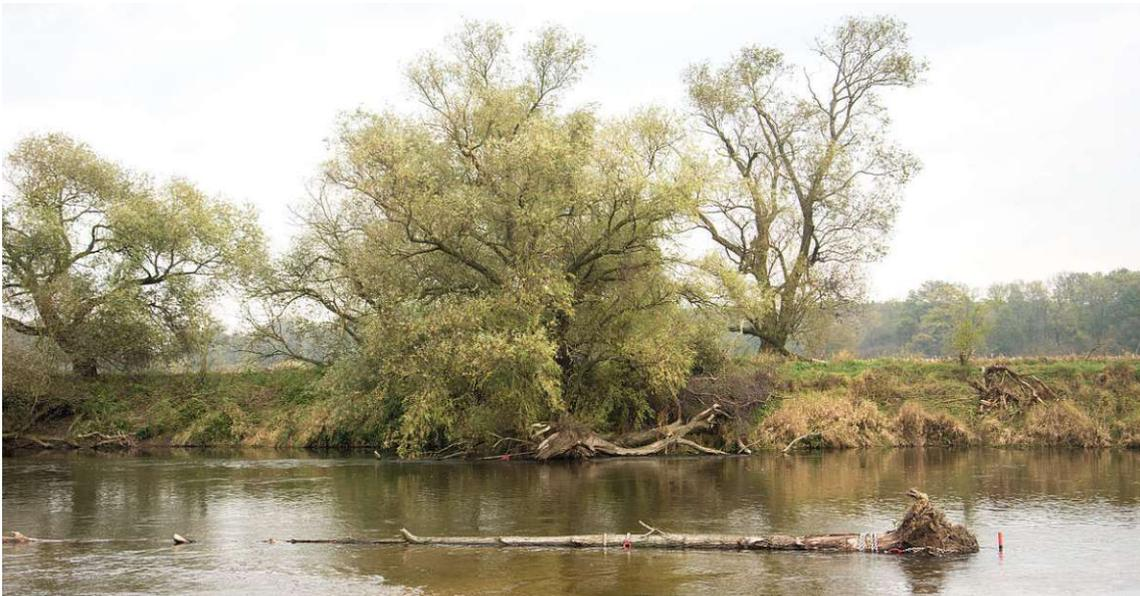
Abbildung 3: Fertig eingebauter Raubaum mit Wurzelteller. Fixiert durch Ketten und Betonblöcke. (Fließrichtung von rechts nach links, Foto: Nele Klimmer, WWF)
