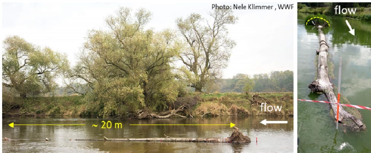
Abbildung 21: Astloser Baum mit Wurzelteller (Raubaum), geometrische Vorlage für das Baummodell, Baum 1 (Tree 1) aus Abbildung 12. Bild links: Aufnahme kurz nach Einbau, Bild rechts: spätere Aufnahme mit Bewuchs am Wurzelteller. (Fotos links: Nele Klimmer, WWF; Foto rechts: Schnauder)
