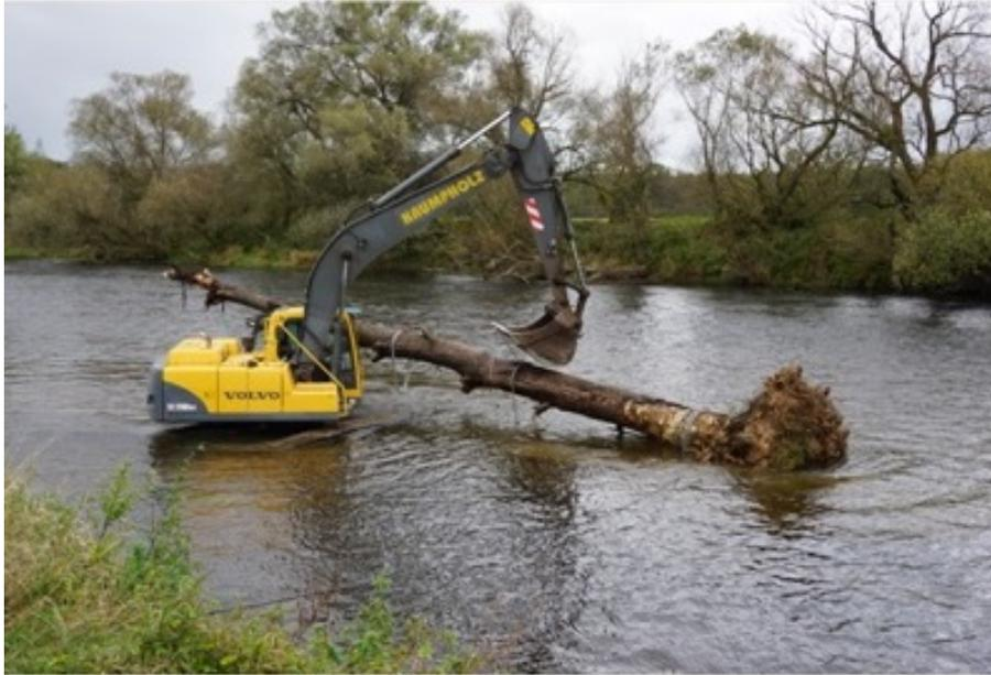
Abbildung 2: Einbau und Befestigung mit Ketten und Betonblöcken eines Raubaumes mit Wurzelteller in den Fluss Mulde bei Dessau, Sachsen-Anhalt (Fließrichtung von rechts nach links, Foto: Schrenner, WWF)
