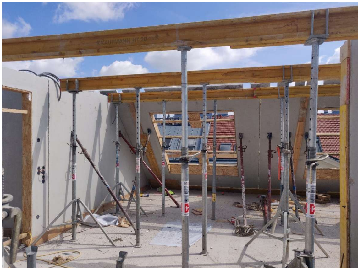
Abb. 5.3: Montierte Elementwände und Montageunterstützung für eine Elementdecke
