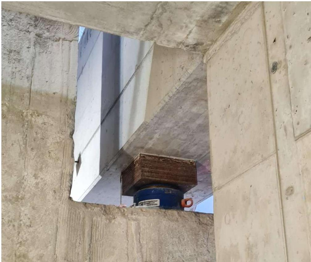
**Abb. 2.25:** Ausgeführtes Pressenauflager im Durchbruch einer Mittelschlitzwand
