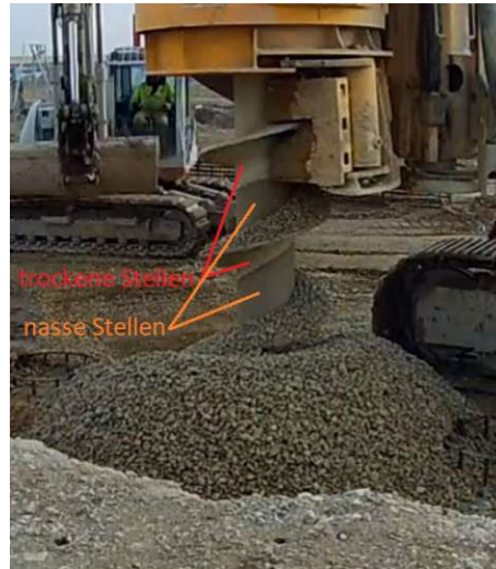
Abb. 7.5: trockene und nasse Stellen beim Ziehen der Schnecke in Donauschotter
