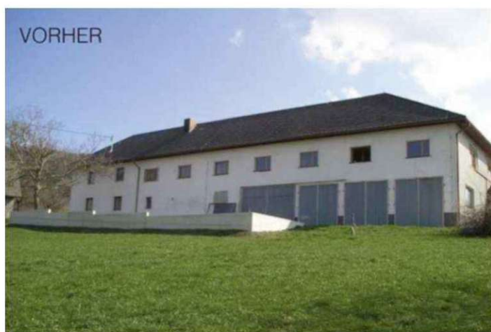
Abbildung 70: Vierkanthof vor dem Umbau, Quelle: junger_beer architektur zt-gmbh
