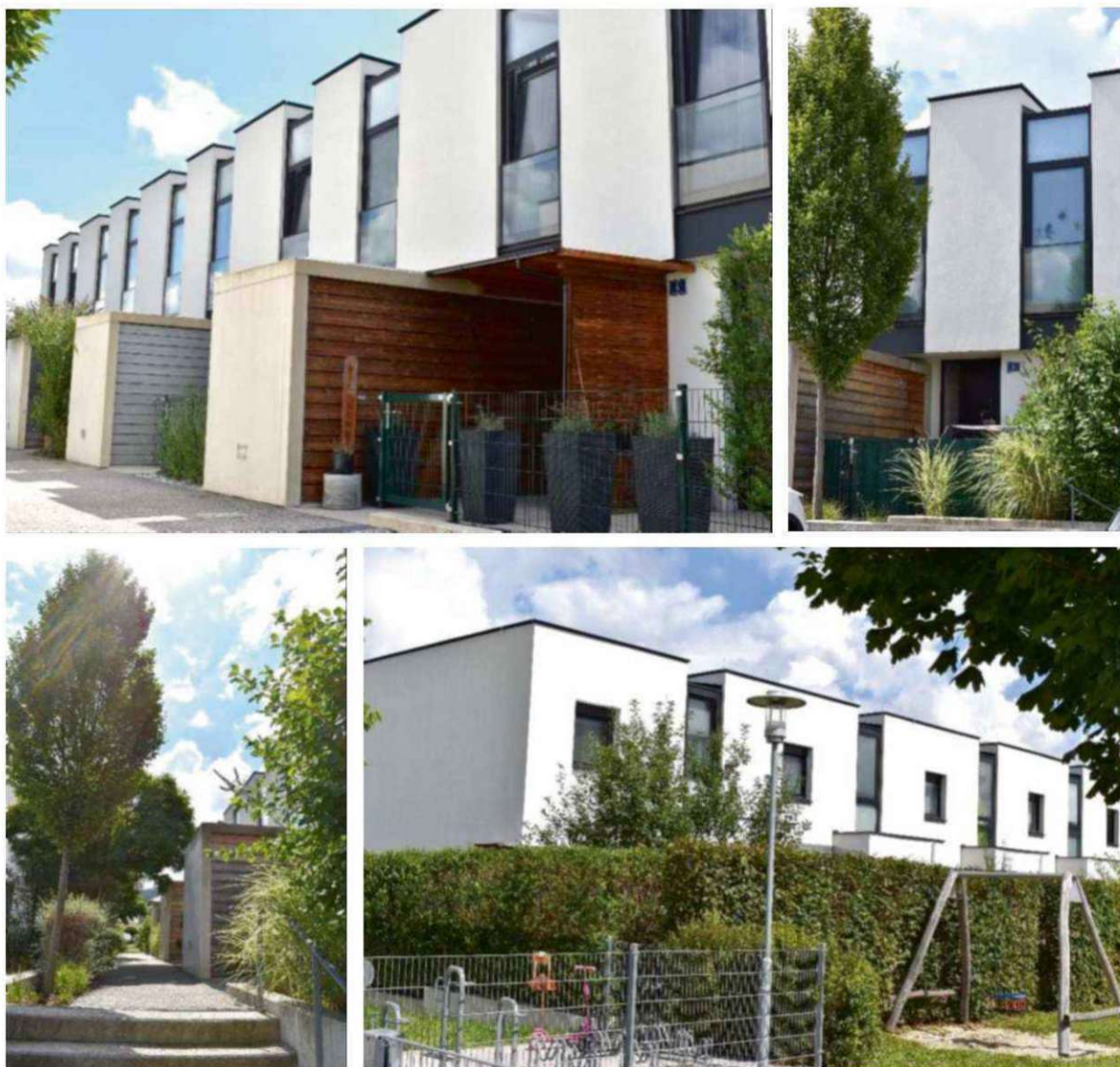
Abbildung 60: Reihenanlage Veltlinerstraße, Quelle: Stefanie Widhalm, August 2023
