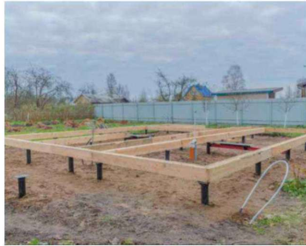
Abbildung 29: Aufbau eines Punktfundamentes – Quellen: baustoffwissen.de, 2015 (links) | energieleben.at, 2021 (rechts)
