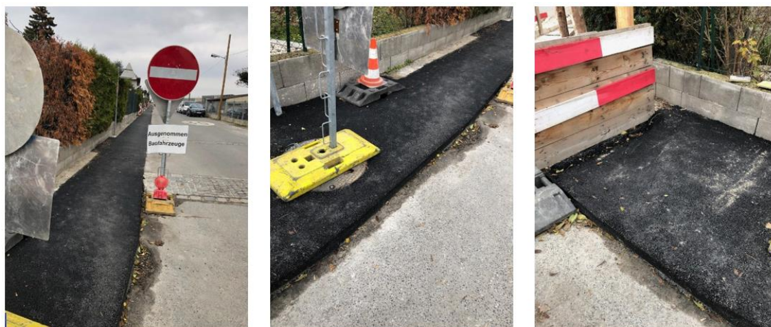
Abbildung 5-11: Kaltmischgut als Überwinterprovisorium
