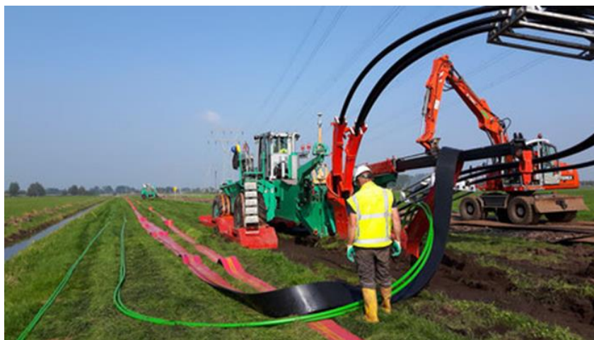
Abbildung 4-10: Einpflügen 380 kV-Kabel (IFK GesmbH, 2023)
