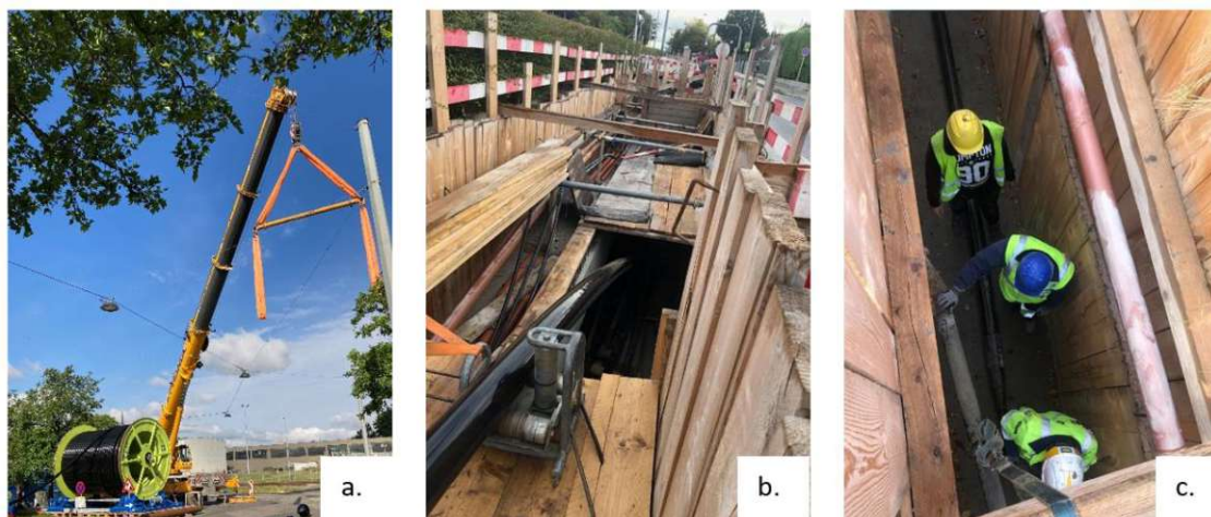
Abbildung 5-8: Kabeleinzug (a.: Aufnahme Wiener Netze GmbH)
