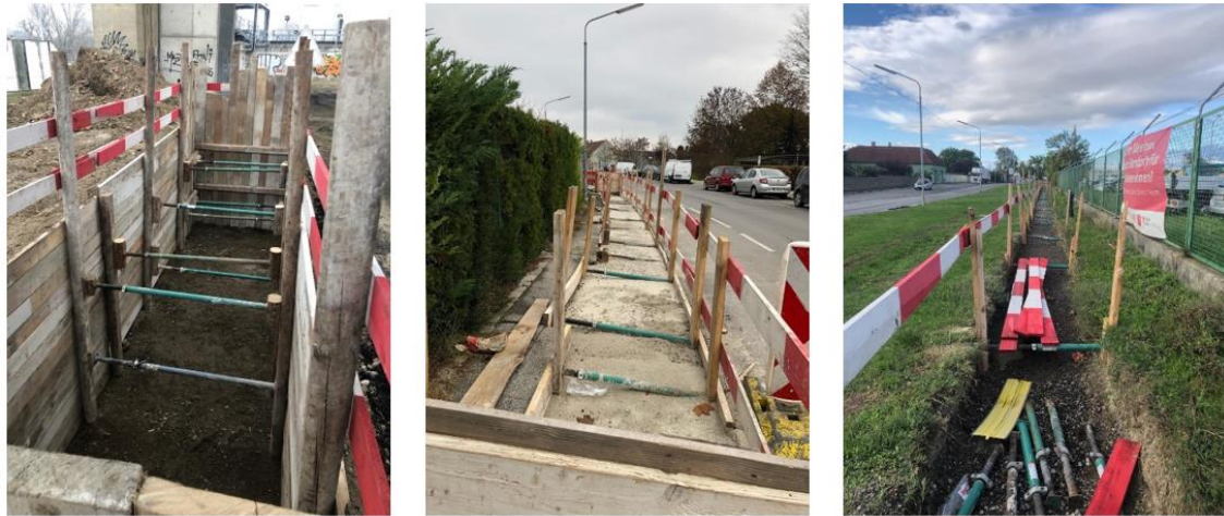
Abbildung 5-9: Verfüllt und verdichtete Künette
