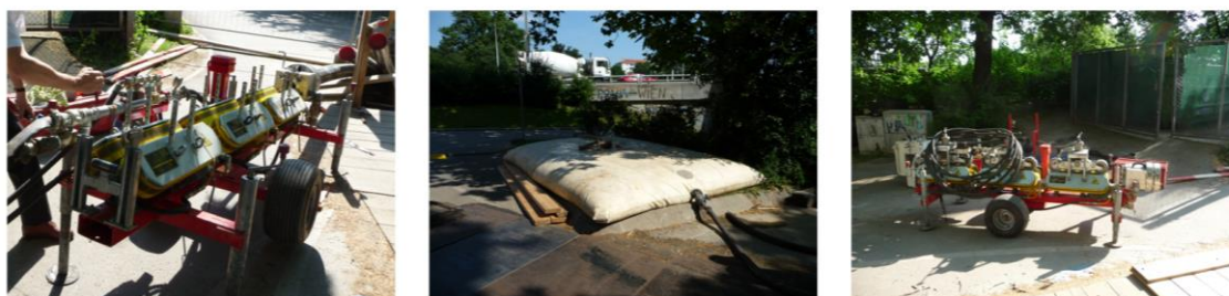
Abbildung 5-7: Einschwemmverfahren 110 kV-Kabel (Aufnahme Wiener Netze GmbH)
