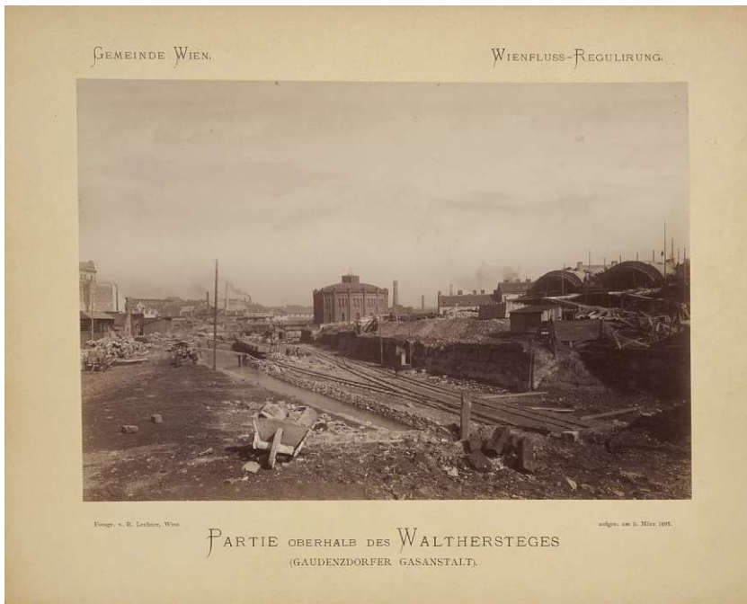
Fig. 64 Wienflussregulierung 1894 - 1900, Gaudenzdorfer Gasworks, 5.3.1897
