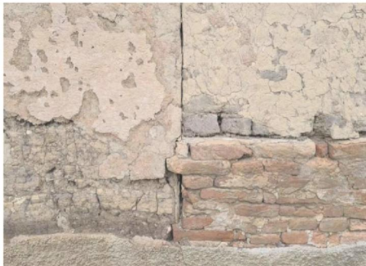
Abbildung 42 links Stampflehm, rechts Ziegelfundament mit Lehmziegelwände, Pişcolt
