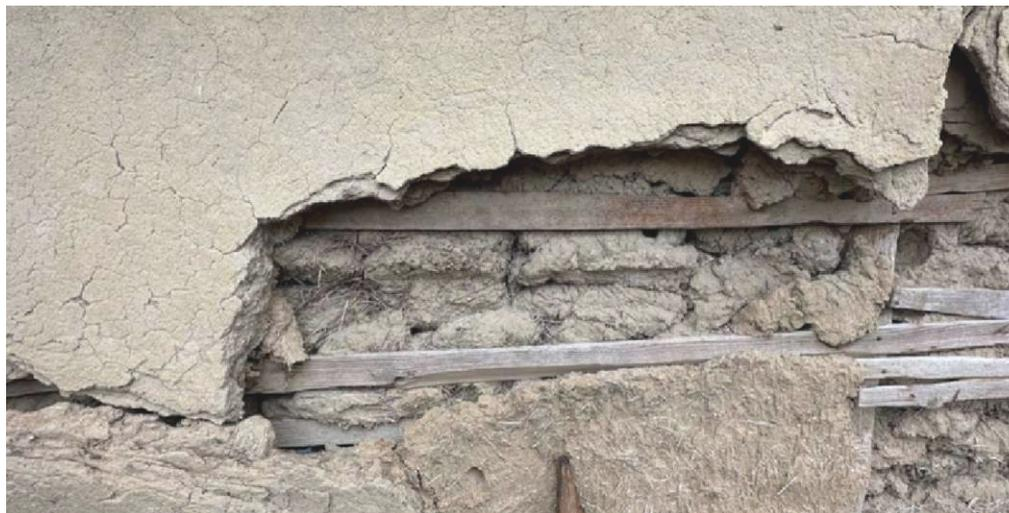
Abbildung 102 Bildaufnahme Wandkonstruktion, Foltești
