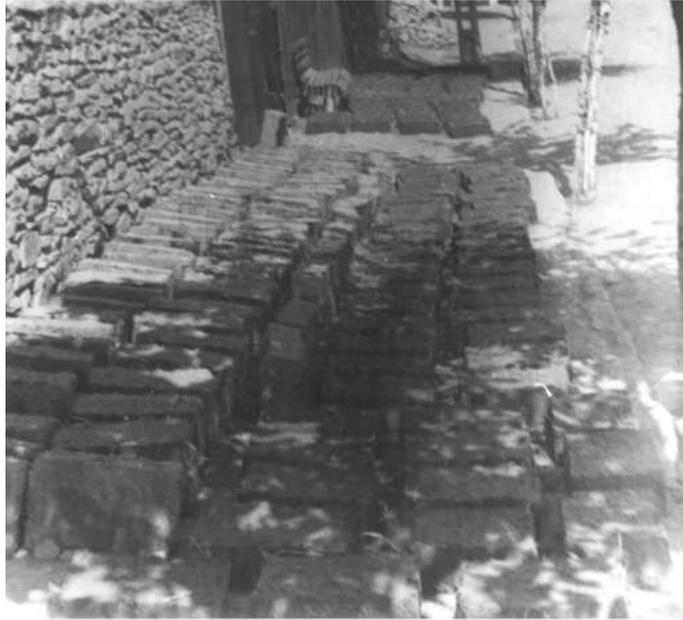
Abbildung 34 Austrocknungsprozess Lehmziegeln (chirpici)
