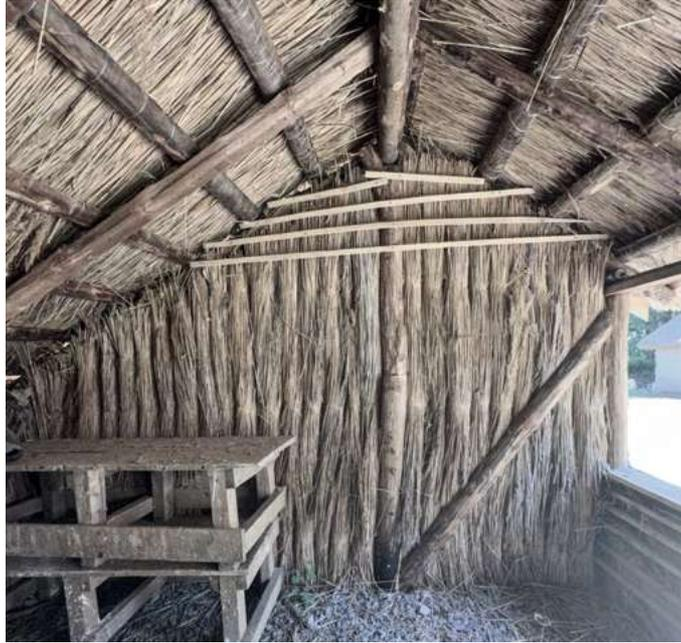
Abbildung 28 Wandaufbau aus Holzpfosten mit Schilfrohr (furci cu stuf si paiantă), Bauernhof Letea, Freilichtmuseum Astra Sibiu
