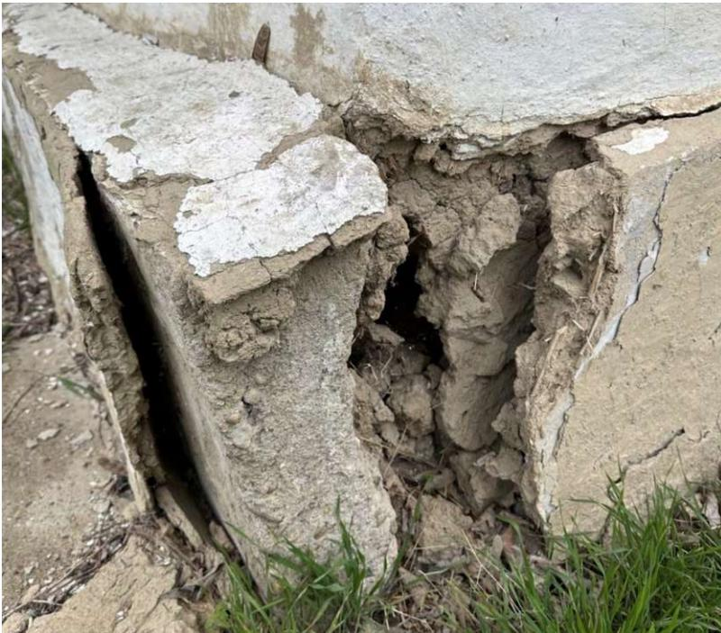
Abbildung 135 Wohnhaus, Eck Ost-Südansicht, beschädigten Betonstreifen
