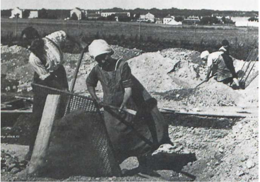
► 75 Erdarbeiten im Zuge der Wiener Siedlerbewegung. Novy, et al., 1991, S.62
