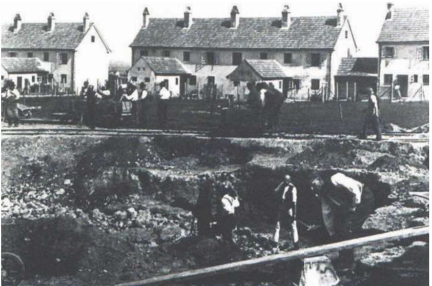
► 76 Während der Bauphase galt es, gut organisiert zu sein. Der Aushub erforderte hohen körperlichen Einsatz. Novy, et al., 1991, S.54
