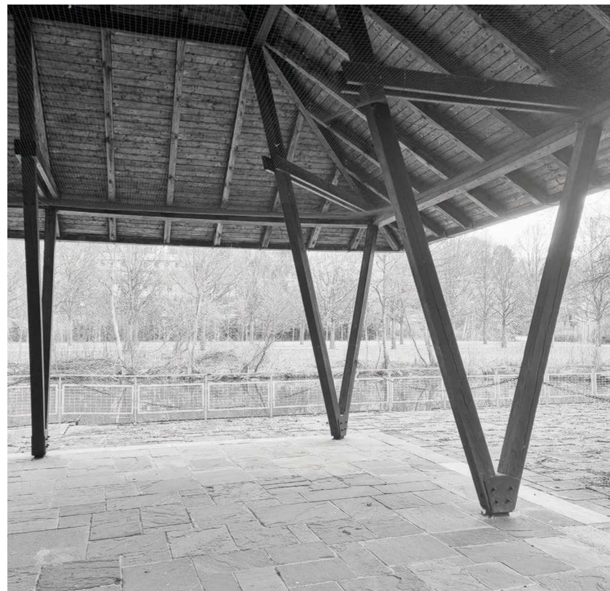
Abbildung 46: Saunagebäude, Zangenkonstruktion
