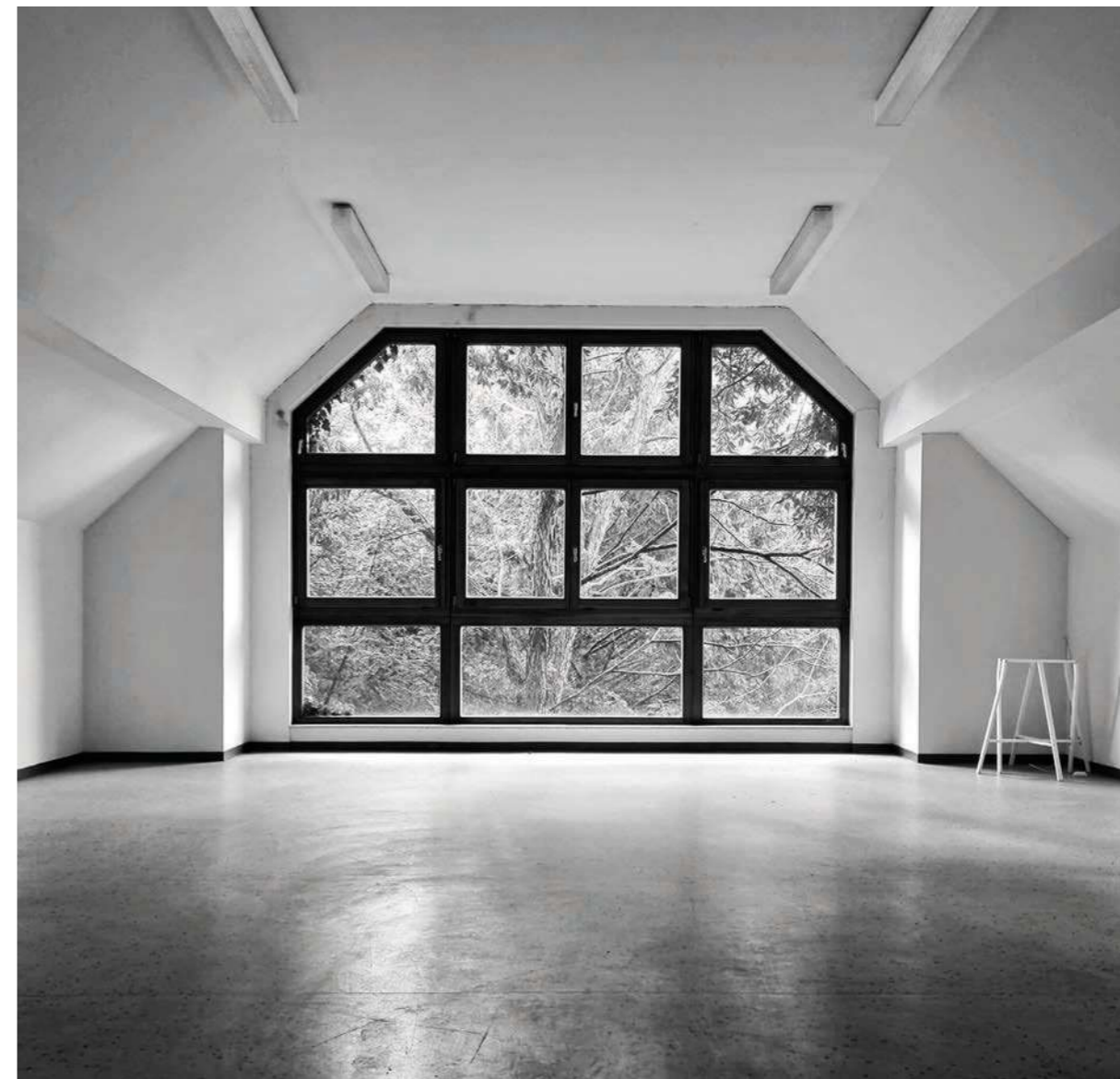
Abbildung 22: Alte Mühle, Fenster im DG
