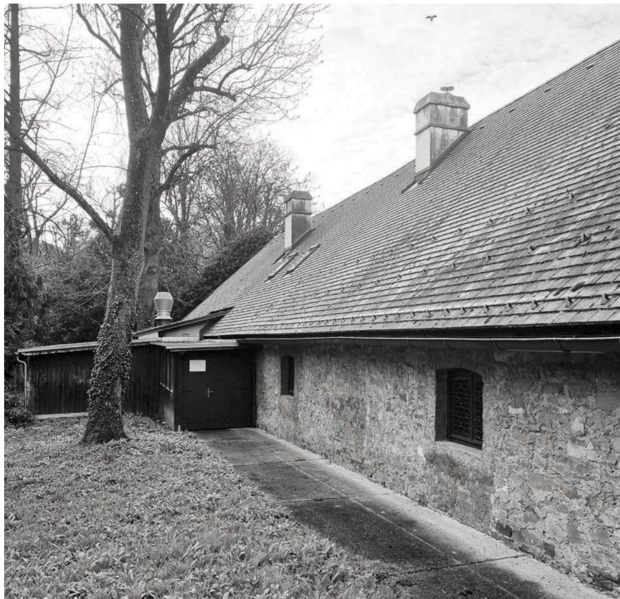
Abbildung 21: Alte Mühle, Haustechnik
