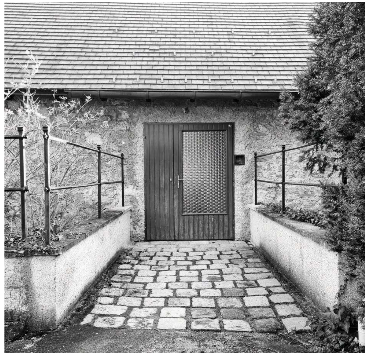
Abbildung 20: Alte Mühle, Eingang
