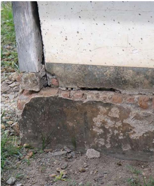
**Abbildung 93:** RIKA, schlechte Verbindung zwischen Holzrahmen und Fundament
