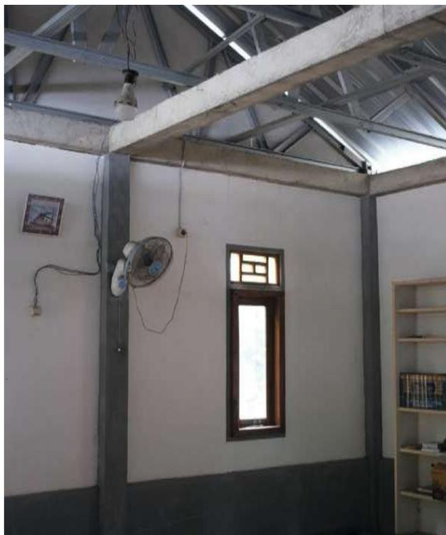
**Abbildung 100:** RIKO innen: Rahmen für das Tragwerk erkennbar, wegen der Hitze Ventilator notwendig
