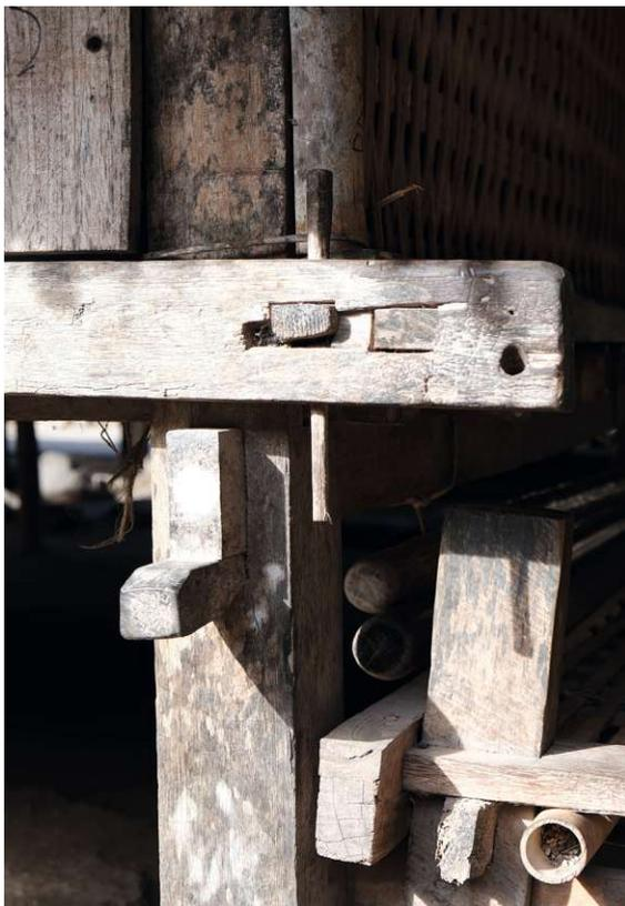
**Abbildung 79:** Dorf Sembagek: Verbindung der Holzkomponente mittels Stecksystem
