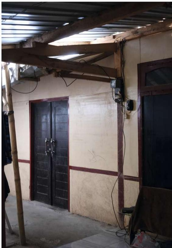
**Abbildung 102:** eigener Zubau mit einer Holzunterkonstruktion für das Vordach
