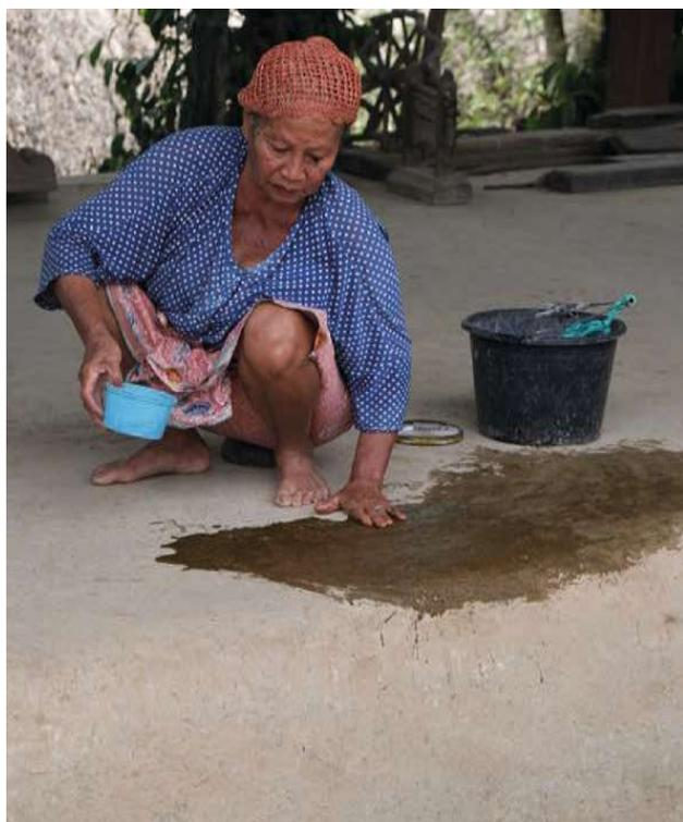
**Abbildung 74:** Dorf Sasak Ende, Lehmfundament wird mit Wasser und Kuhdung behandelt um Risse und Witterungsgefahr zu vermeiden
