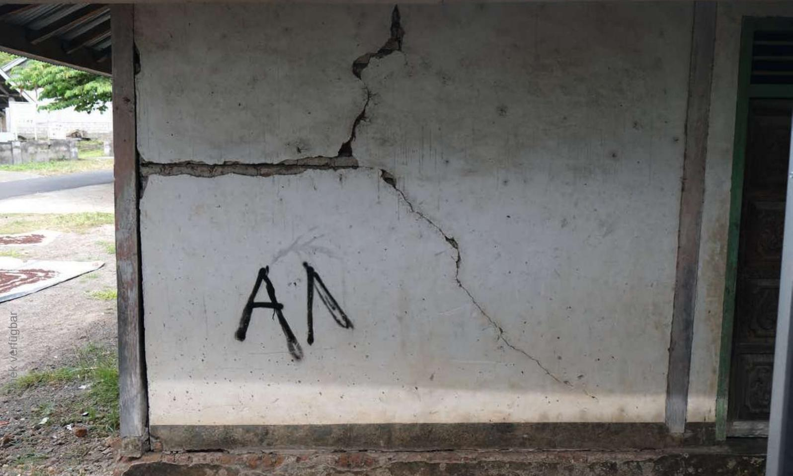
**Abbildung 92:** Der Wiederaufbautyp RIKA zeigt bereits zu diesem Zeitpunkt erhebliche Risse an den Wänden. In der standardisierten Version wird die Wand nach circa 60 Zentimetern mit leichteren Baumaterialien fortgeführt. Bei diesem Beispiel wurde die Wand durchgängig bis zur Decke massiv ausgeführt.
