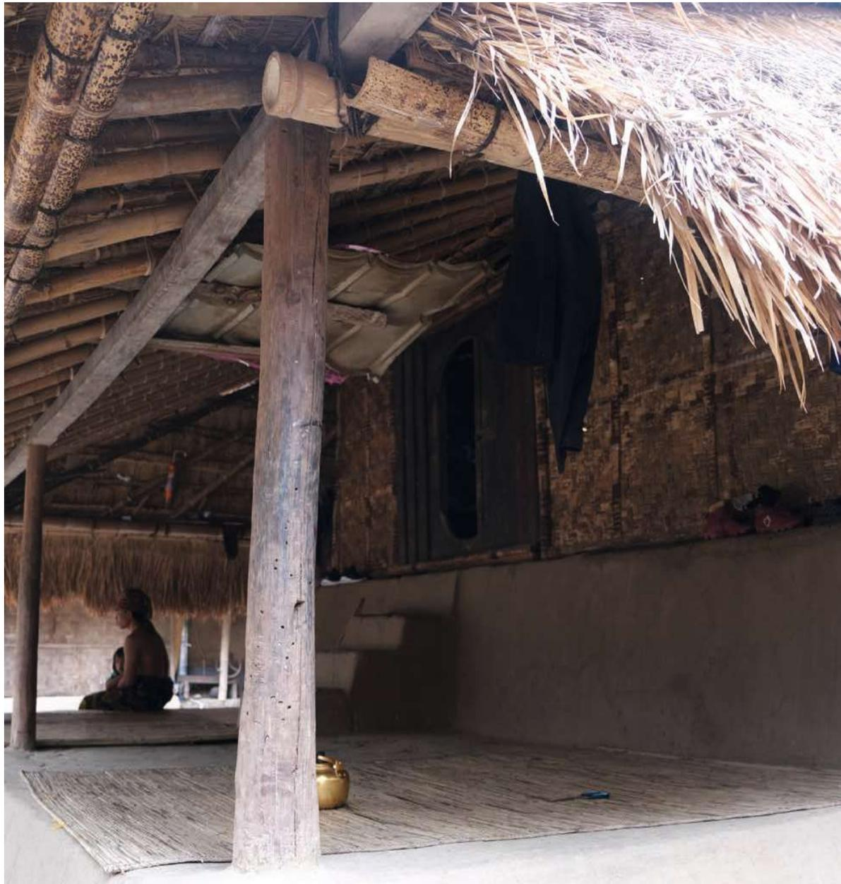
**Abbildung 78:** traditionelles „Bale Tani“ auf einem Lehmfundament, überdachte Veranda; mit einer Treppe und einer niedrigen Holztüre gelangt man ins Innere; es werden nur natürliche Materialien wie Holz, Bambus, Gras, Kuhdung und Schlamm verwendet
