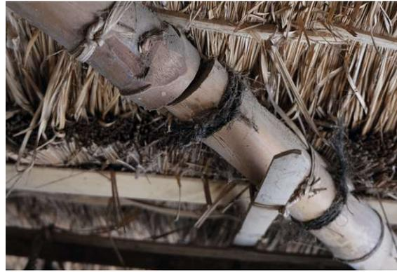
**Abbildung 77:** Bambusunterkonstruktion des Daches werden mit Palmengräsern verbunden
