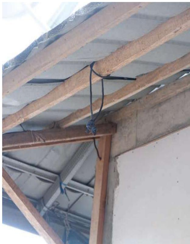
**Abbildung 108:** Selbstbau eines Vordaches aus einer Holzunterkonstruktion direkt an das Haus befestigt und einem Wellenblechdach
