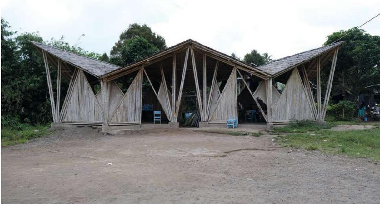
**Abbildung 165:** Wiederaufbau der Schule in Rempek: Hauptmaterial Bambus; Grundriss hat eine sechseckige Form mit drei hohen und drei niedrigen Fachwerken
