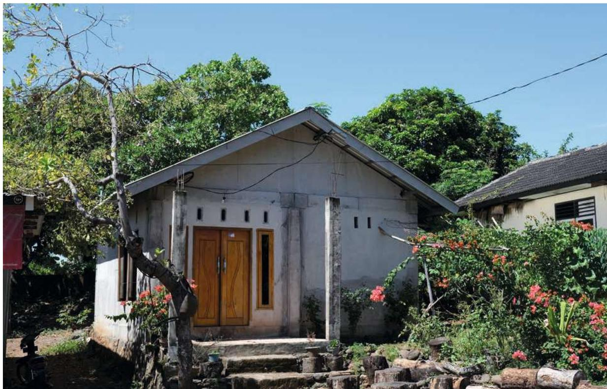
**Abbildung 95:** Der Wiederaufbautyp RISHA zeigt eine fehlerhafte Ausführung der Betonblöcke. Dabei wurde in der Mitte des Gebäudes eine herkömmliche Betonstütze verwendet, anstatt die vorgefertigten Komponenten entsprechend einzusetzen.
