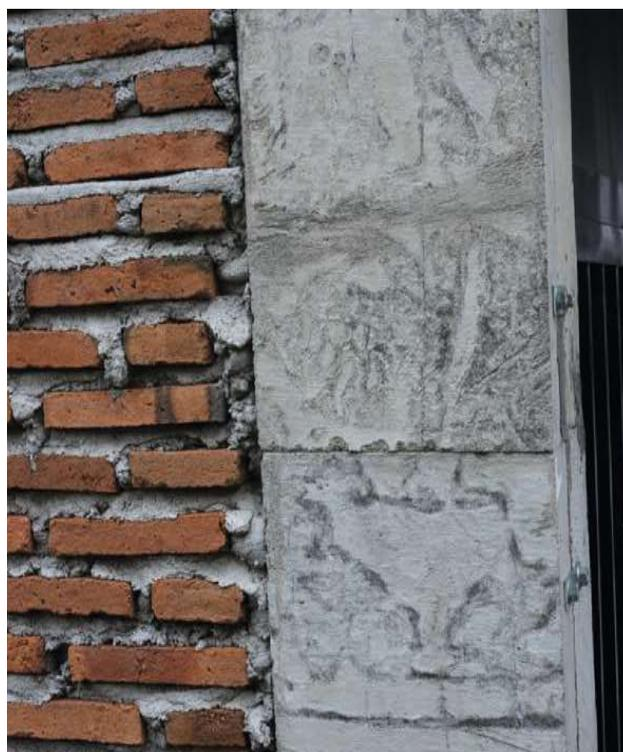
**Abbildung 96:** Wiederaufbautyp RISHA: Verbindung Stahlbetonkomponente mit Ziegelwand. Anordnung der Ziegel und Breiten der Fugen fehlerhaft
