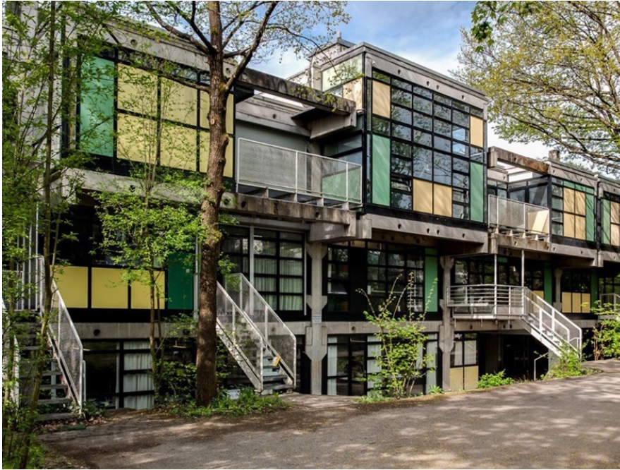
Bild 8: Eingangsfassade mit farbigen Fassadenpaneelen
