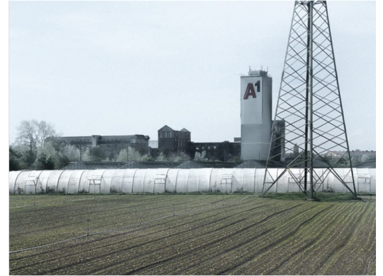
62 — Aus der Umgebung schon von Weitem zu erkennen – die beiden Silos und die Backsteingebäude der Hammerbrotwerke. Eigene Aufnahme, 2023.
