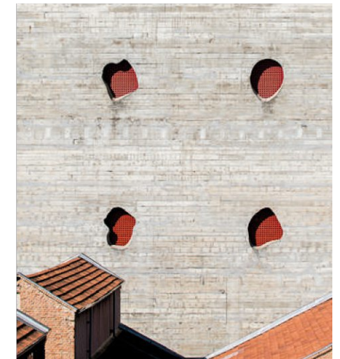
40 — Die organisch geformten Fenster und mit roten Detail sind ein Kontrast zum funktionalen Sichtbeton der Fassade. © Leonardo Finotti, Nelson Kon.
