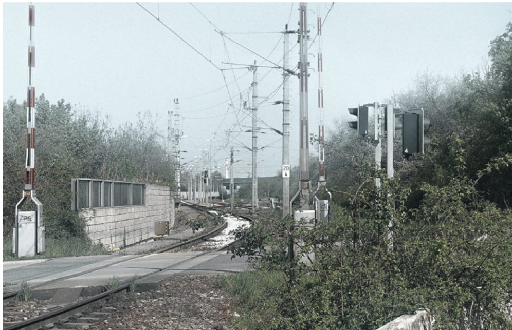
54 — Gleise verlaufen entlang der Grundstücksgrenze des Areals der Hammerbrotwerke. Eigene Aufnahme, 2023.
