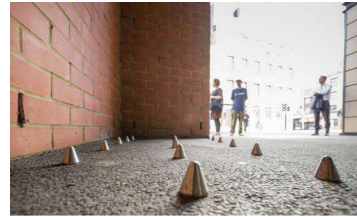
Abb. 2.4.4: „Spikes“ die aufhalten und schlafen vom Obdachlosen verhindern sollen
