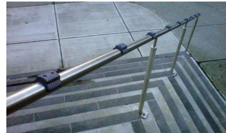
Abb. 2.4.5: Handlauf mit „Skatestoppers“ die skateboardfahren verhindern sollen
