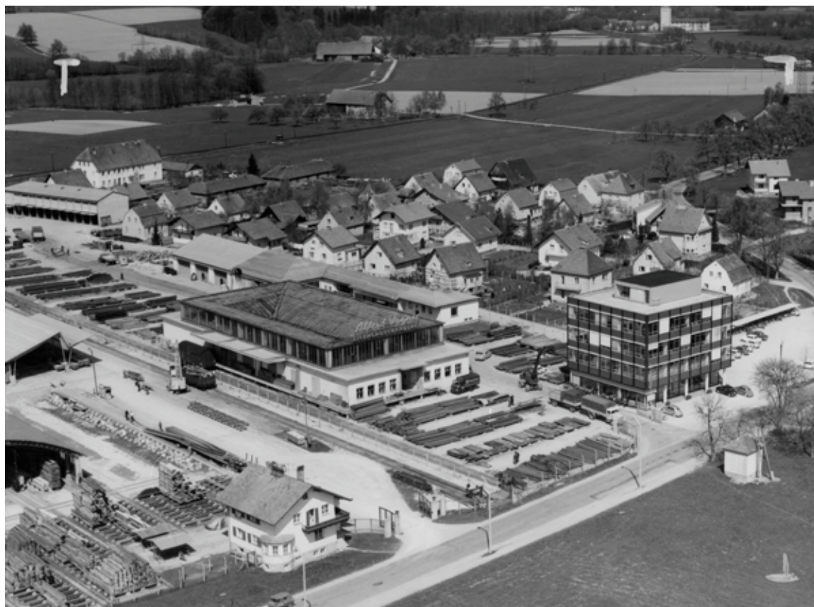
Abb. 50: Fenster- und Türenfabrik Wick & Söhne, Vorchdorf um 1967
