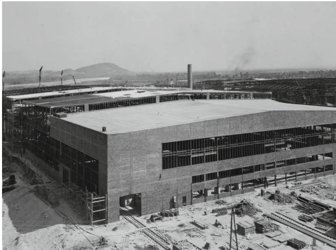
Abb. 25: Blechwalzwerk, Ostseite Schaltheus Nordseite, Foto 1942
