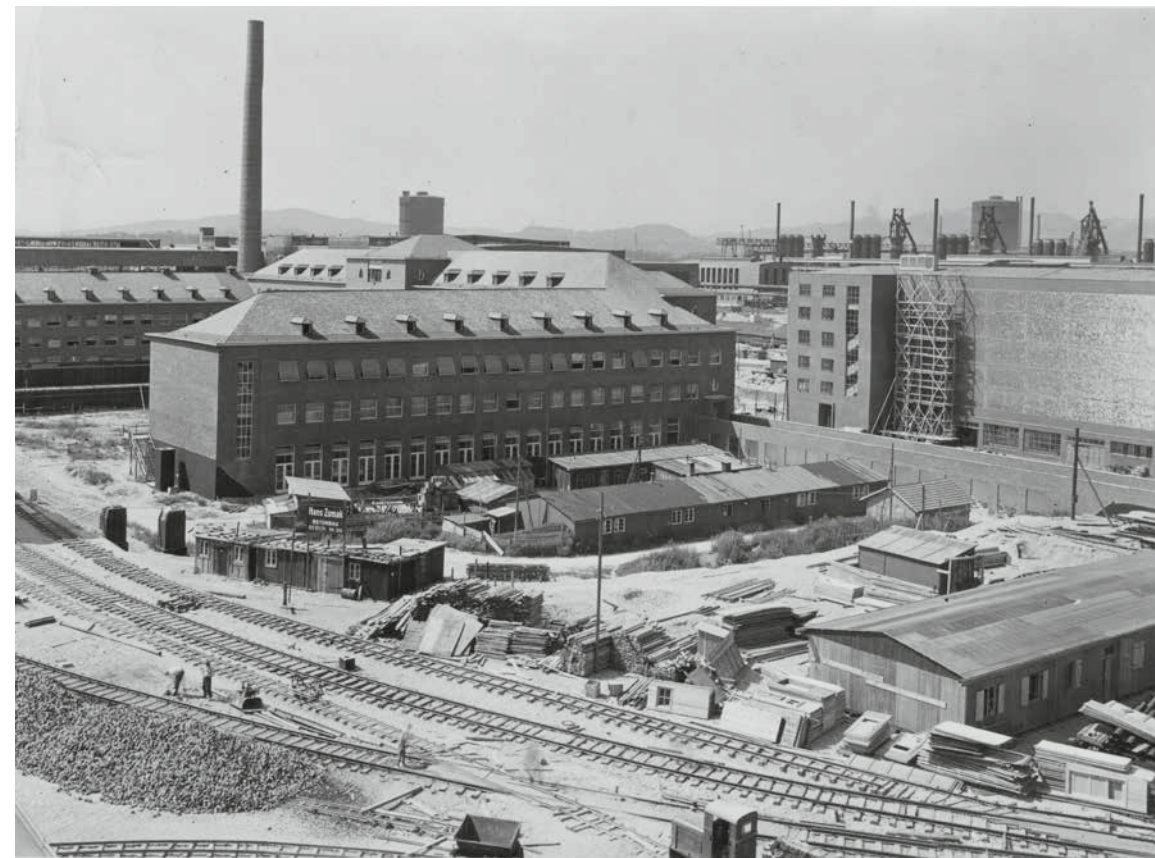
Abb. 22: Betriebsgebäude Ostseite und Schaltheus Südseite, 1942
