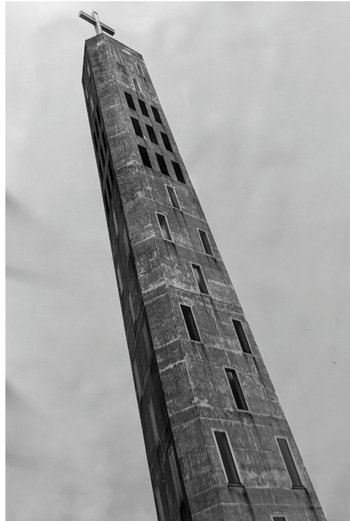
Abb. 229: Kirchturm Lenzing, Zustand vor 1985
