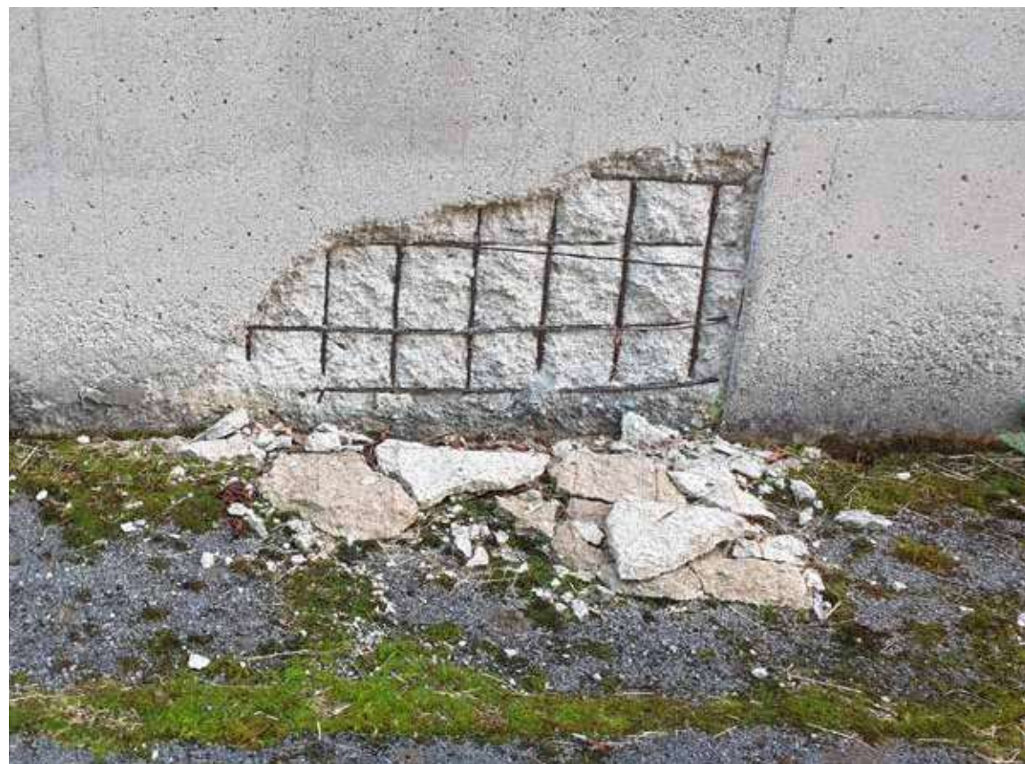
Abb. 232: Pfarrkirche Lenzing, Schäden Sichtbetonfassade, Zustand 2021
