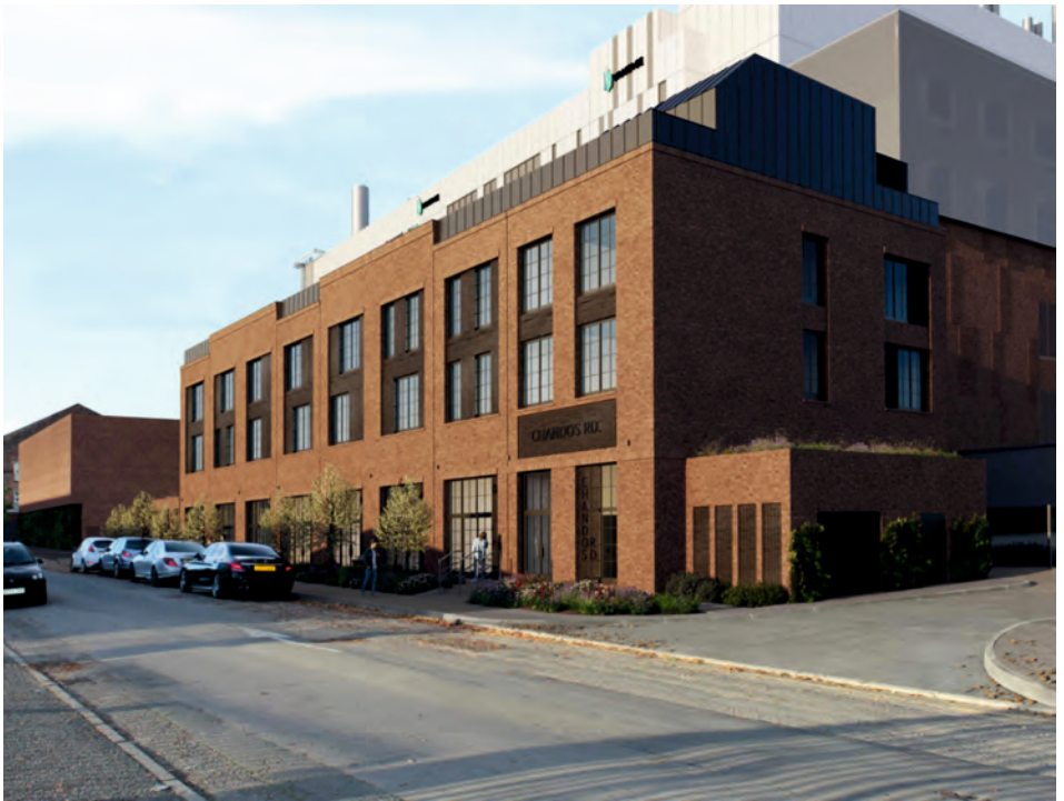
Abb. 10 Das Chandos Road Estate Rechenzentrum: Ein kleinteiliges Puffergebäude schirmt den öffentlichen Raum vom logistikintensiven Rechenzentrum ab. © Vantage Data Centers
