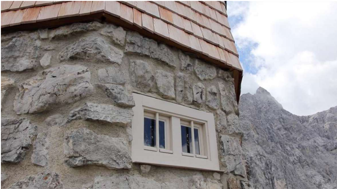
Abb. 2.11: Feldsteinmauerwerk der alten Falkenhütte vor Laliderer Wänden
