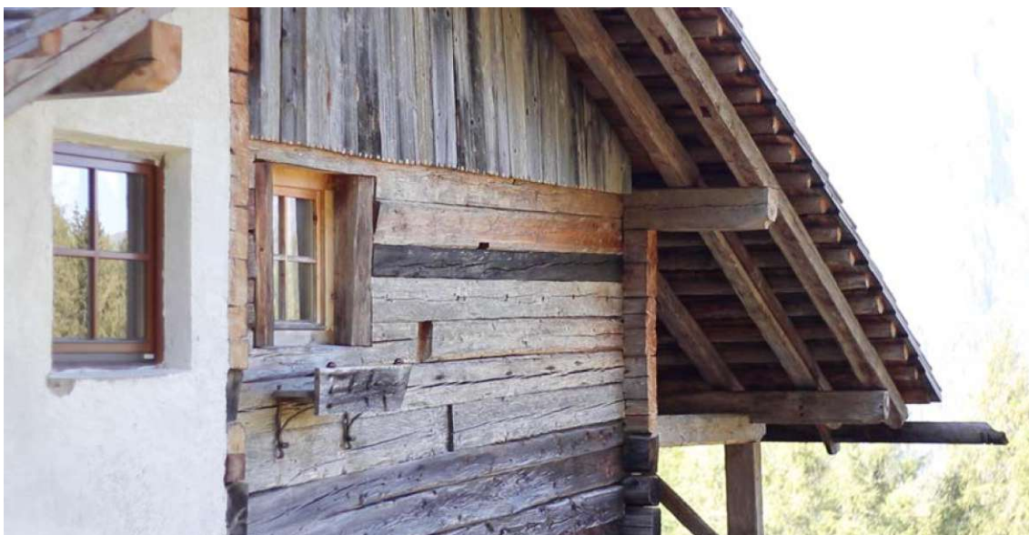
Abb. 1.16 (oben): Bergalm Munt Paschantadu / Abb. 1.17 (mitte): Ansicht Nord-Ost-Fassade / Abb. 1.18 (unten): Übergang Bestand zu Anbau
