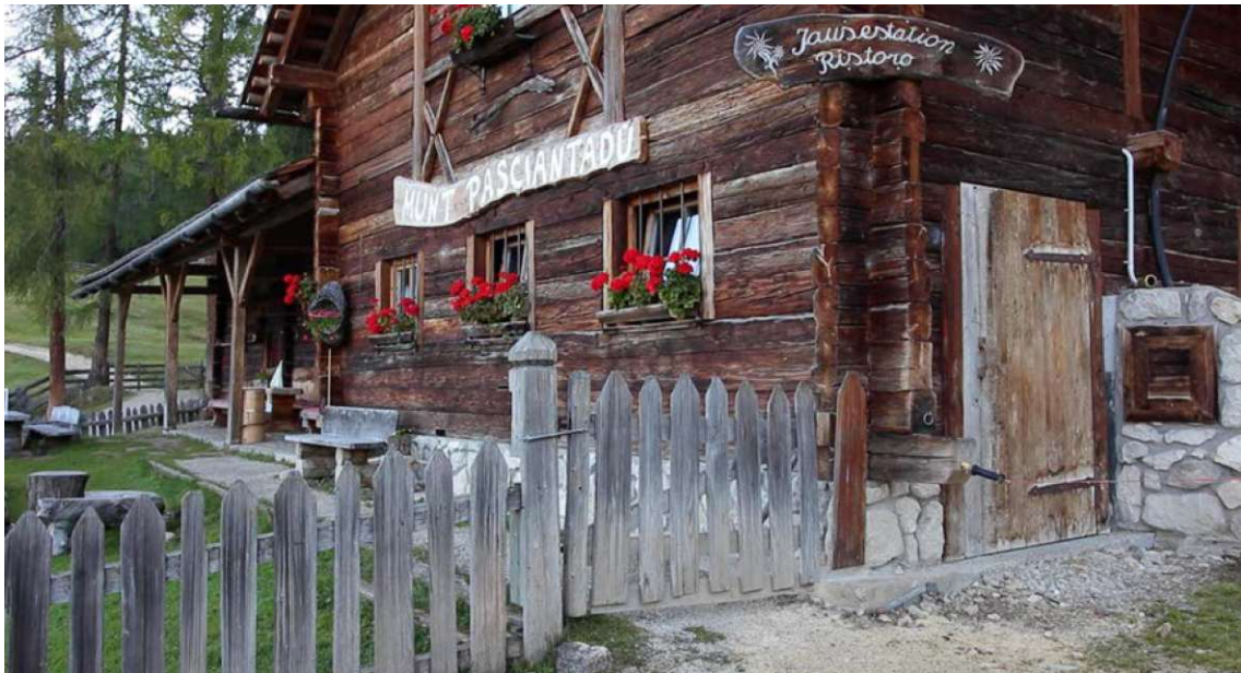
Abb. 1.22: neu aufgebauter Gebäudeteil als Blockbau aus Altholz
