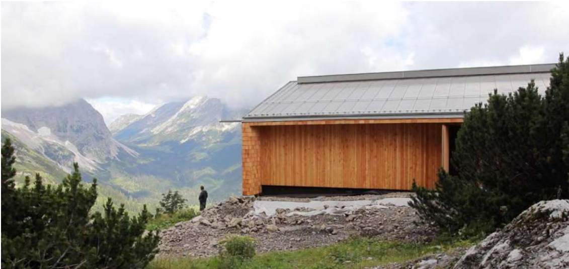
Abb. 2.13: witterungsgeschützte Eingangsnische mit vertikaler Lattung am Neubau des Horst-Wels-Hauses
