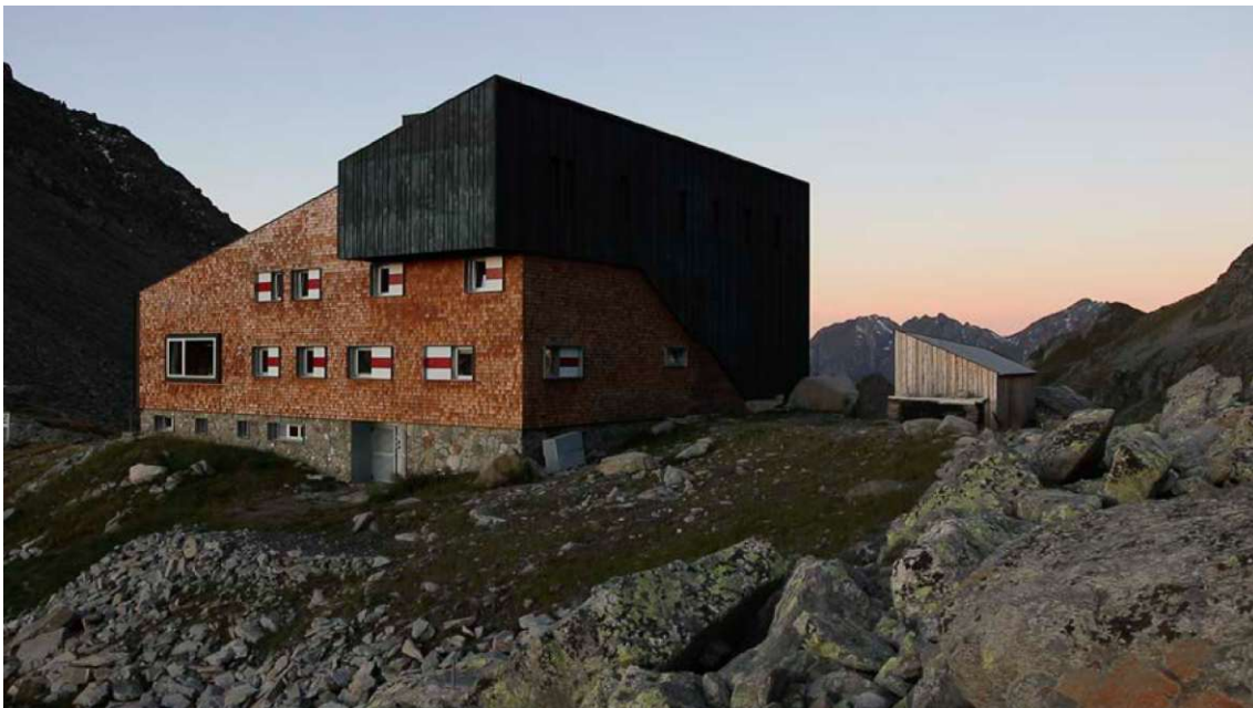
Abb. 2.22: geschlossene Nordfassade mit schwarzer Verblechung und Holzschindelung
