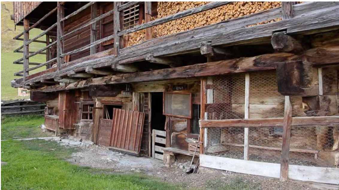
Abb. 1.4 (oben): Süd-West-Ansicht (Talseite) / Abb. 1.5 (unten): Stalltür im untersten Geschoss (Talseite)
