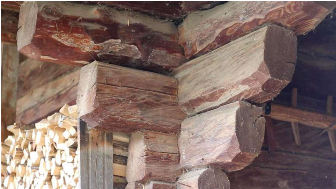
Abb. 1.8: Eckverbindung d. Blockbaus unter auskragendem Heuspäicher im obersten Geschoss
