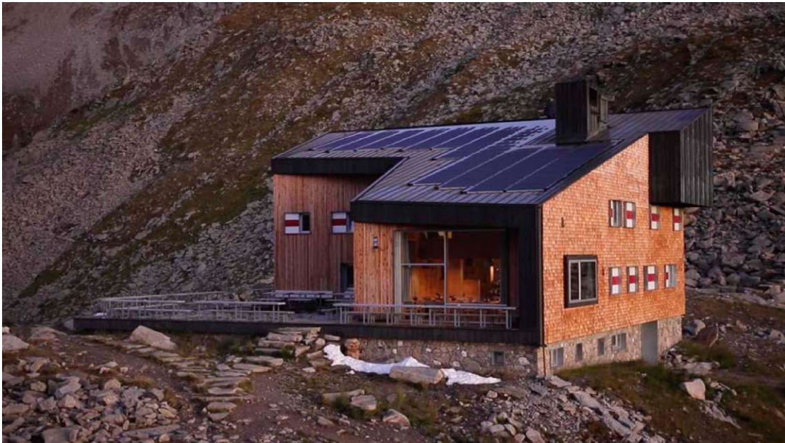
Abb. 2.23: geschlossene Schindelfassade an der Ostfassade, Terrasse mit vertikaler Lattung und großen Öffnungen im Süd-Westen
