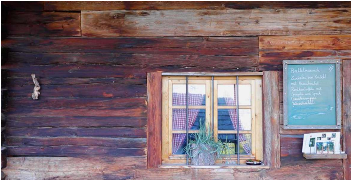
Abb. 1.24: Fassadenansicht, Übergang erhaltene Bestandsbalken zu neu angebauten Blockbau aus Altbolz
