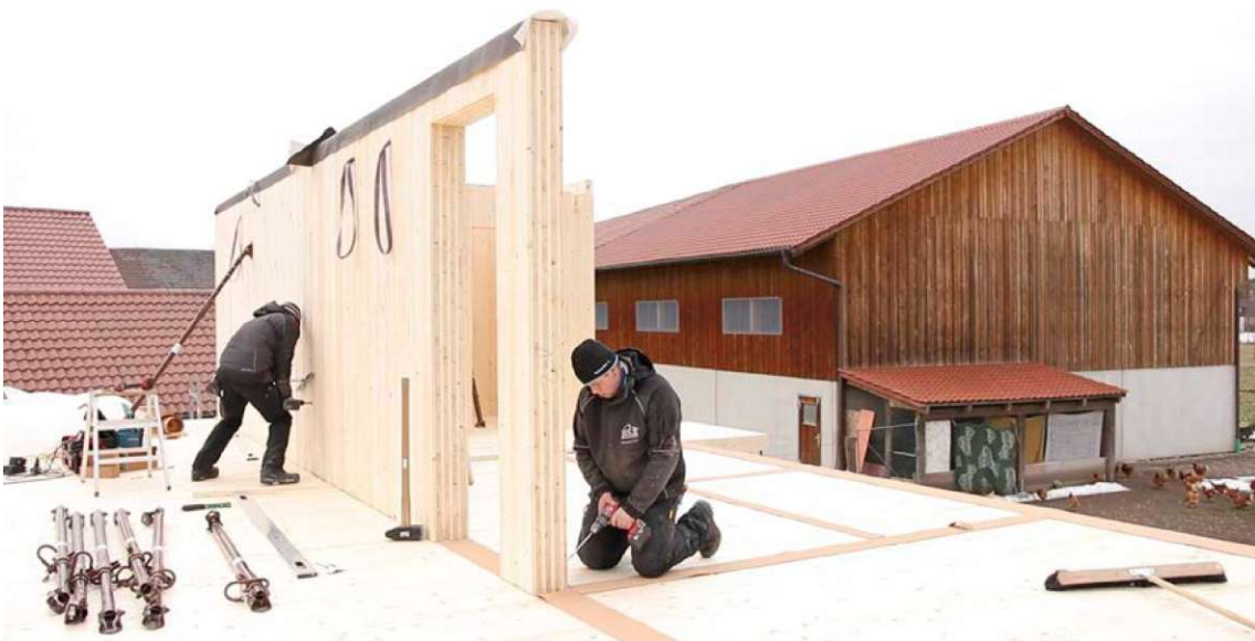
Abb. 3.9 (oben): Vorboren Wandelement; Abb. 3.10 (mitte) + Abb. 3.11 (unten): Ausrichtung Wandelement mit Kran und Montage auf BSH-Decke
