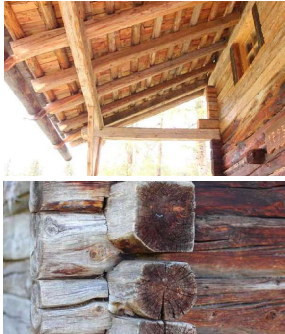
Abb. 1.19 (oben): Dachüberstand / Abb. 1.20 (unten): Eckverbindung Blockbau
