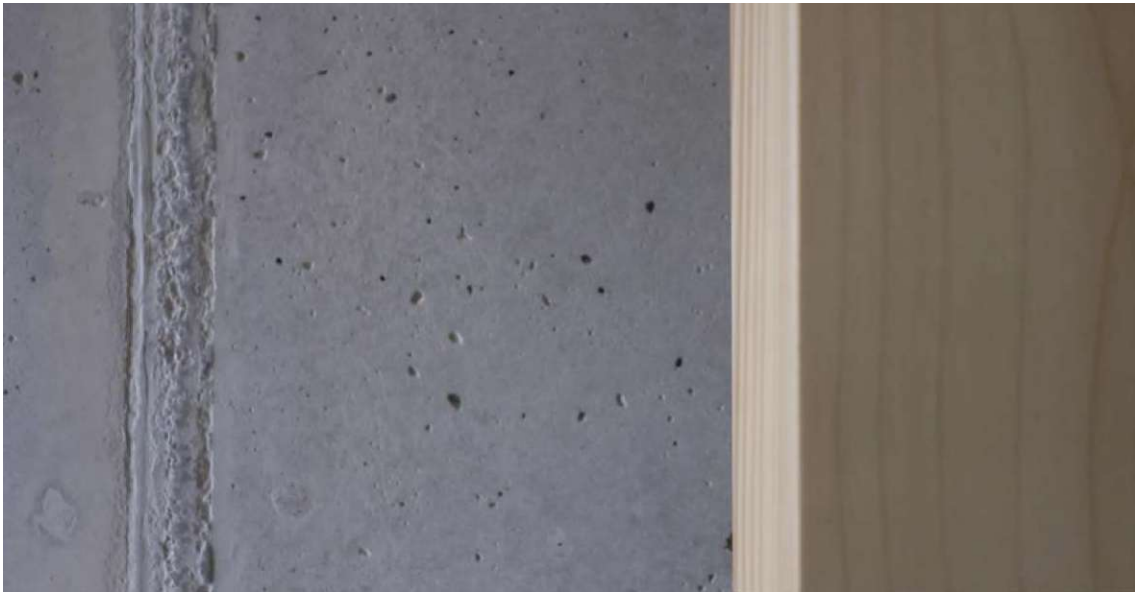
Abb. 2.14: Holzstür vor unbehandelter Sichtbetonwand im Neubau des Horst-Wels-Hauses
