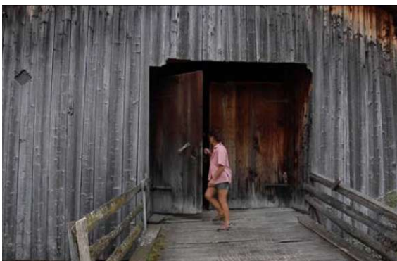
Abb. 1.3: Zugang zu Heuspeicher über Stadelbrücke im obersten Geschoss
