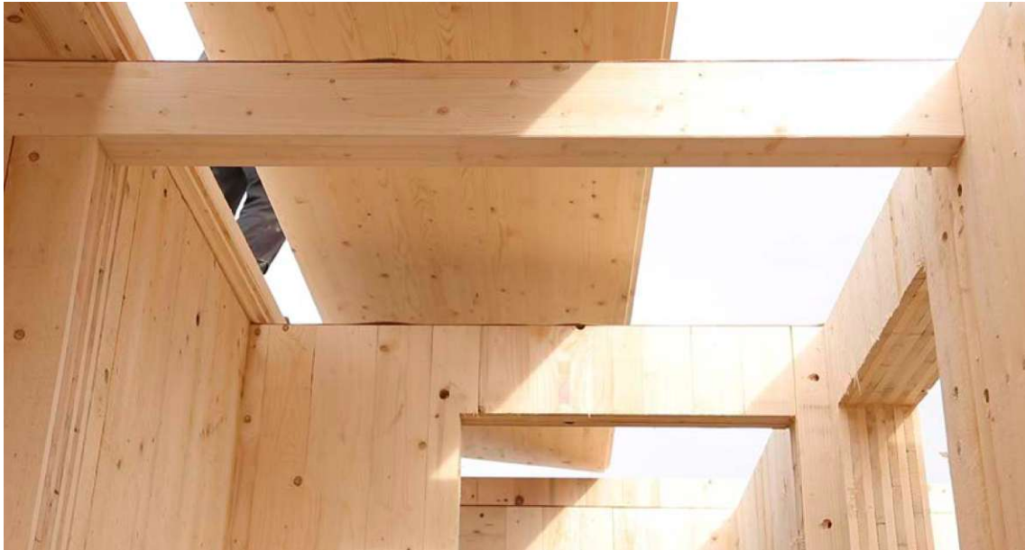
Abb. 3.12 (oben): Korkbahnen als Schalldämmung zwischen Wand- u. Deckenelement; Abb. 3.13 (mitte)+Abb. 3.14 (unten): Ausrichtung BSH-Deckenelement
