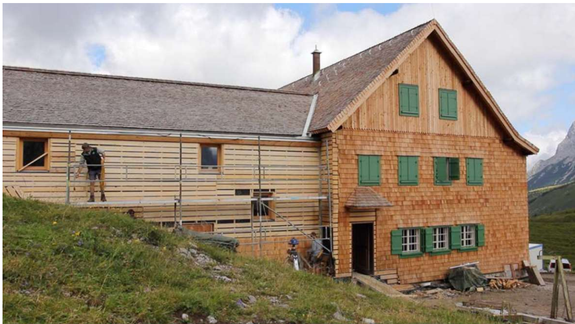
Abb. 2.7: Anbringen der Schindelung an dem neugestalteten Anbau
