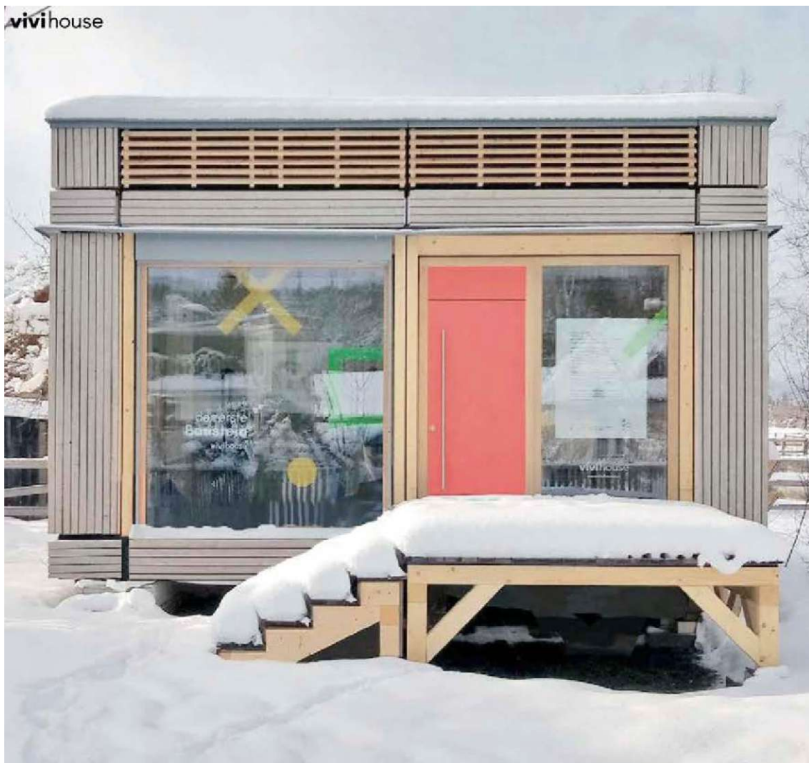
Abb. 3.22: Erster Prototyp in Pernitz; alle Bauteile wurden im zweiten Prototypen wiederverwendet; Quelle: vivihouse.cc
