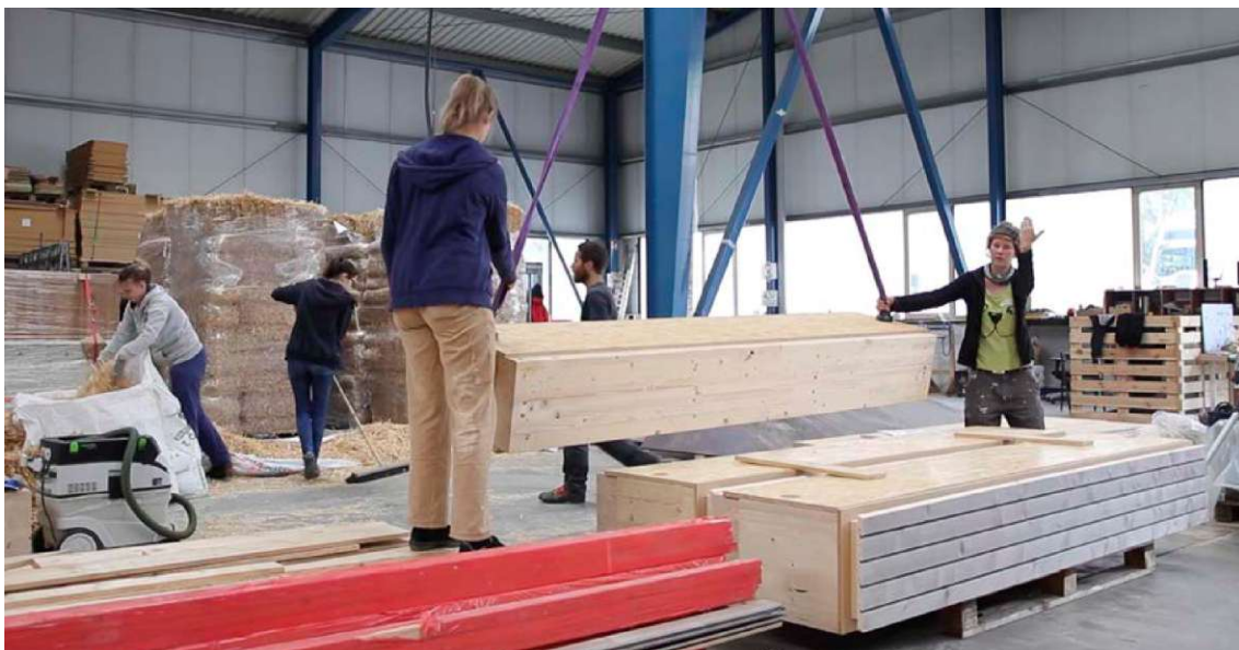
Abb. 3.17 (oben): Die Vorfabrikation in der Werkshalle bietet viele Vorteile: Wettergeschützte und voll ausgestattete Arbeitsplätze, Platz für Materiallagerung;
