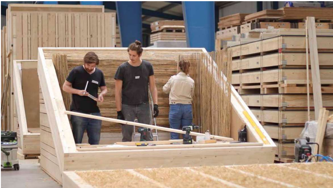
Abb. 3.19 (oben): Fenstereinbau: Demonstration der Fenstermontage durch eine Fachfirma; Abb. 3.20 (mitte): Fenstereinbau: Montage durch das virihouse-Team;; Abb. 3.21 (unten): Anbringen der Schilfmatten in einem Gaubenelement als Putzträger für den Lehmputz
