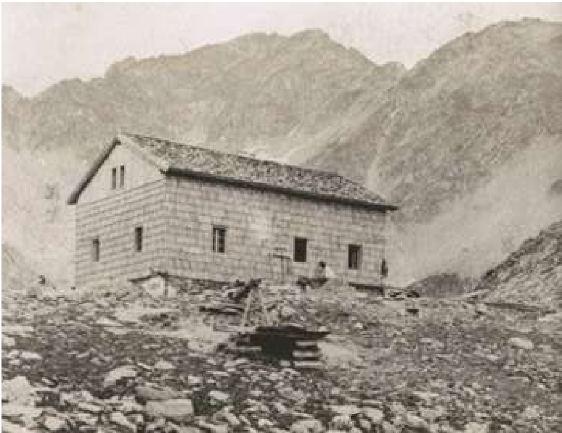
Abb. 2.16: Bau der Edelrauthütte am Eisbruggjoch, 1907
