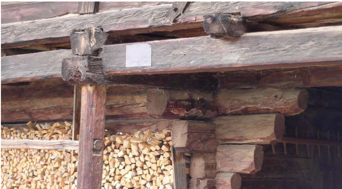
Abb. 1.13: Eckverbinding Blockbau mit darüberliegenden Deckenbalken des Heustadels im obersten Geschoss
