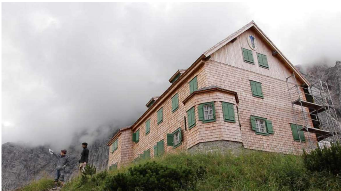
Abb. 2.6: neu geschindelte Nord-West-Ansicht der Falkenhütte
