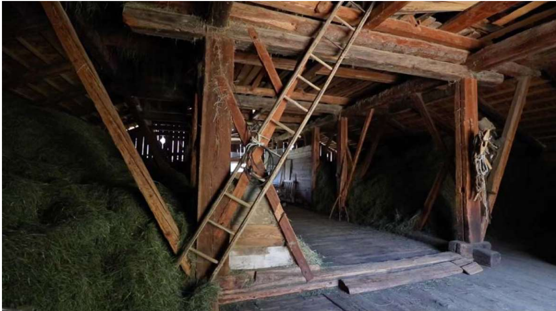
Abb. 1.12: Heuspeicher im obersten Geschoss mit handwerklich gefertigtem Dachstuhl
