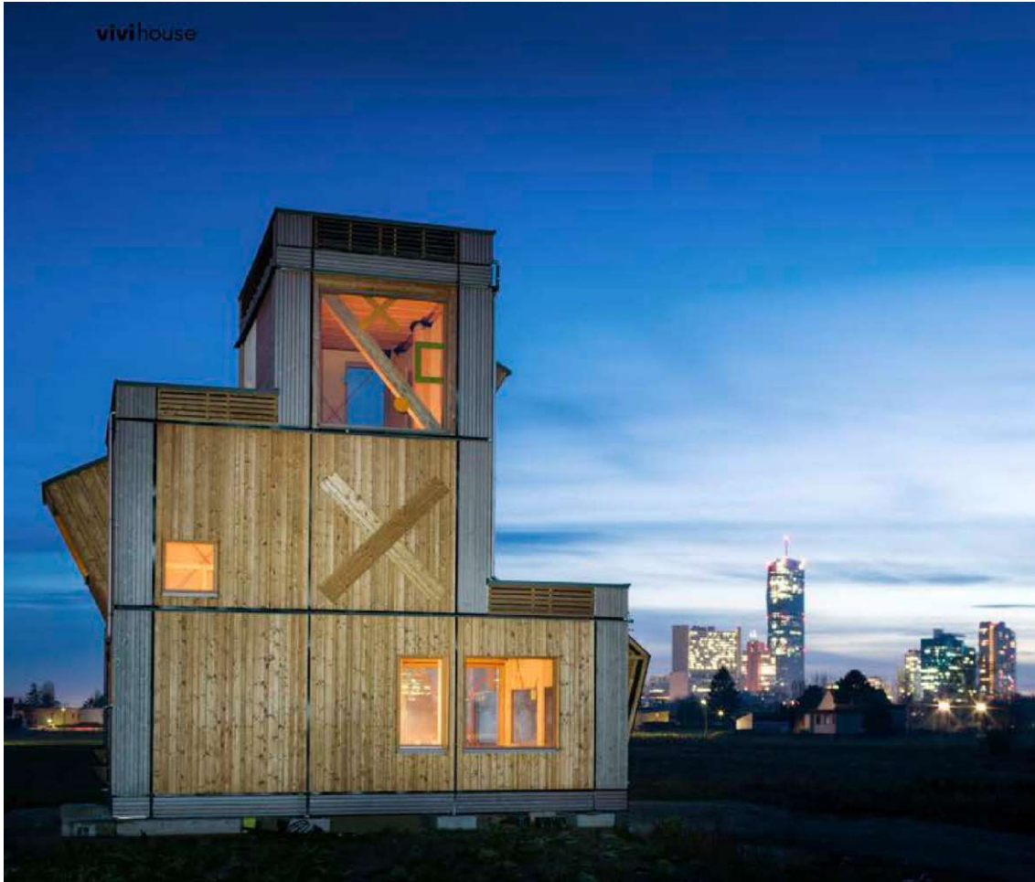
Abb. 3.23: Zweiter Prototyp in Wien: dreigeschossiger Bankkörper aus den vorgefertigten Elementen des dokumentierten Workshops; Quelle: vivihouse.cc
