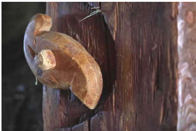
Abb. 1.6 (links): Holzverbindung im Dachtragwerk (Kopfband an Pfosten) / Abb. 1.7 (rechts): drehbarer Holzriegel im Heulager
