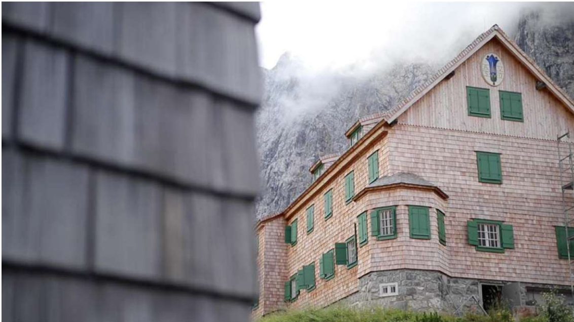
Abb. 2.12: vergraute Schindelung des alten Horst-Wels-Hauses vor noch junger Lärchenholz-fassade der Falkenhütte mit Laliderer Wänden im Hintergrund
