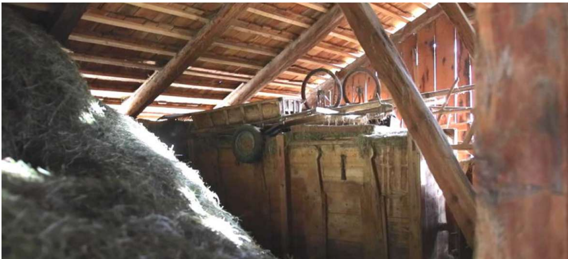
Abb. 1.9: luftdurchlässige senkrechte Bretterschalung an der Giebelseite d. obersten Geschosses
