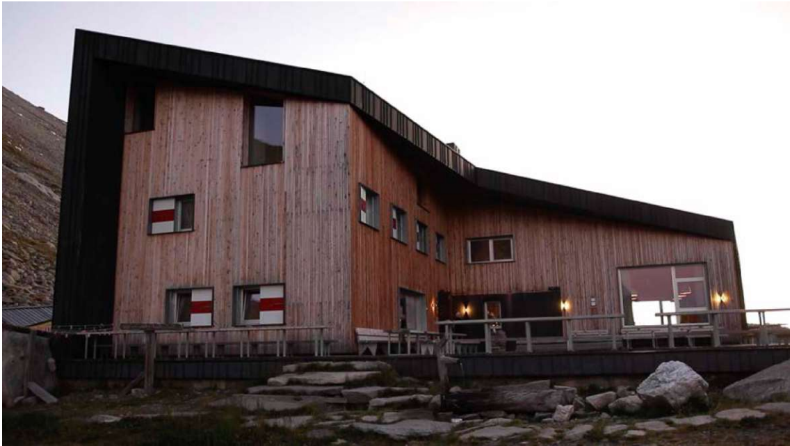
Abb. 2.24: Ansicht von Westen, Terrasse am Standort der alten Edelrauthütte
