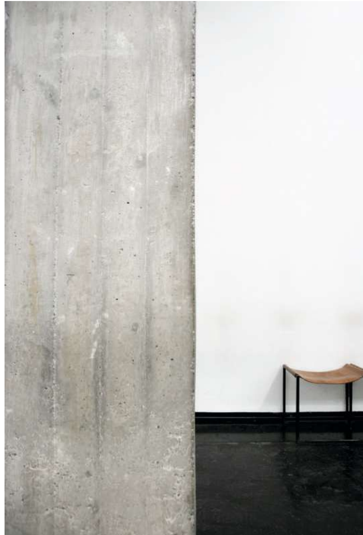
Abb. 36: Schalungsmuster Stützen
