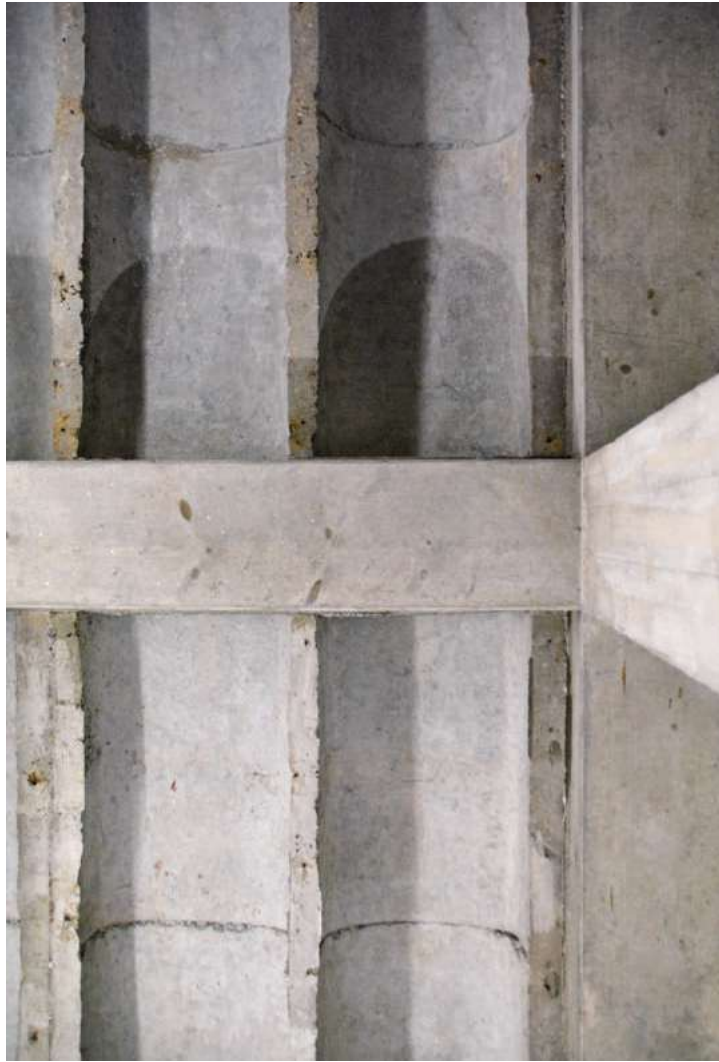
Abb. 37: Fügung Träger-Stütze-Decke
