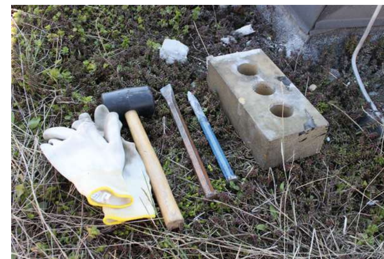
Abb 50: Beispielhafte Demontage eines Klinkerziegels mit Meißel und Hammer © Magdalena Klaus
