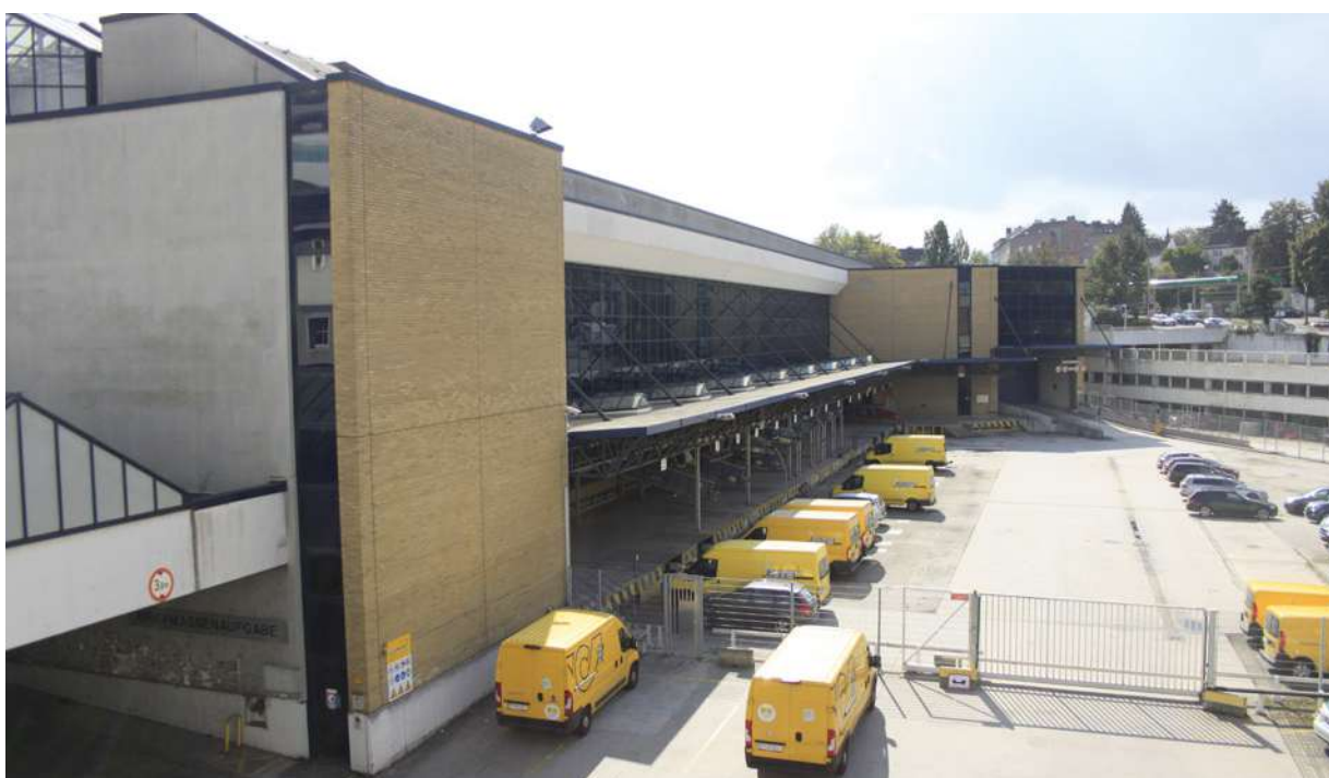
Abb 10: Blick auf die Hofseite des PVZs, bis 2014 haben hier LKWs und Kleinlaster die Sendungen vom Verteilerzentrum übernommen. Jetzt ist der Hof ein Parkplatz für die Postlieferwagen. Aufgenommen aus den Büroräumlichkeiten des Altbaus. © Magdalena Klaus
