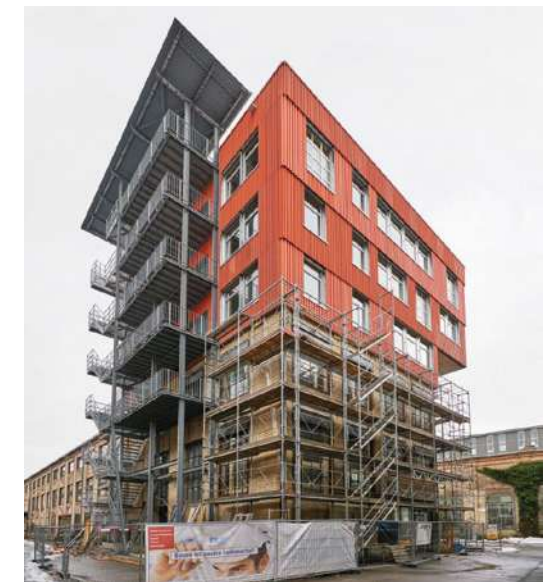
Abb 67 - 70: Eines der wiedervereingebauten Bauteilen in das Projekt K 118 sind gebrauchten Stahlträger, auch Fenster und eine rote Wellblechfassade wurde in dem Projekt vor der Entsorgung bewahrt. Quelle: Foto von Martin Zeller, https://www.insitu.ch/projekte/196-k-118 , Zugriff 25.9.21
