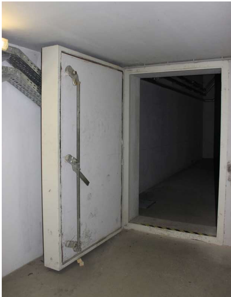
Abb 31: PVZ 1. UG, Eingangstür zum Schutzbunker. © Magdalena Klaus
