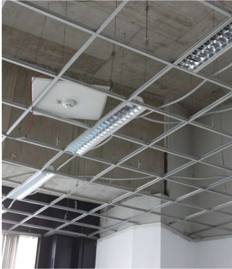
Abb 27: PVZ Büros 1. OG, demontierte abgehängte Decke. © Magdalena Klaus
