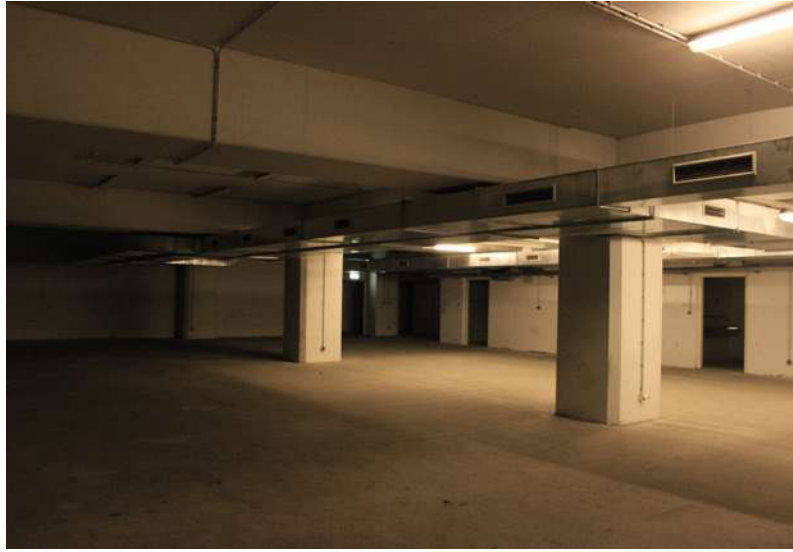
Abb 30: PVZ 1. UG, Schutzbunker. © Magdalena Klaus
