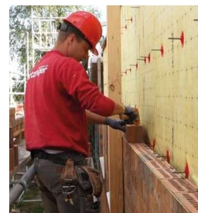
Abb 65: Einbau des ClickBrick Systems von Wienerberger Ziegel., Quelle: https://www.wienerberger.nl/en/clickbrick.html Zugriff 25.9.21
