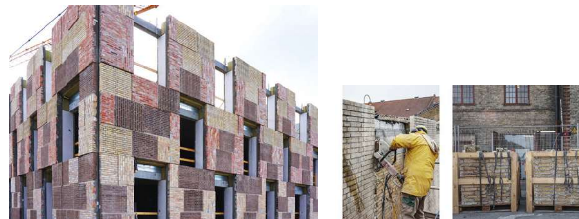
Abb 62 - 64: Wiederverwendung der historischen Klinkerfassade der Carlsberg Brauerei in dem Projekt „The Resource Rows“ in Ørestad, Dänemark, 2019. Quelle: https://lendager.com/en/architecture/the-resource-rows/ , Zugriff 25.9.21
