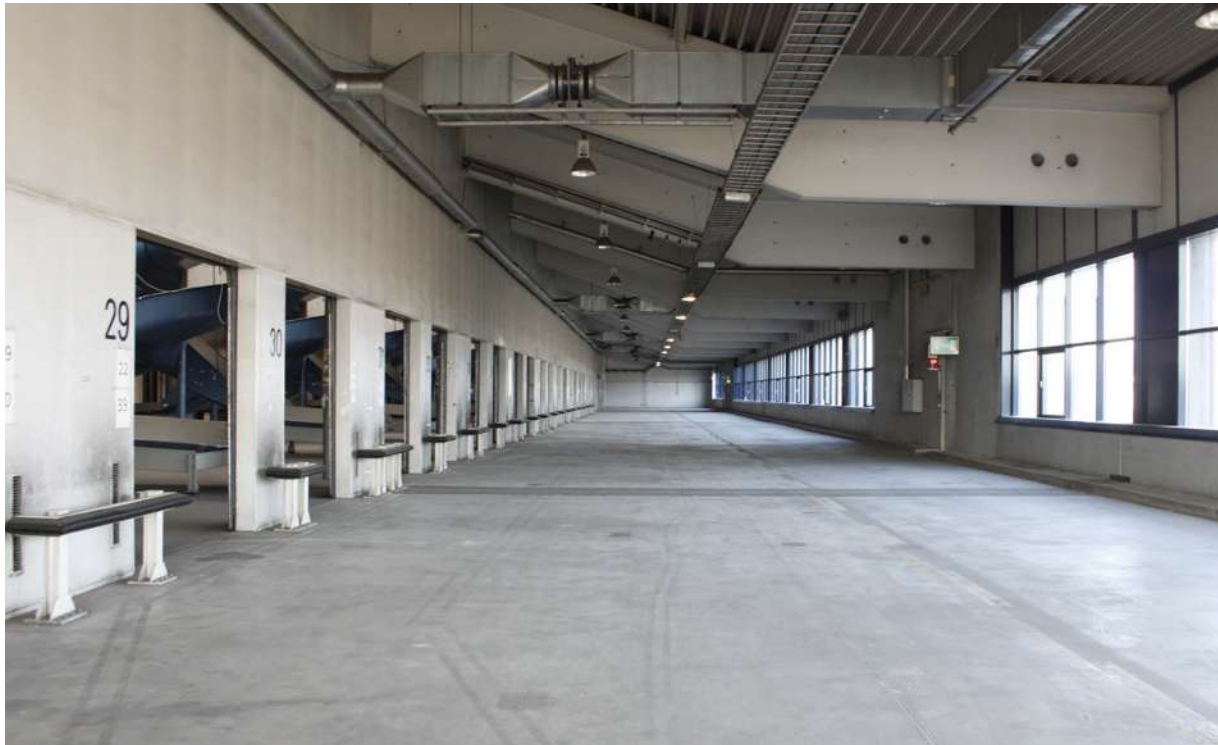
Abb 23: Die Paketzustellung im 1. OG kann wie eine Straße befahren werden. Durch die Glasfassade fällt der Blick in Richtung der Gleiskörper des Linzer Bahnhofes. © Magdalena Klaus
