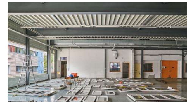
Abb 67 - 70: Eines der wiedervereingebauten Bauteilen in das Projekt K 118 sind gebrauchten Stahlträger, auch Fenster und eine rote Wellblechfassade wurde in dem Projekt vor der Entsorgung bewahrt. Quelle: Foto von Martin Zeller, https://www.insitu.ch/projekte/196-k-118 , Zugriff 25.9.21
