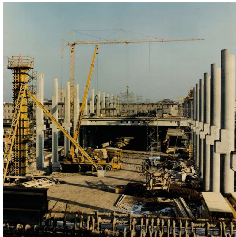
Abb 12: Baustellenfoto des PVZs, Aufnahmedatum ca 1992, Fotograf.in unbekannt, gescannt am 23.3.21
