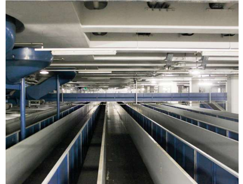
Abb 32: PVZ 2. UG, Paketspeicherhalle. © Magdalena Klaus
