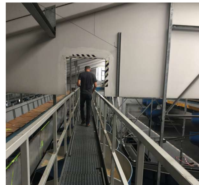
Abb 40: Das Gebäude kennenlernen und einen Überblick verschaffen. © Magdalena Klaus Danke an die Immobilienverwaltung für die Orientierungshilfe.
