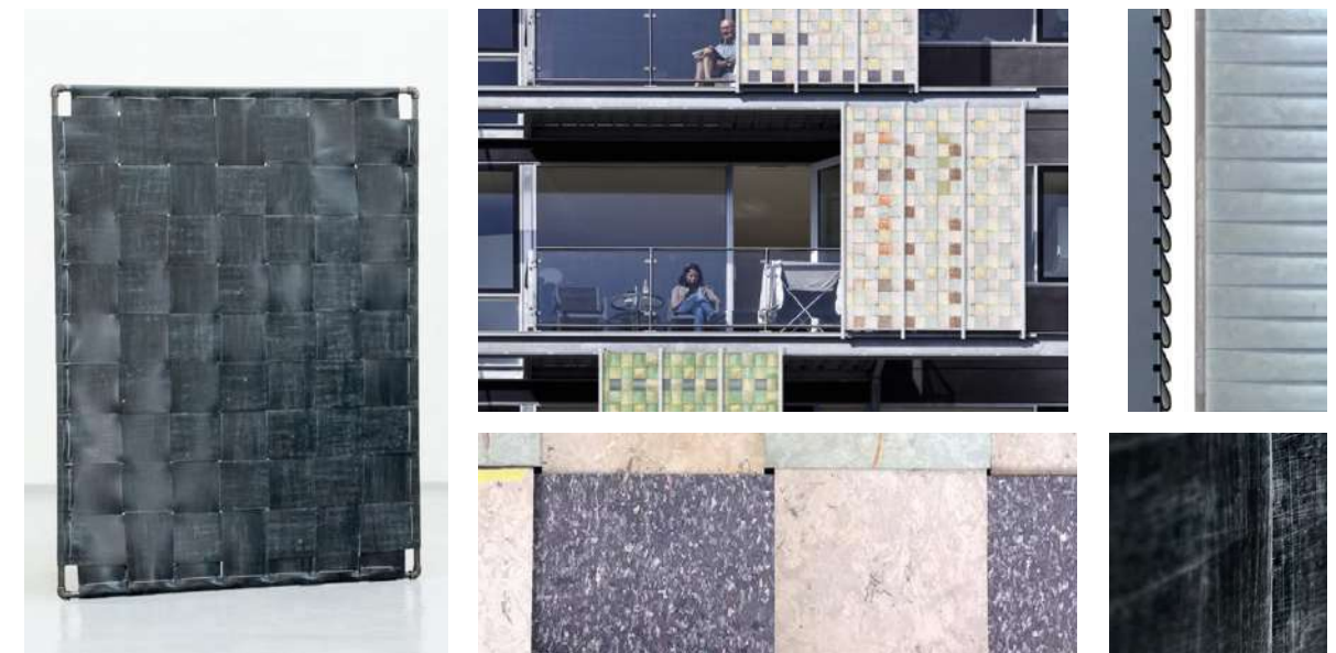
Abb : Rückgebaute Vinylböden wurden zu Fassadenbekleidungen umgestaltet. Quelle: https://vankunsten.com/en/news/reauty-new-report , Zugriff 13.5.21
