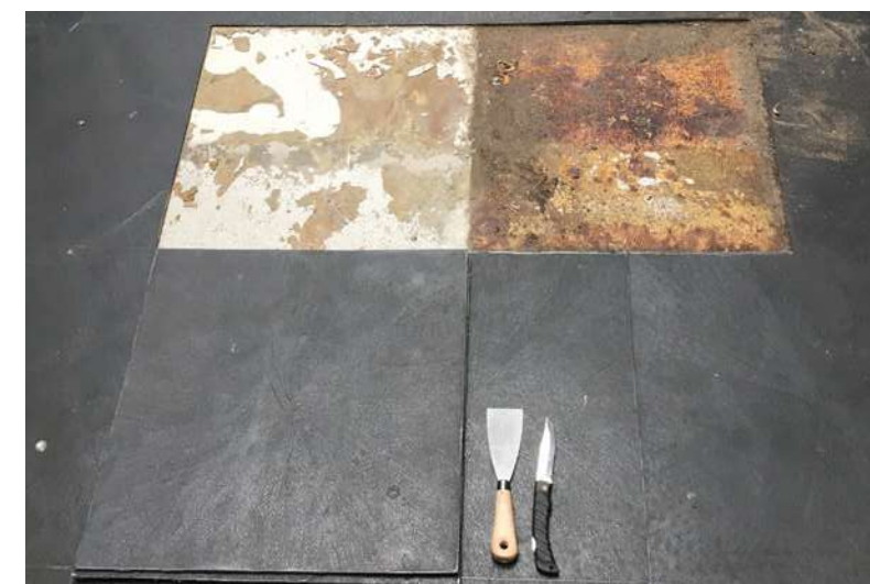
Abb 48: Beispielhafte Demontage des Stelcon Bodenbelages mit einem Messer und einer Spachtel. © Magdalena Klaus
