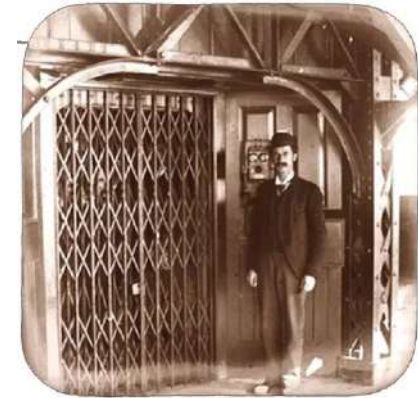
Abb.42: Erster absturzsicherer Aufzug
