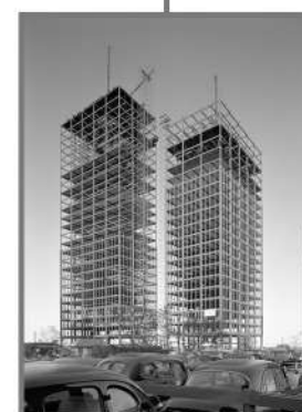
Abb.33: Lake Shore Drive Apartments Architekt: Ludwig Mies van der Rohe
