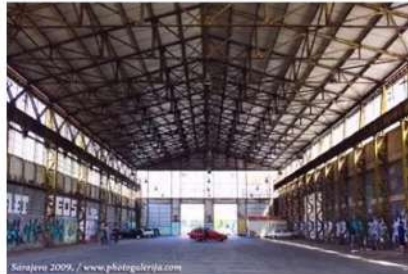
Abb.53: Innenansicht des Komplexes VMC
