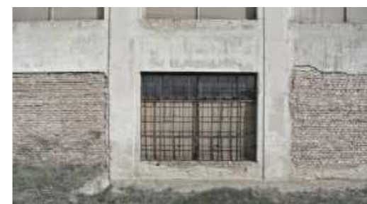
Fassoneisenfenster mit dahinterliegendem Provisorium
