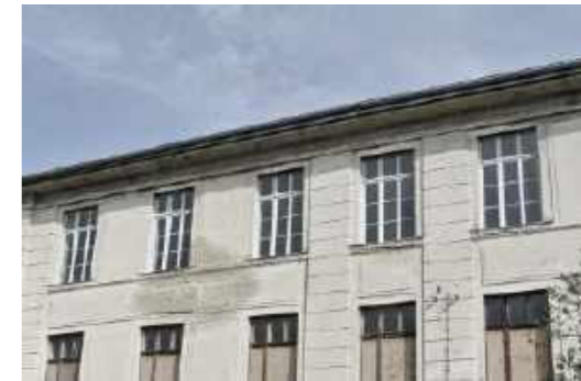
Neue Fensterelemente an der Südfassade
