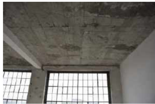
Untersicht unverputzte Eisenbeton-Hohlkammerdecke
