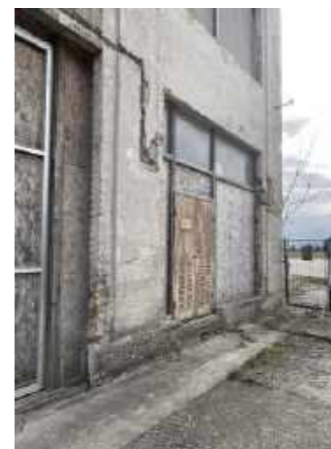
Zugang Traforaum außen
