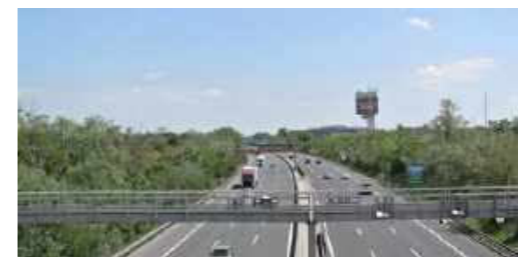
Abb. 16 A4-Ostautobahn beim Flughafen
