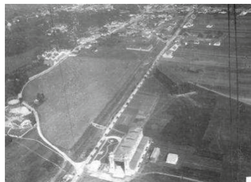
Abb. 32 Baubeginn der Anlage um 1909/1910
