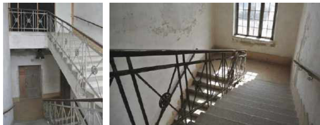
Abb. 328-329 Bauzeitliche Absturzsicherung und originalhistorische Beläge in den Stiegenhäusern
