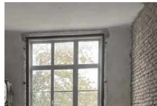
Neues Fensterelement in Nordfassade
