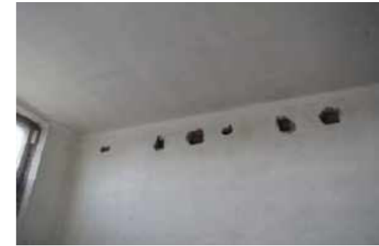
Löcher in westlicher Außenmauer
