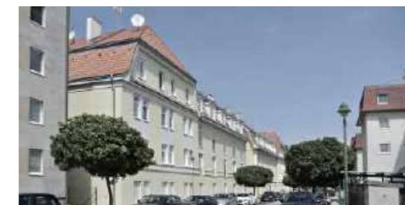
Abb. 188 Heutige Wohnhausanlage Dr. Karl Renner-Straße
