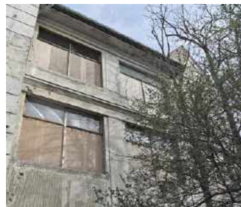
Abb. 214 Neue Fensteröffnung (mittig oben)
