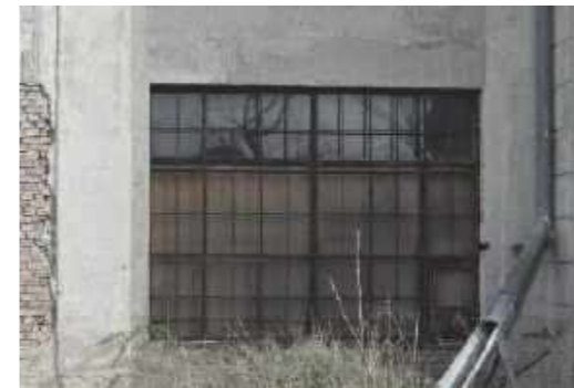
Fassoneisenfenster mit dahinterliegendem Provisorium
