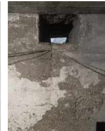
Wanddurchbruch ins Erdgeschoss
