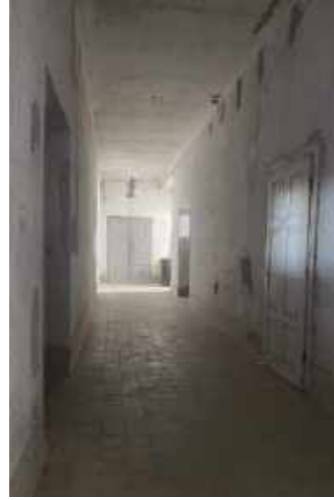
Gangbereich Richtung Osten
