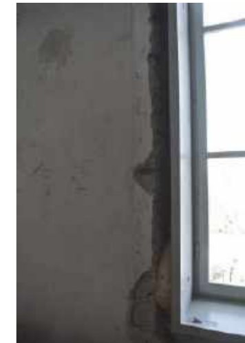
Einbringen neuer Fensterelemente
