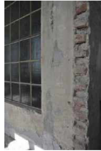
Reste ehemaliger Trennwände
