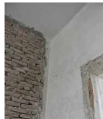
Sichtziegel und Putzwände
