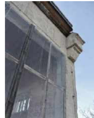
Geteilte Glasfront mit Holzrahmen
