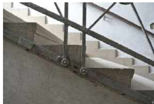
Bauzeitliches Geländer und Granittreppen
