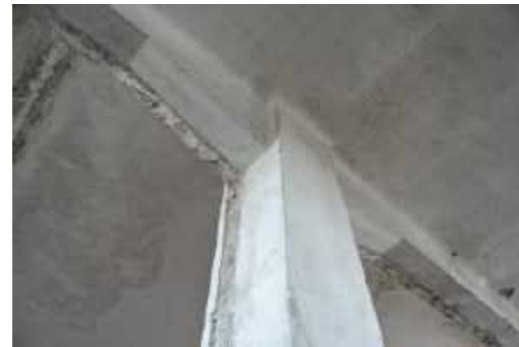
Spuren ehemaliger Trennwände an Oberflächen
