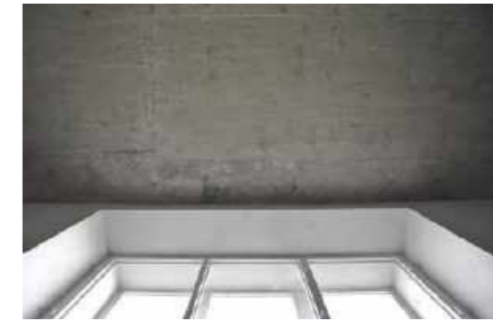
Untersicht Decke/bauzeitliches Fensterelement
