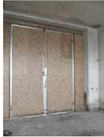
Provisorisches Einfahrtstor innen
