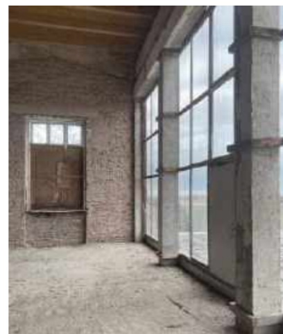
Abb. 212 Neue Stütze (mittig im Bild)
