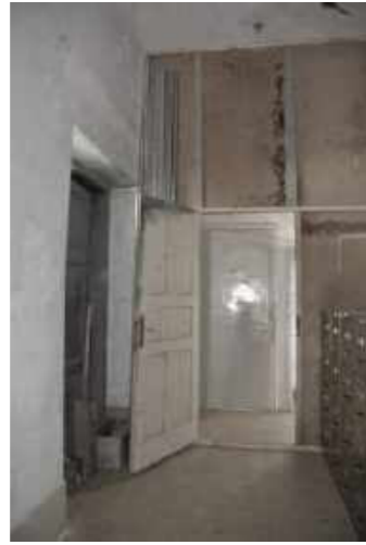
Provisorische Trennwand im Osten
