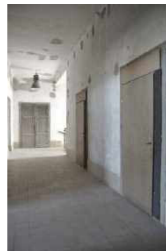
Provisorischer Zugang (rechts)
