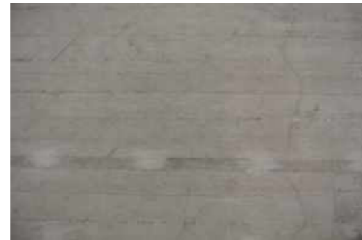
Untersicht unverputzte Eisenbeton-Hohlkammerdecke
