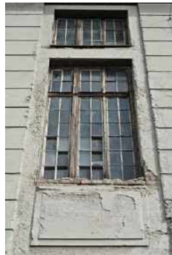
Holzrahmenfenster von außen
