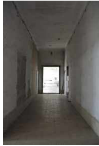
Gangbereich Richtung Westen
