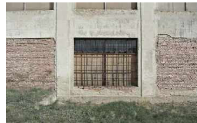
Abb. 215 Vermauerte Fensteröffnungen (l. u. r.)
