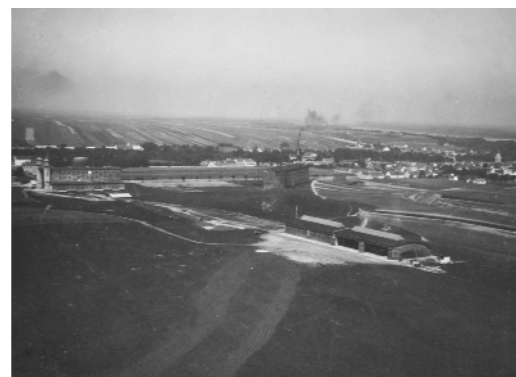
Abb. 33 Baubeginn der Anlage um 1909/1910
