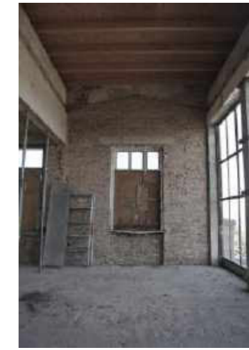
Bauzeitliches Fensterelement Nord
