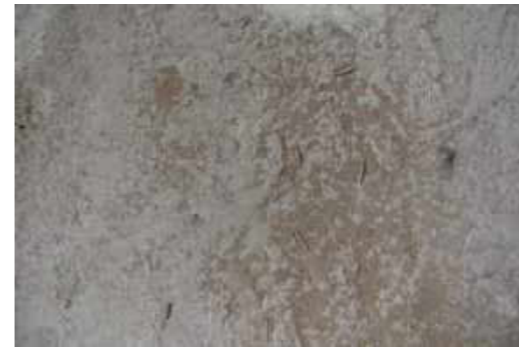
Sichtbare Oberkante der Rohdecke
