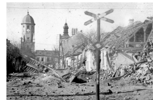
Abb. 185 Ausmaß der Zerstörung Fischamends
