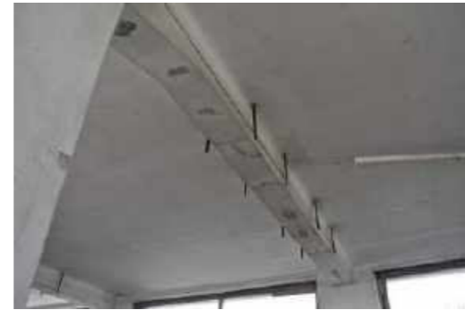
Eisenbetonträger und Voutenausbildung
