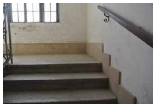
Granittreppen und Feinklinkerplattenpflaster
