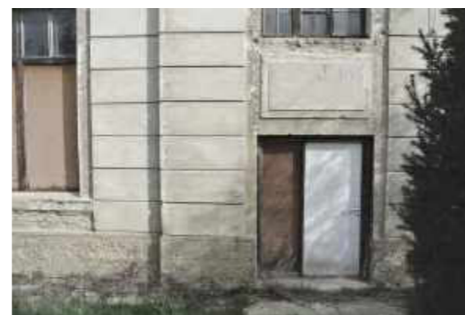
Ehemaliger Südzugang zum Stiegenhaus von außen
