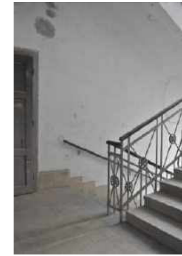
Gangbereich und Stiegenraum Ost
