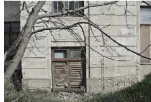
Ehemaliger Südzugang zum Stiegenhaus von außen
