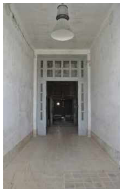
Abb. 248 Eingangsbereich und Aufzug
