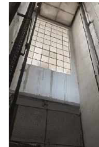
Schacht mit Fensteröffnungen
