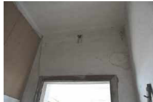
Bauzeitlicher Holzrahmenstock zu DG-04
