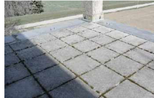
Betonsteinplatten als Bodenbelag
