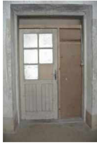
Bauzeitliche Tür in Provisorium
