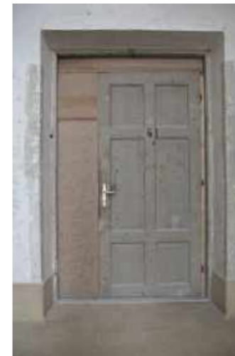
Bauzeitliche Tür in Provisorium
