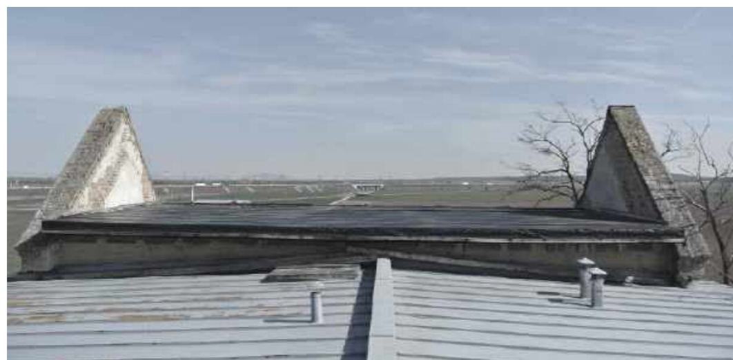
Abb. 231 Erhaltene Giebelwände aus Ziegelmauerwerk und temporäre Eindeckung
