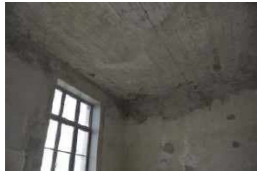
Ausbesserungsarbeiten an Wänden und Decken
