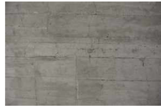
Untersicht unverputzte Eisenbeton-Hohlkammerdecke
