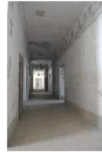
Gangbereich Richtung Westen
