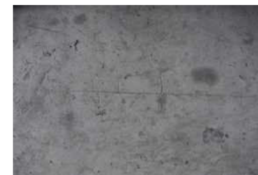
Bauzeitlicher Bodenbelag „Feuertrotz“
