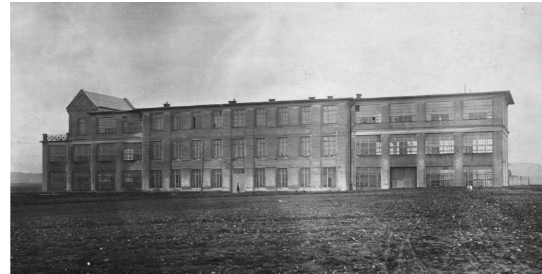
Abb. 203 Historische Aufnahme der dreigeschossigen Massivkonstruktion am Flugfeld
