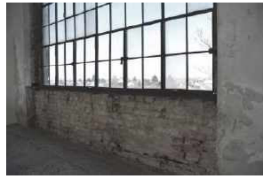
Sichtmauerwerk in Heizkörpernischen
