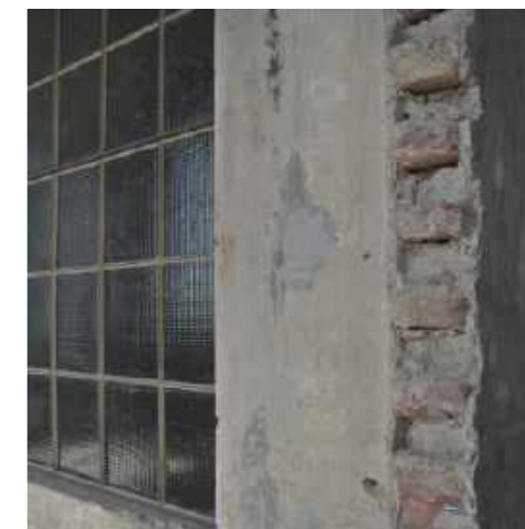
Abb. 211 Spuren abgebrochener Zwischenwände
