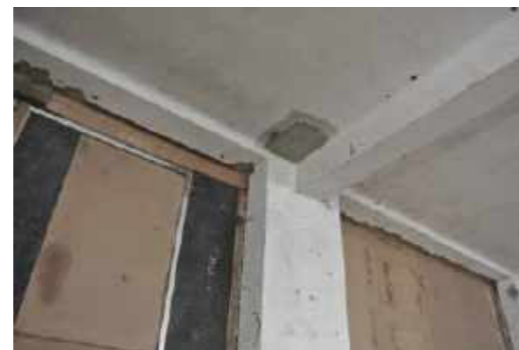
Provisorisches Einfahrtstor innen
