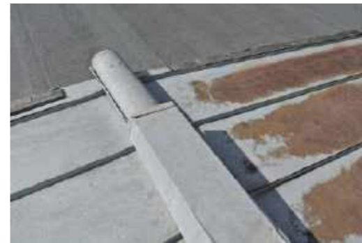
Bestehende Dachentwässerung des Mitteltrakts
