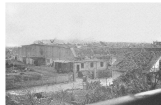
Abb. 184 Ausmaß der Zerstörung Fischamends
