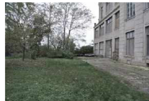
Nordfassade mit provisorischem Einfahrtstor
