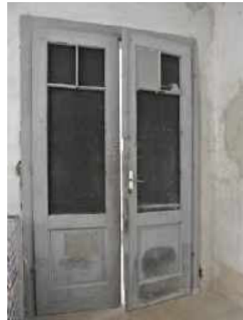
Bauzeitliches Türelement außen
