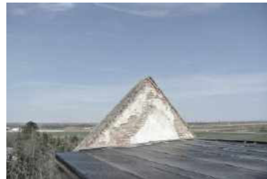
Bauzeitliche Giebelwände über dem Osttrakt
