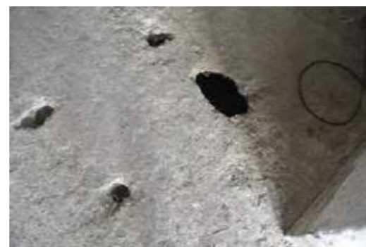
Ehemalige Verbindungen zum Kollektorgang (KG-01)
