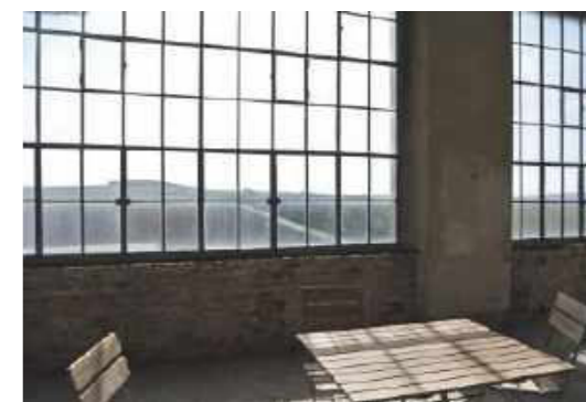
Abb. 288 Bauzeitliche Eisensprossenfenster
