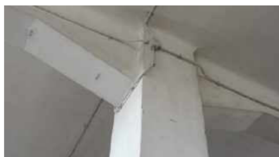
Abb. 244 Eisenbetonstützen mit Voutenausbildung
