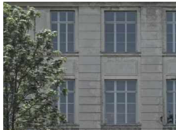
Abb. 217 Neue Kastenfenster an der Nordfassade (1. u. 2. OG)
