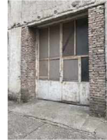
Provisorisches Einfahrtstor außen
