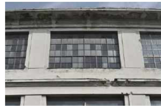
Außenansicht der bauzeitlichen Fassoneisenfenster
