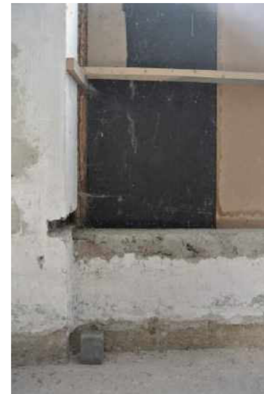
Ausbetonierte Fensterbank innen
