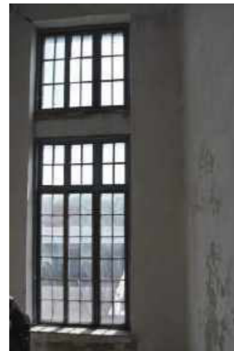
Holzrahmenfenster von innen
