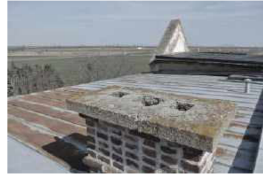
Massiver Rauchfang aus Ziegelmauerwerk
