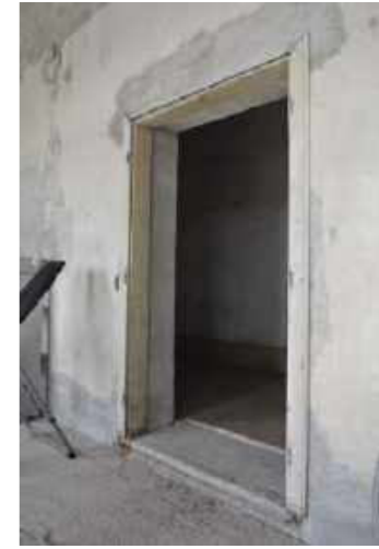
Bauzeitlicher Holzrahmenstock
