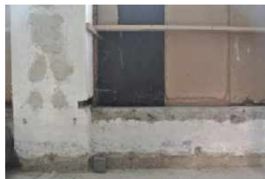
Ausbetonierte Fensterbank innen
