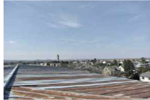
Blecheindeckung mit Gefälle über Mitteltrakt
