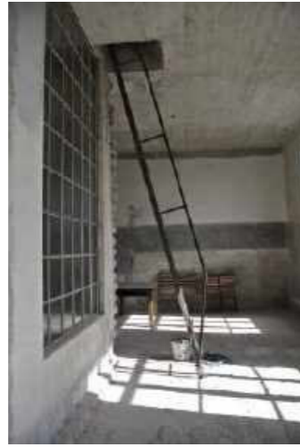
Dachausstieg mit Eisentreppe
