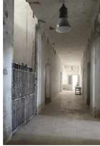
Gangbereich Richtung Westen
