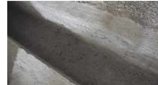
Betonwanne im Boden eingelassen
