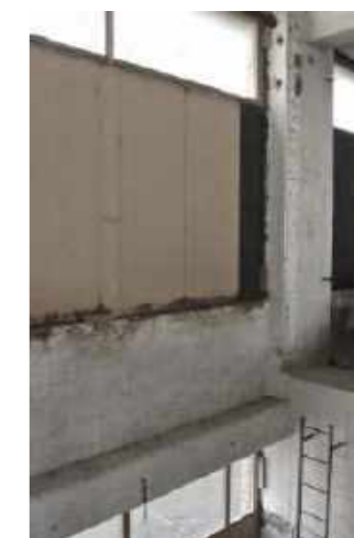
Fensterelement über Traforaum
