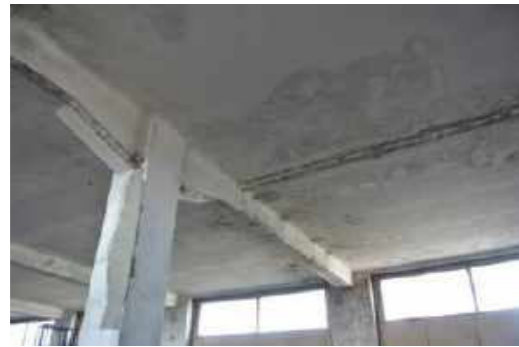
Eisenbetonstütze und -träger mit Voutenausbildung
