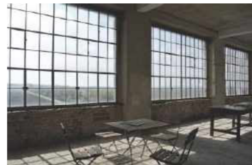
Abb. 262 Bauzeitliche „Fassoneisenfenster“
