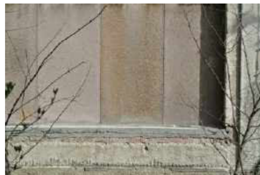
Ausbetonierte Fensterbank außen
