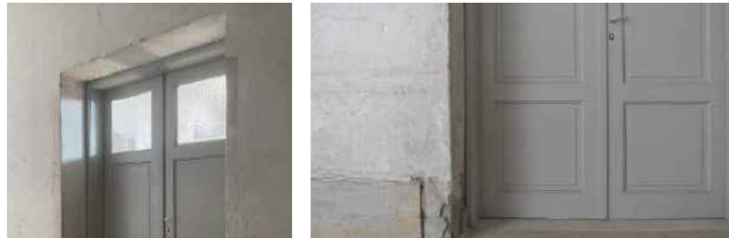
Abb. 314-315 Saniertes, bauzeitliches Türelement im Erdgeschoss
