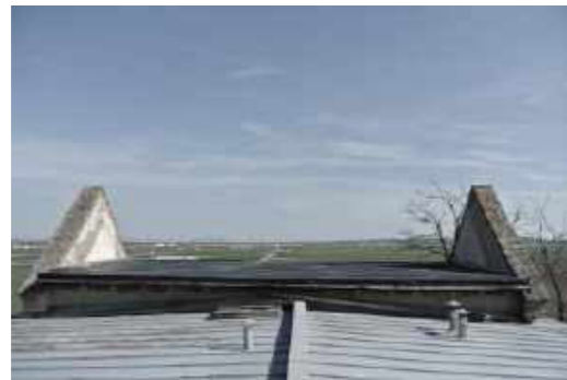
Bauzeitliche Giebelwände über dem Osttrakt
