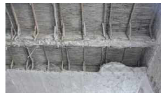
Abb. 245 Einblick in Eisenbeton-Hohlkammerdecke
