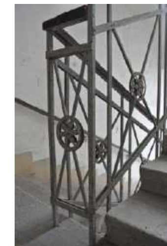
Eisenstabgeländer und Holzlauf
