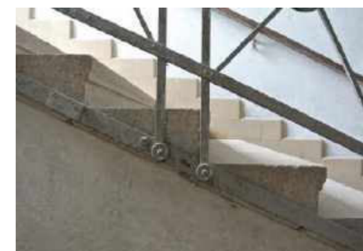
Abb. 260 Naturgranittreppen und Eisengeländer
