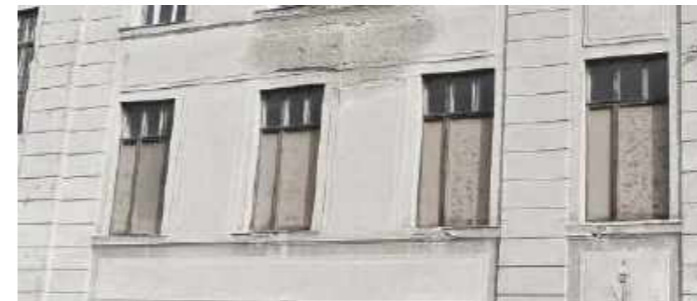
Bauzeitliche Fensterelemente mit provisorischen Füllungen
