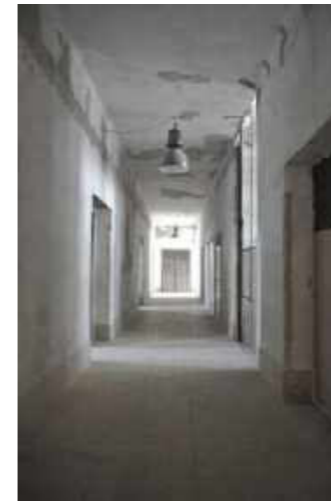
Gangbereich Richtung Osten
