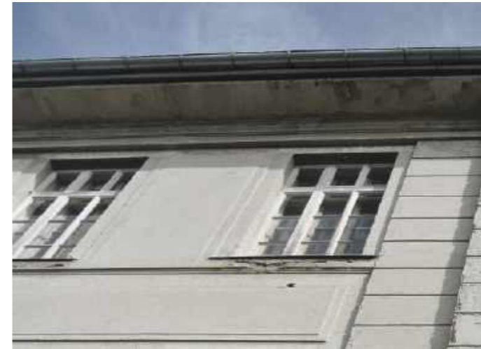
Bauzeitliche Fensterelemente an der Südfassade
