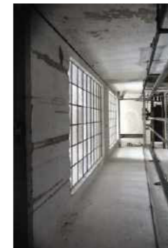
Schacht mit Fensteröffnungen
