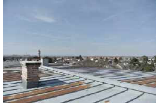
Blecheindeckung mit Gefälle über Mitteltrakt
