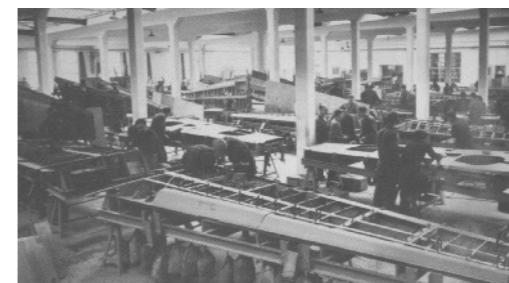
Abb. 172 Fertigung von Bf 109 Flächen im Werk III
