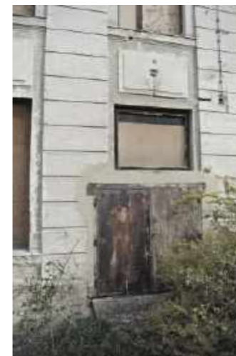
Südlicher Zugang zum Aufzug
