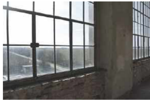
Bauzeitliche Fassoneisenfenster mit Öffnungsflügeln
