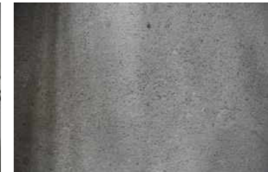
Betonierter Bodenbelag mit Hartkorneinstreuung
