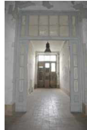
Blick Richtung Zugangsportal
