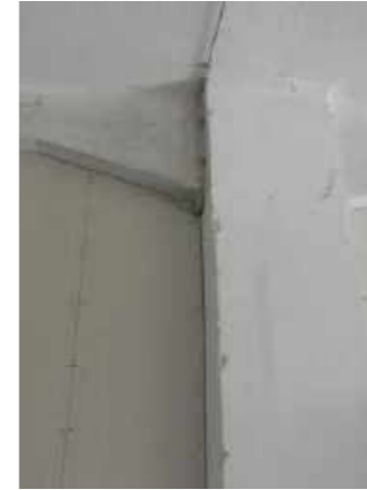
Eisenbetonstütze und Trennwand
