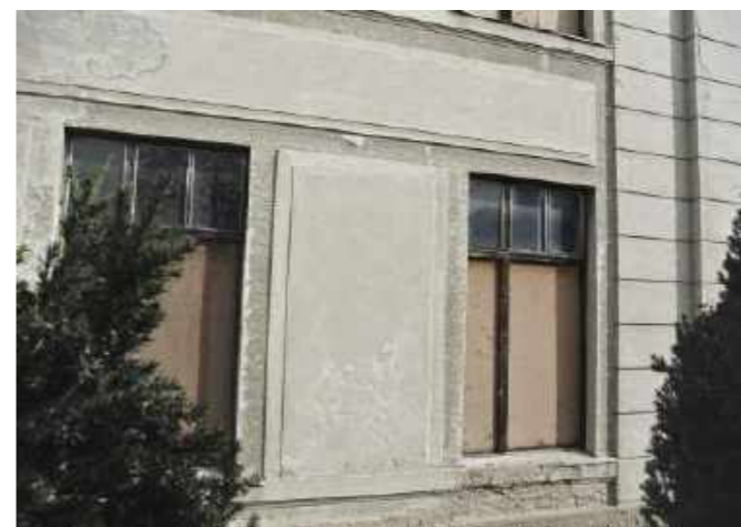
Bauzeitliche Fensterelemente mit provisorischen Füllungen
