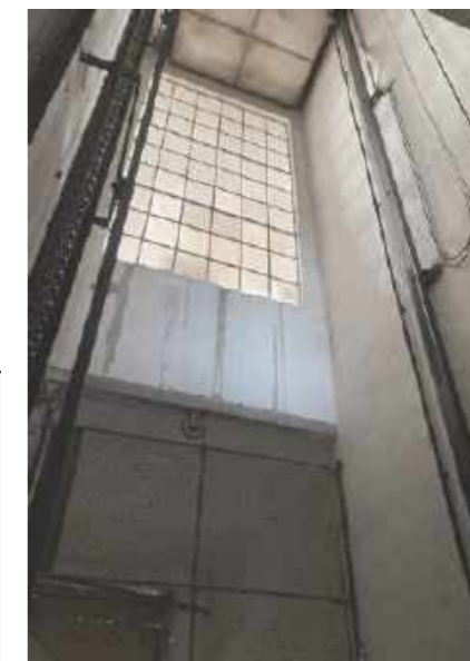
Abb. 331 Bestehender Aufzugsschacht
