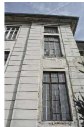
Holzrahmenfenster von außen
