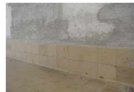
Abb. 259 Sockel aus Feinklinkerplattenpflaster
