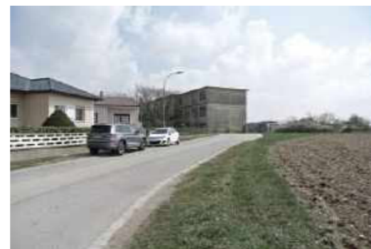
Abb. 223 Westlich angrenzendes Wohngebiet
