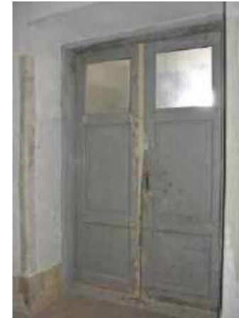
Bauzeitliches Türelement außen
