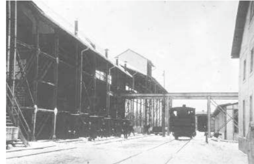
Abb. 136 Bahnstation neben der Zentrale
