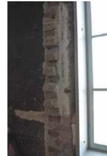
Rückstände früherer Trennwände
