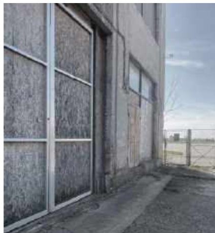
Abb. 216 Neue Einfahrtstore (links im Bild)
