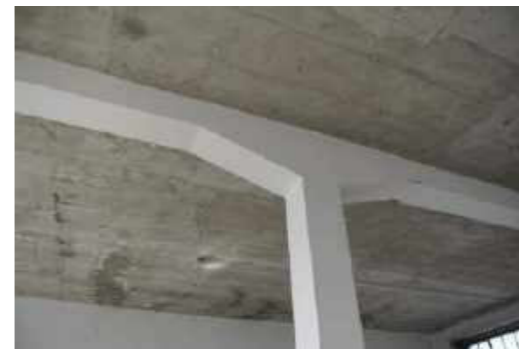
Sanierte und neu verputzte Tragelemente
