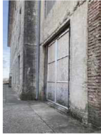
Provisorisches Einfahrtstor außen
