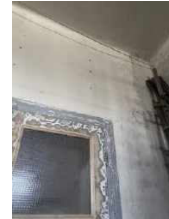
Bauzeitliches Türelement innen
