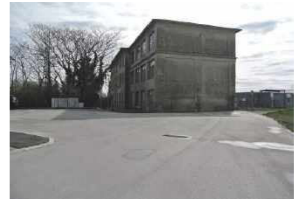
Abb. 229 Gesamter Baukörper und tieferer Mittelrisalit
