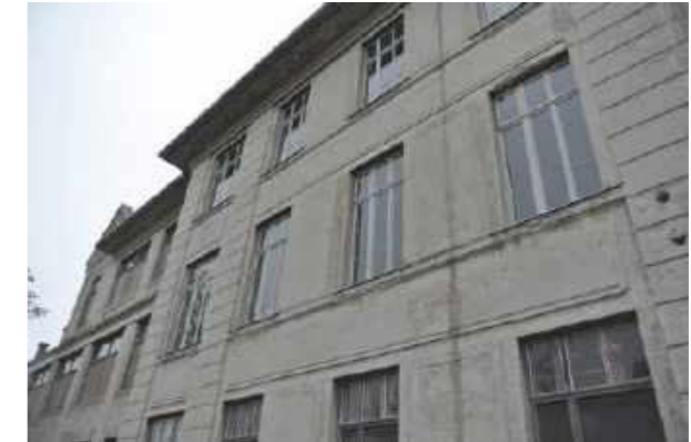
Abb. 321 Bauzeitliche und neue Kastenfenster
