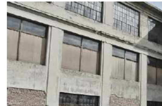
Provisorische Fensterelemente
