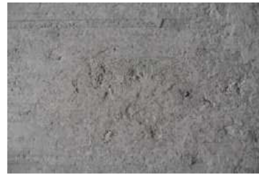
Sichtbare Oberkante des Unterlagbetons
