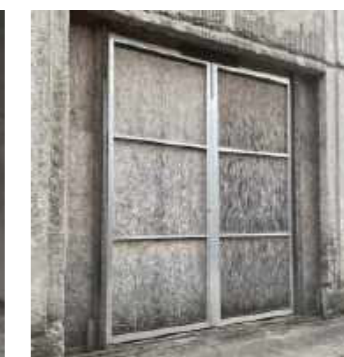
Provisorisches Einfahrtstor außen
