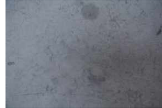
Bauzeitlicher Bodenbelag „Feuertrotz“
