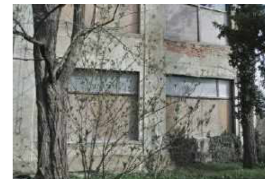
Südfassade mit provisorischen Fensterfüllungen
