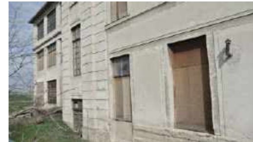
Fensterelemente in Südfassade
