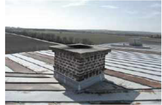
Massiver Rauchfang aus Ziegelmauerwerk
