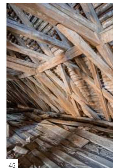
DG-SW-44 | Dachkammer DG-SW-45 | Längsaussteifung DG-SW-45 | Dachraum Westflügel DG-SW-45 | liegender Stuhl KG-SW-47 | Keller
