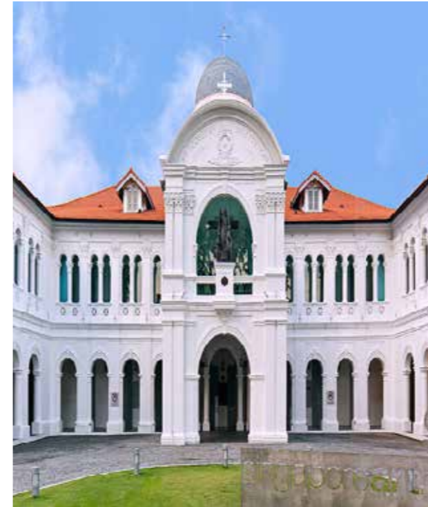
Abb.59: Singapur, Die Galerien im Zentralgebäude wurden durch Abbruch von Wänden ehemaliger Klassenzimmer gebildet.
