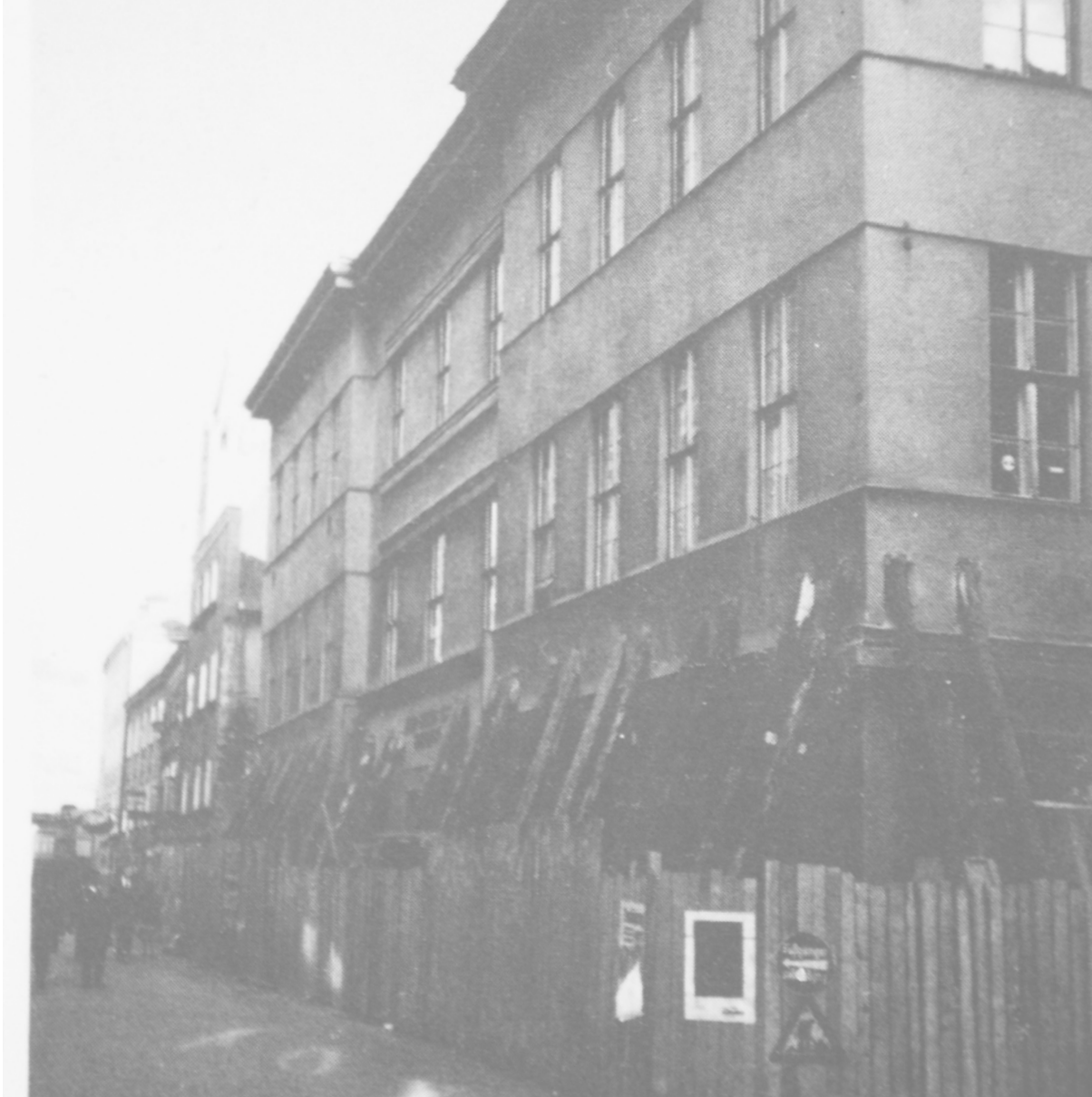
Abb. 21. Entdekoriertes Erscheinungsbild. Umbauarbeiten und Abbruch der OL 13,1974.
