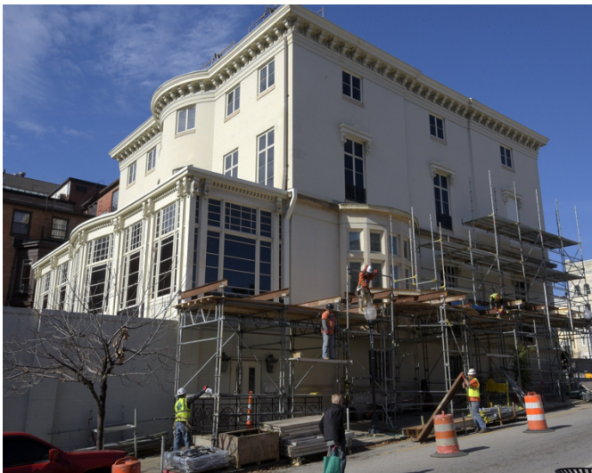
Abb. 23: Ostfassade und Veranda (Renovierung 2014-2018)
