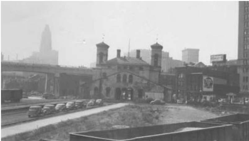
Abb. 55: Nordostansicht nach dem Abriss der Bahnsteighalle (zwischen 1939 und 1949)
