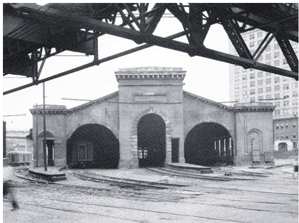
Abb. 53: Fassade der Bahnsteighalle im Nordosten (1936) im Hintergrund das Standard Oil Building
