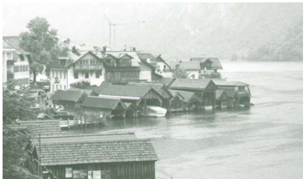
Abb. 22 Die typischen Satteldächer mit Holzschindeldeckung können im ganzen Ort in unterschiedlichen Zuständen beobachtet werden
