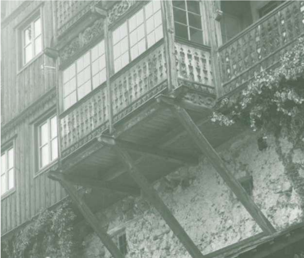
Abb. 23 „Brettschnitte“ an Balkongeländern und Fassaden prägen die äußere Erscheinung der Gebäude in Hallstatt, besonders im historischen Ortskern und an der Seestraße
