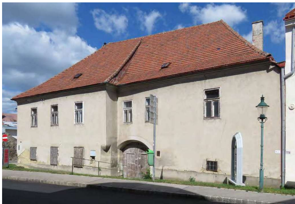
Abb. 88: Westfassade Haupttrakt Brunnergasse 1
