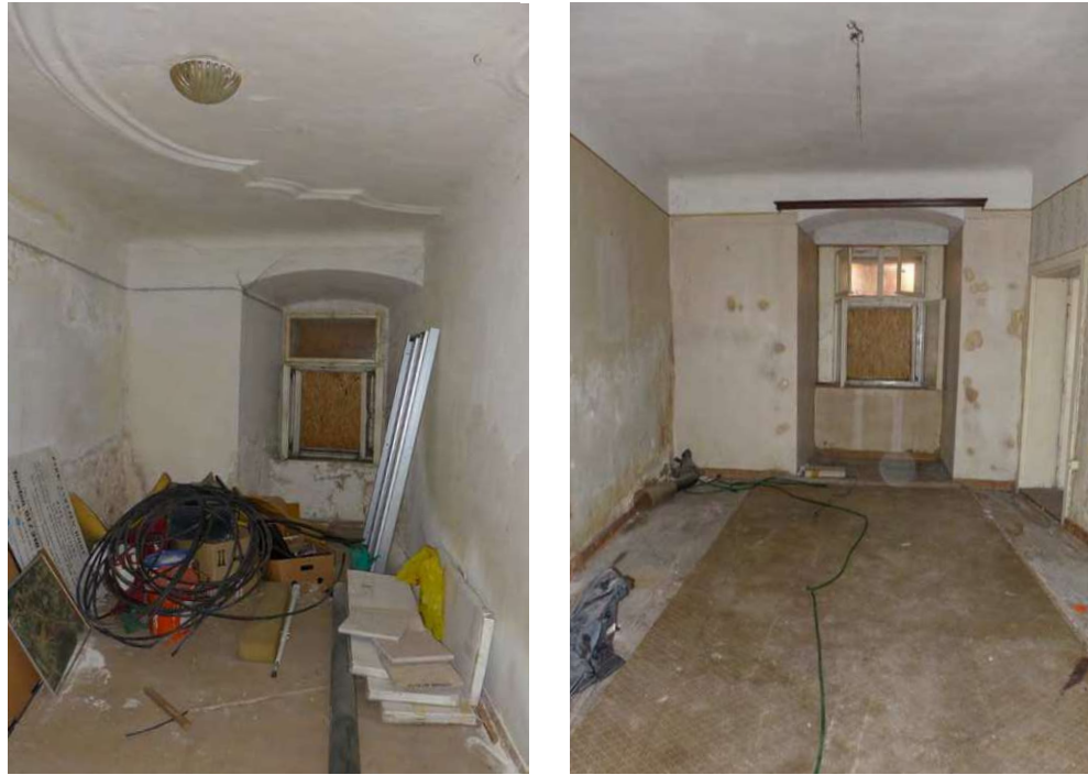
Abb. 93: Stuckfeld (li.) und verputztes Stuckfeld - noch erkennbar (re.)
