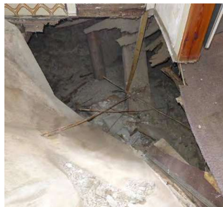
Abb. 142: Eingestürzter Boden
