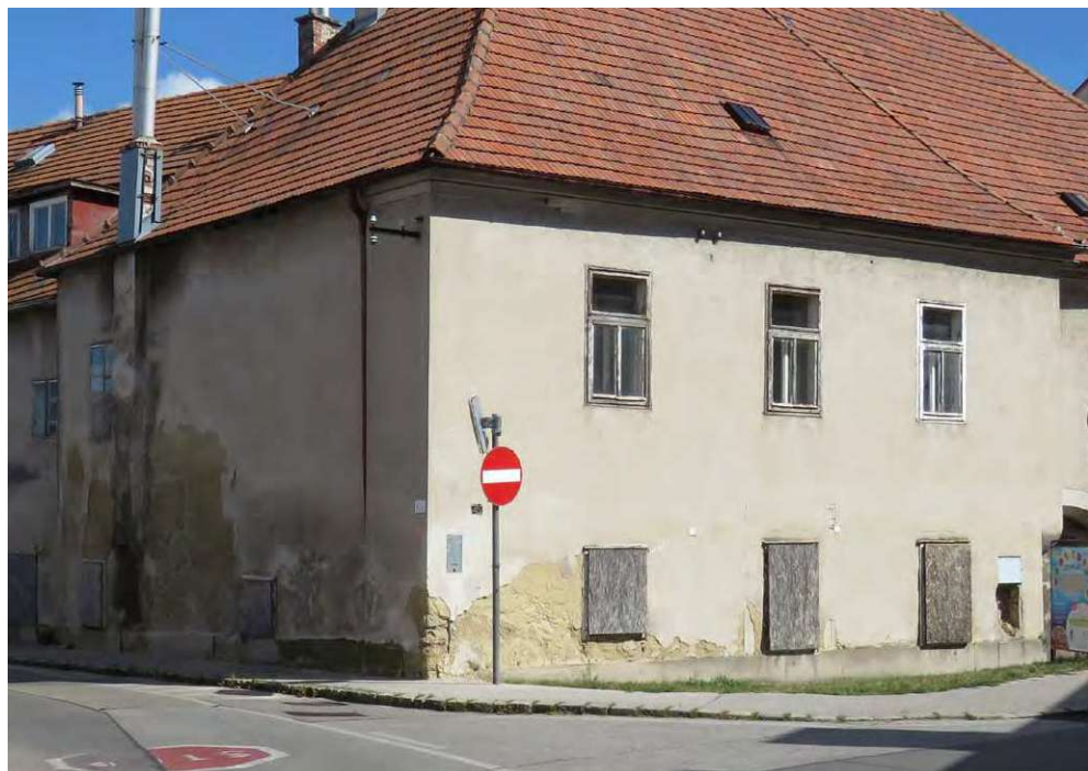
Abb. 112: Ansicht Nord-Ost Haupttrakt
