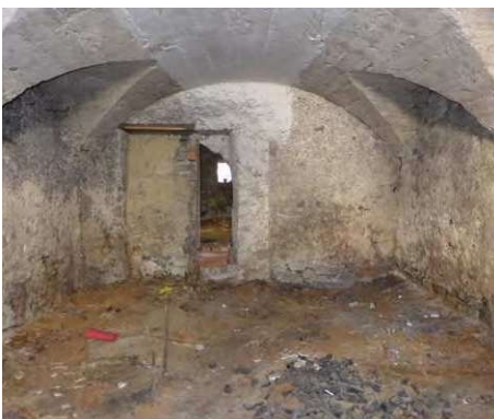
Abb. 91: Keller Raum H.-1.01
