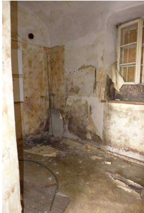
Abb. 118: Feuchteschäden in den Räumen N.0.02 (li.) und N.0.08 (re.)
