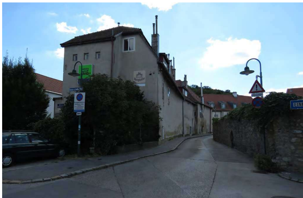
Abb. 98: Ostfassade Nebentrakt mit Gluck-Gasse
