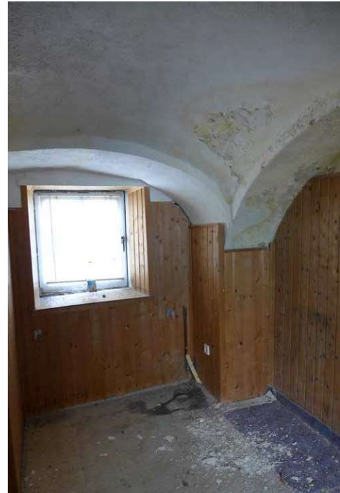
Abb. 118: Feuchteschäden in den Räumen N.0.02 (li.) und N.0.08 (re.)
