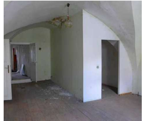
Abb. 94: H.1.01 mit Tonnengewölbe
