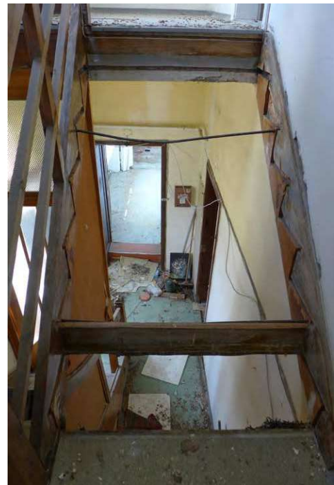
Abb. 119: Eingestürzte Treppe Blick aus dem 1. Obergeschoß (li.) und Podest (re.)
