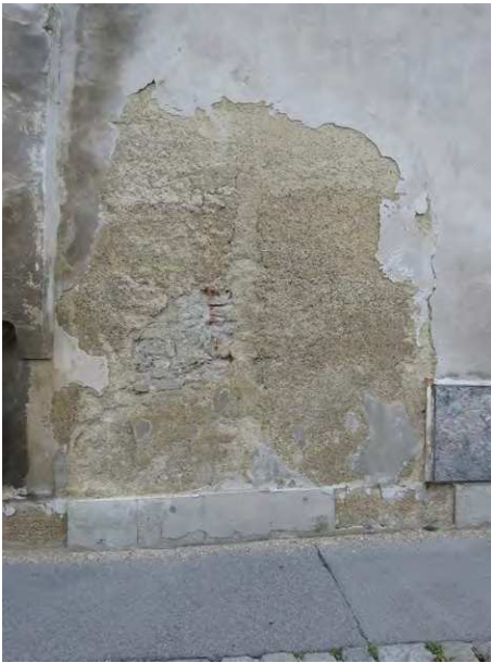
Abb. 144: Feuchtigkeitsschäden Putz
