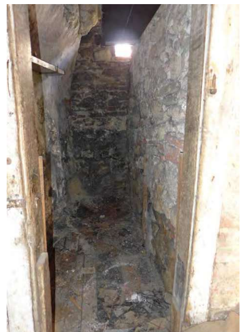
Abb. 92: Keller Raum H.-1.02
