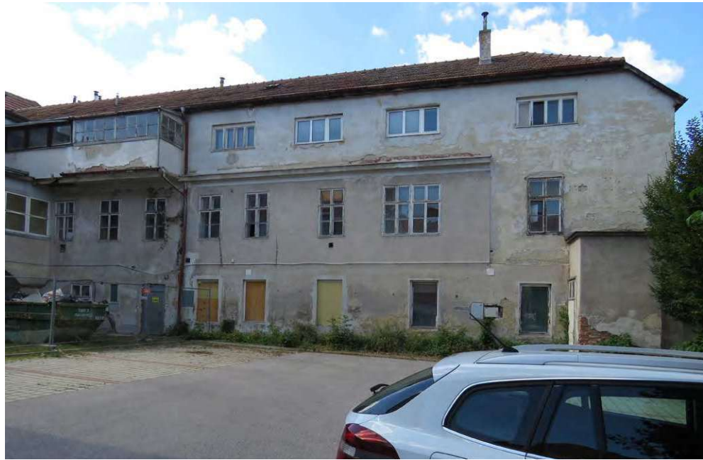
Abb. 97: Südfassade Nebentrakt Richtung Hof
