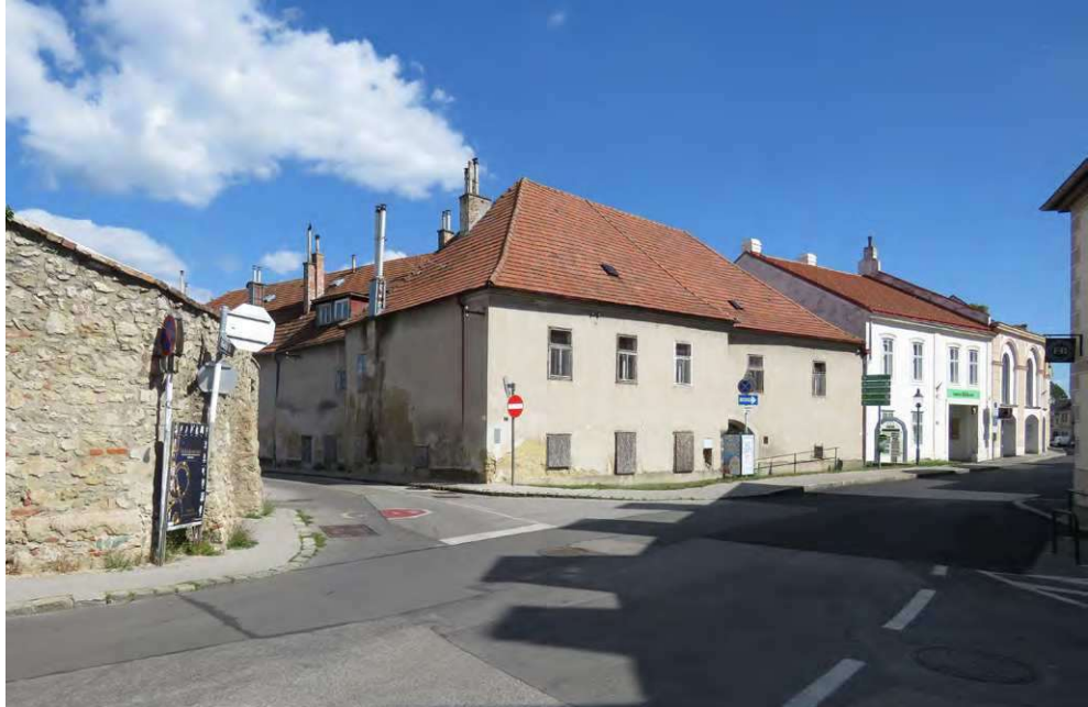
Abb. 68: Lage an der Kreuzung zur Gluckgasse mit Resten der ehemaligen Stadtmauer
