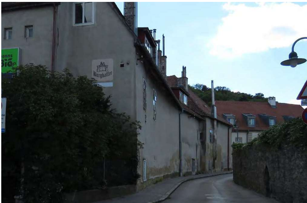
Abb. 117: Nordfassade Nebentrakt mit Gluck-Gasse
