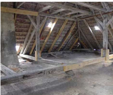
Abb. 115: Ausgebesserter Dachstuhl
