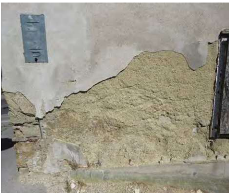
Abb. 145: Putzschäden Brunnergasse
