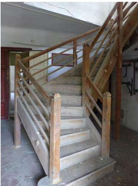
Abb. 148: Treppe in das Dachgeschoß
