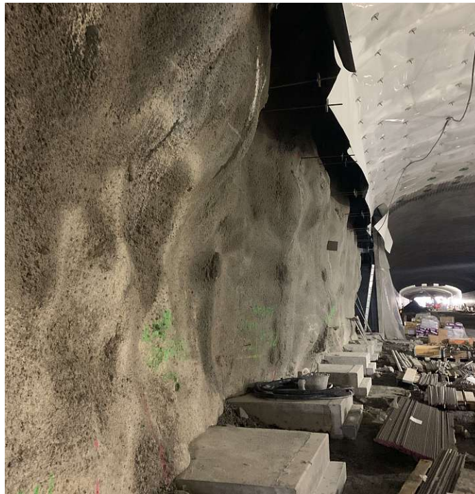
Abb. 4.1: Mit Stahlfaserspritzbeton gesicherte Ulme und mittels Gewindestangen abgehängter Abdichtungsschirm (Quelle: Eigene Aufnahme)
