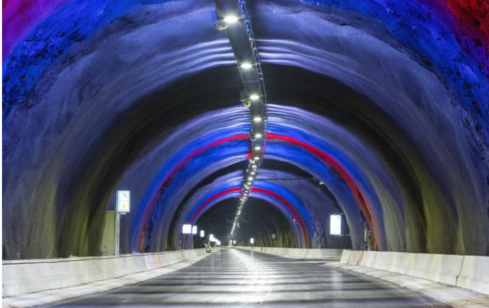
Abb. 5.12: Spritzbetongewölbe mit Leitkante nach Fertigstellung (Quelle: Mausol [24])
