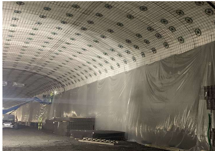
Abb. 4.7: Folienabdeckung der Fertigteilwände und im Firstbereich fixierte Bewehrung (Quelle: Eigene Aufnahme)
