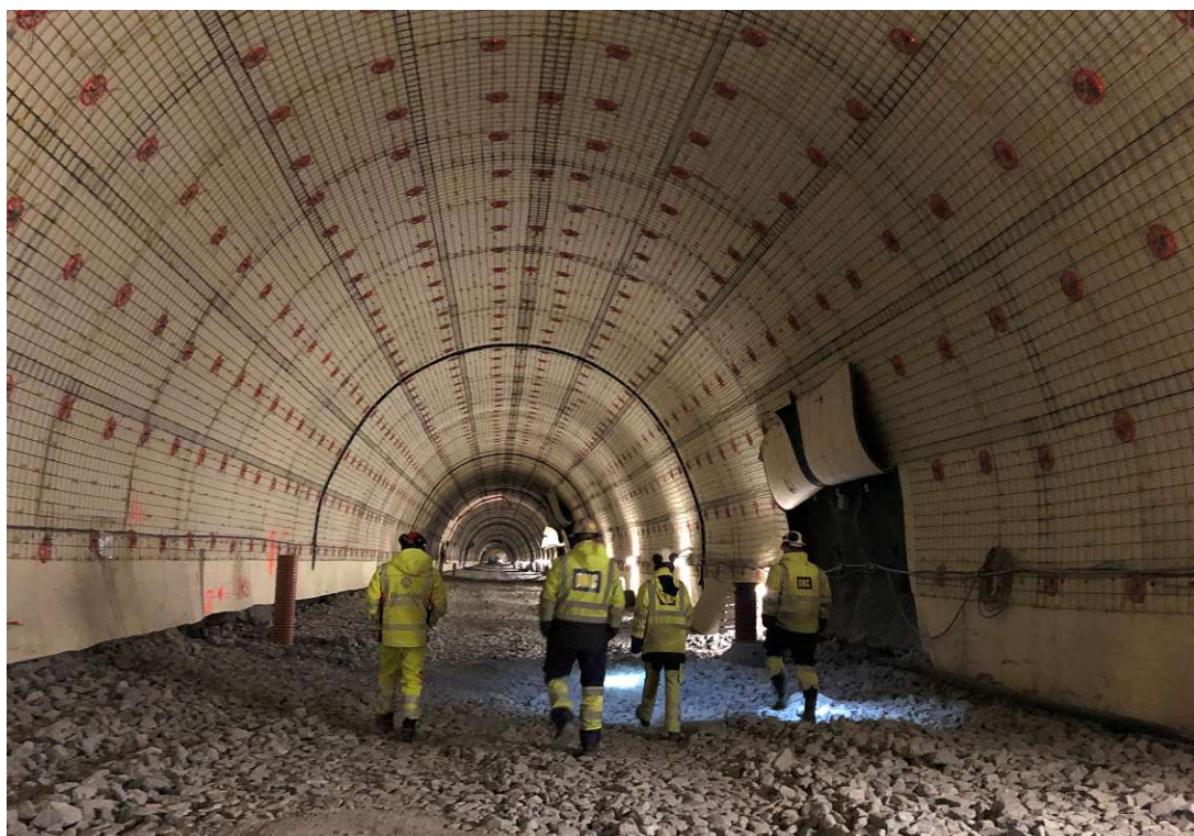
Abb. 5.11: Innenschalenkonstruktion vor dem Auftrag der fahrbahnseitigen Spritzbetonhaut auf einer Baustelle in Norwegen (Quelle: Mag. Ing. Stegie Jurica)
