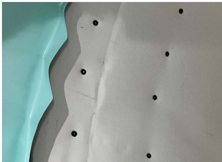
Abb. 3.11: Montage der geotextilen Schutzschicht sowie der KDB mittels Rondellen (Quelle: Eigene Aufnahme)
