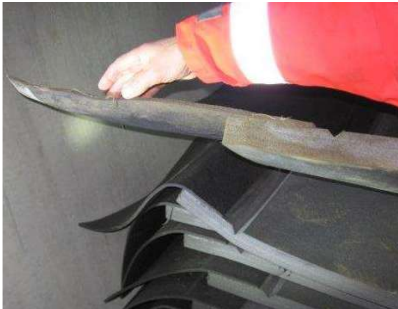
Abb. 5.6: PE-Platten, die unter der Berücksichtigung der vorzusehenden Überlappungsbereiche für die spätere Doppelnahschweißung an den PE-Abdichtungsbahnen befestigt werden (Quelle: Vegdirektoratet [49], S. 80)
