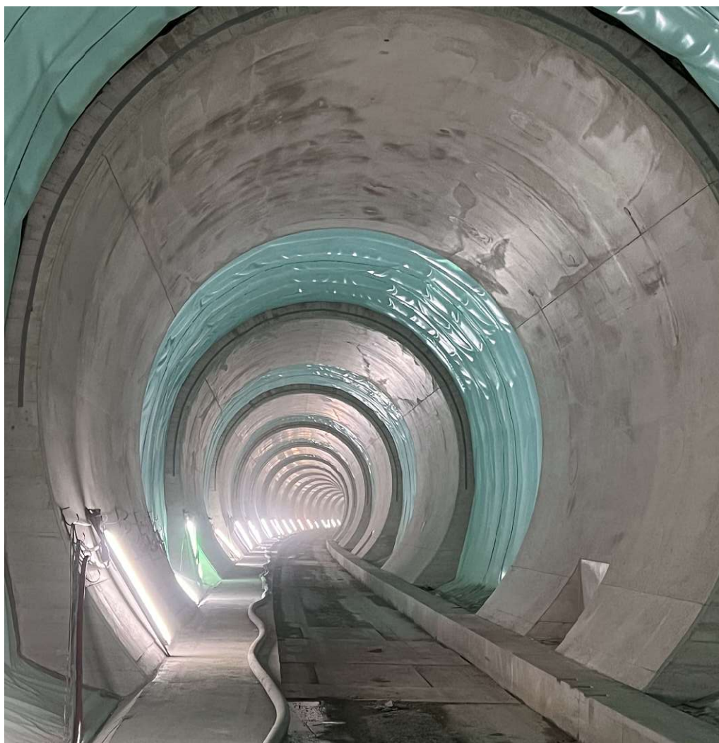
Abb. 3.13: Massive Ortbetoninnenschale nach Fertigstellung der Vorläuferblöcke (Quelle: Eigene Aufnahme)
