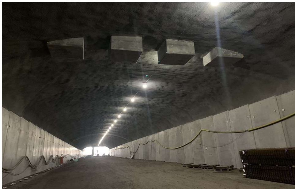
Abb. 4.2: Fertiger Innenschalenrohbau inkl. Deckenelementen zur Beleuchtungs- und Bewetterungsinstitution (Quelle: Eigene Aufnahme)
