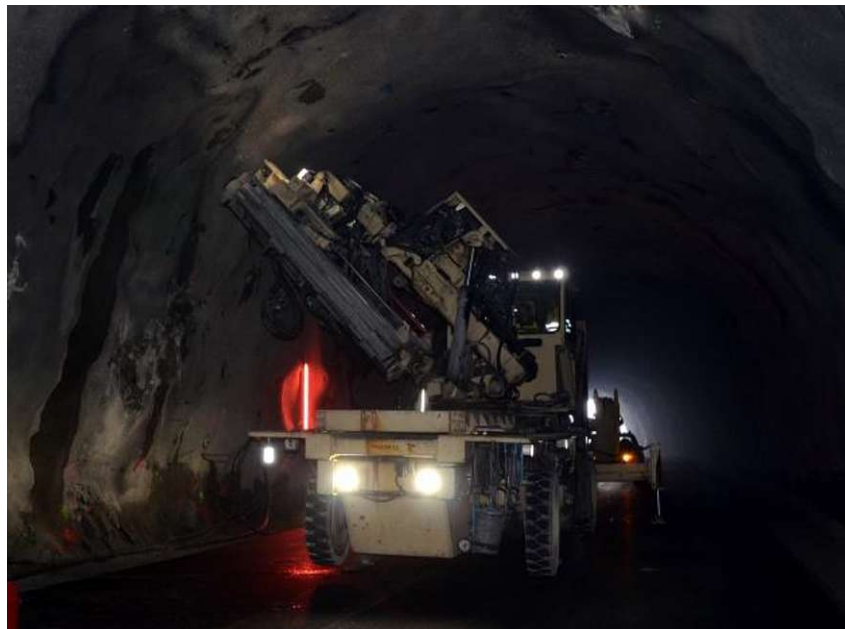
Abb. 5.10: Speziell für die Herstellung kurzer Ankerbohrungen konzipiertes Hochleistungsgerät (Quelle: Mag. Ing. Stegic Jurica)
