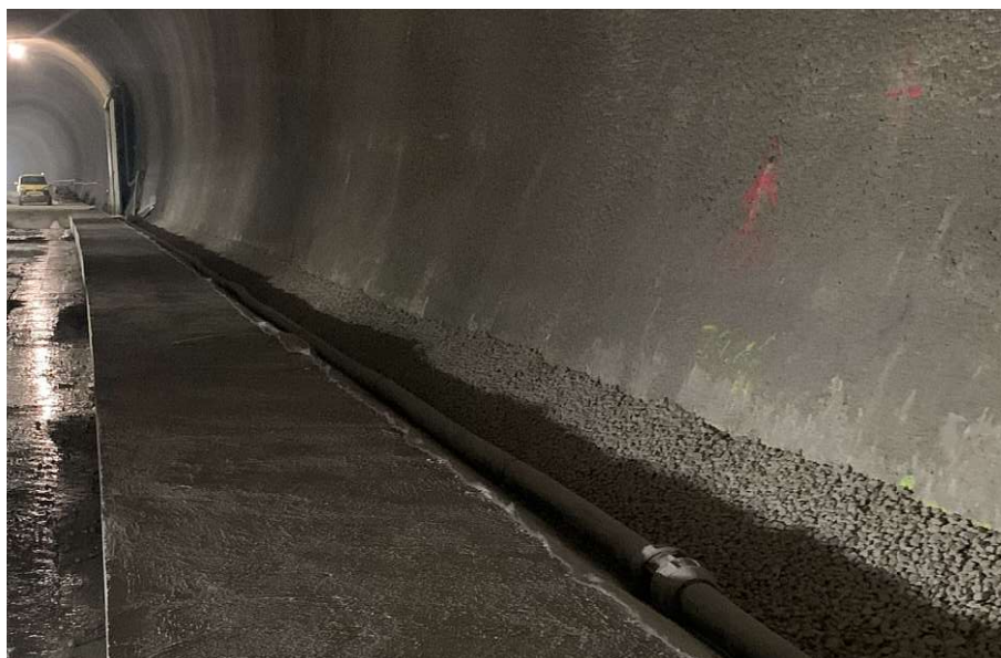
Abb. 3.10: Widerlager und gebundene Sickerpackung auf einer österreichischen Baustelle (Quelle: Eigene Aufnahme)
