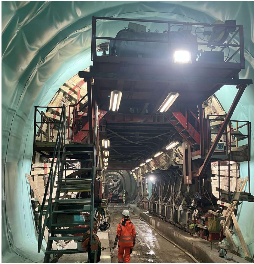
Abb. 3.12: Vorläufergewölbeschalwagen zur Herstellung von Gewölbeblöcken mit 12,5 Metern Länge (Quelle: Eigene Aufnahme)
