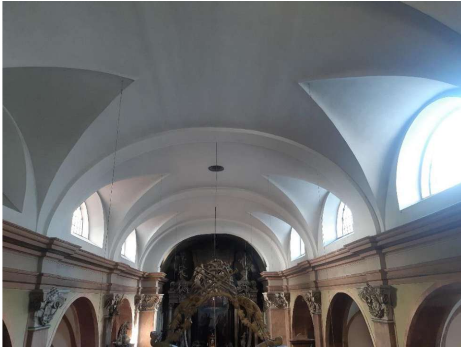
Abbildung 5 Tonnengewölbe des Hauptschiffes mit Stichkappen (von den Fenstern zur Mitte), dem Heilig-Geist-Loch (Mitte) und Fenstern über den offenen Seitenkapellen (links = Osten, rechts = Westen) (Lang D. J.)
