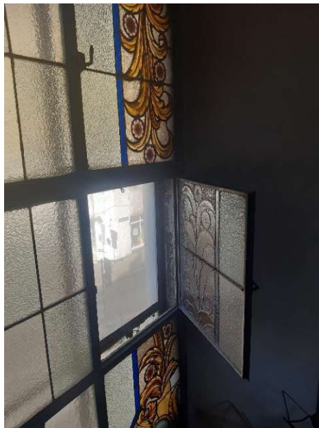
Abbildung 14 unteres mittleres Fenster bei der Orgelepore (Lang D. J.); innen: Glaselemente mit Bleischnureinfassung (florales Ornament), außen vorgelagert: farblose, durchsichtige Scheibe
