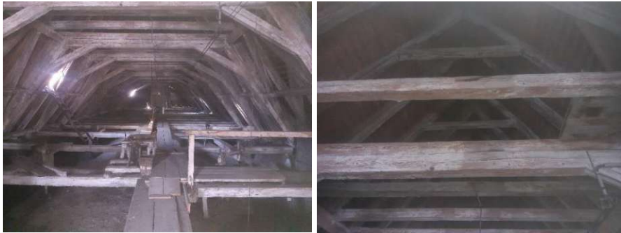
Abbildung 19 Dachboden: Querbalken inklusive begehbare Querlatten (links), Holzträger im Giebel (rechts) (Lang D. J.)
