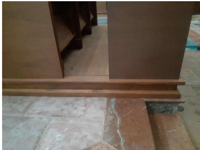
Abbildung 174 Chorgestühl mit hölzernem Gestühlsockel in der Vierung des Kircheninnenraumes; rechts unten im Bild sind die Stufen zum steinernen Sockel zu sehen, der bei den Renovierungsarbeiten eingefügt wurde, um in der Vierung die gleiche Höhe wie das dahinter befindliche Presbyterium zu haben (Lang D. J., Besichtigung der Dominikanerkirche in Wien, Innere Stadt, 2023)
