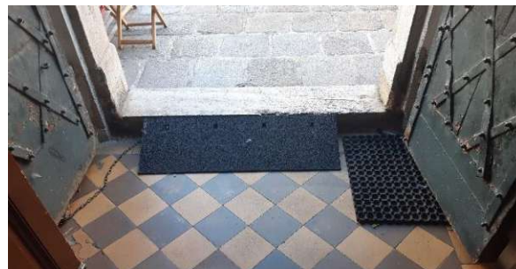
Abbildung 21 Beitrag zur sozialen Nachhaltigkeit: An beiden Seiteneingängen bei der Nordportalfassade sind entfernbare Gummirampen, sodass Rollstuhlfahrer mit Begleitung leichter in das Gebäude kommen. (Lang D. J.)
