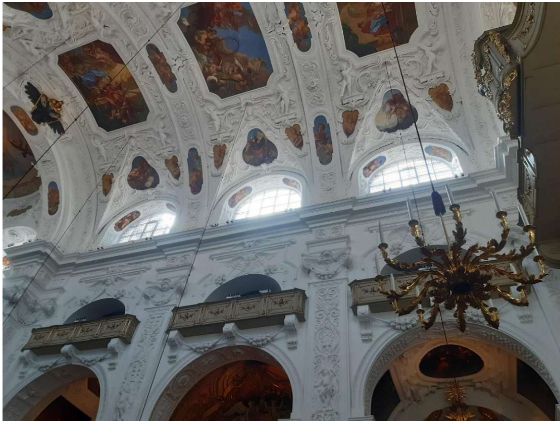
Abbildung 176 Innenraum der Dominikanerkirche, Sicht Richtung Südwesten (Lang D. J., Besichtigung der Dominikanerkirche in Wien, Innere Stadt, 2023); Zu erkennen ist oben das Tonnengewölbe des Hauptschiffes inklusive der Stichkappen Richtung von drei Fenstern. Darunter befindet sich ein Emporengang mit Geländern sowie noch einmal darunter befinden sich die drei offenen Seitenkapellen der südwestlichen (rechten) Seite.
