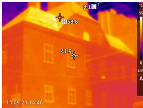
Abbildung 64 Wärmebild des Pfarrhauses, Front Paulanergasse
