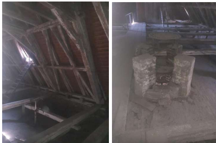
Abbildung 20 Schräge der Dachhaut mit Dachsteinen und Ausstieg mit Leiter (links), Heilig-Geist-Loch von oben (rechts) (Lang D. J.)
