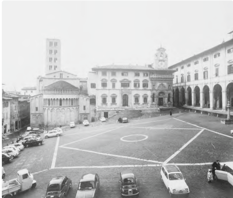
[20] Arezzo, Loggia and Piazza Grande, 1967.
