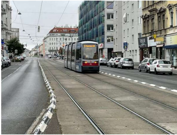
Abb. 4.12: Stuttgarter Schwellen als Fahrbahnabgrenzung (Wien)
