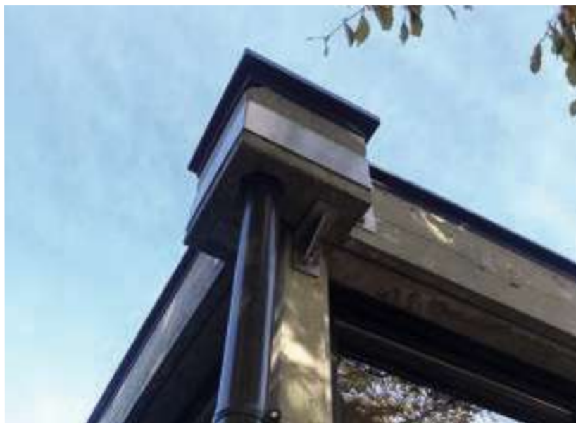
Abb.97 Würfelförmige Rinnenkessel aus Beton ragen aus der Attika hervor.
