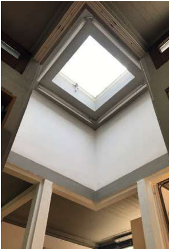
Abb.58 Lichtkuppel in der ehemaligen Kindergärtnerinnenwohnung in nordwestlicher Richtung vor der Sanierung. Aufnahme datum März 2022.
