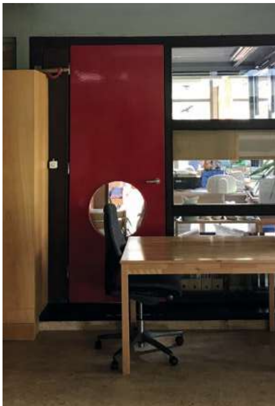
Abb.63 Boden des ehemaligen Bewegungsraums vor der Sanierung. Aufnahme datum März 2022.
