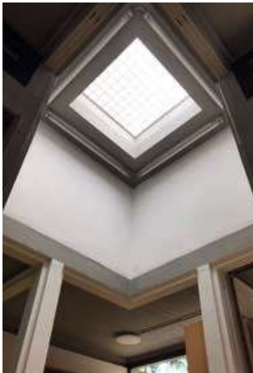
Abb.81-82 Vier portalartige Stahlbetonstützen tragen die Lichtkuppeln. Sie befinden sich in den ehemaligen Gruppenräume an den Schnittpunkten von Raumverlängerungen und den Haupträumen.
