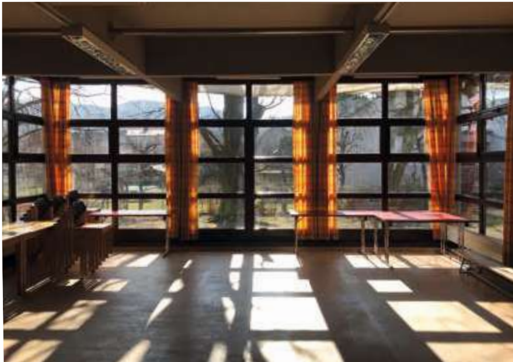
Abb.84 An der Südseite des Gebäudes, zwischen zwei ehemaligen Gruppenräumen, erstreckt sich der ehemalige Bewegungsraum. Dieser ist an drei Seiten von raumhohen Holz-Glas-Fassadenelementen umgeben, die eine lichtdurchflutete Atmosphäre schaffen.
