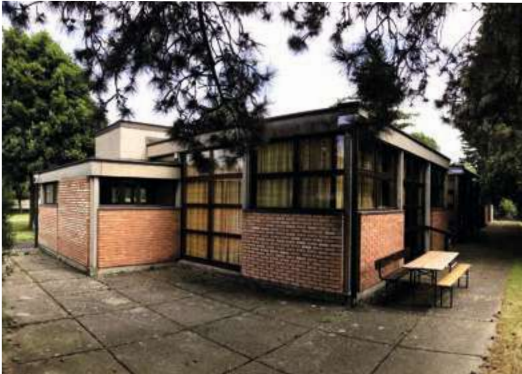
Abb.69 Die Erscheinung des ehemaligen Kindergartens wird durch Sichtbeton, Sichtziegel und Holz-Glasverglasung
