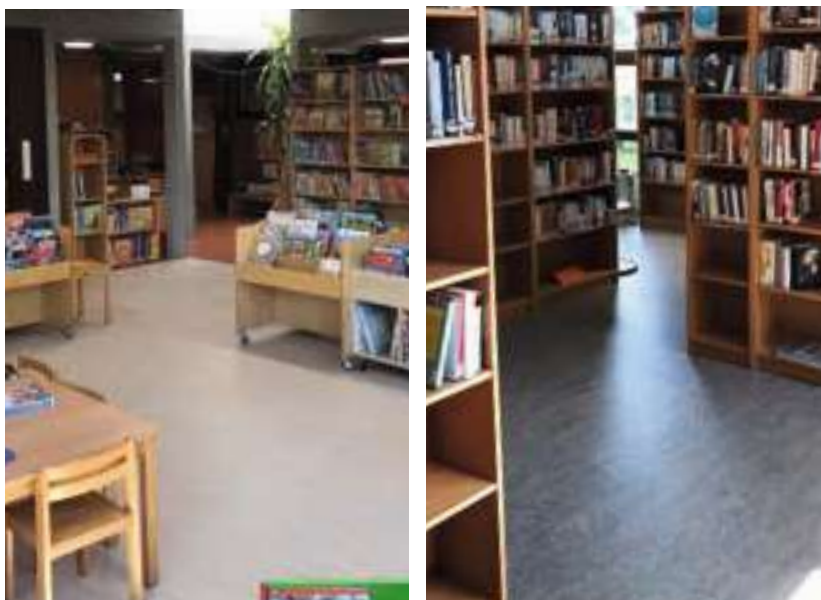
Abb.113-114 Linoleum als Bodenbelag ist im ehemaligen Gruppenraum im Südosten, im ehemaligen Bewegungsraum sowie in den früheren Wohnungen und im Leiterraum zu sehen.
