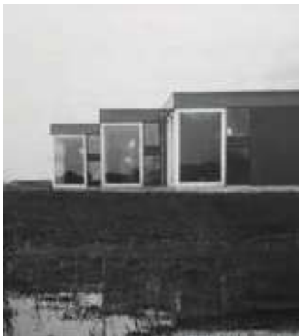
Abb.11 Abgestufte Fassade der Klassenzimmern um 1960.
