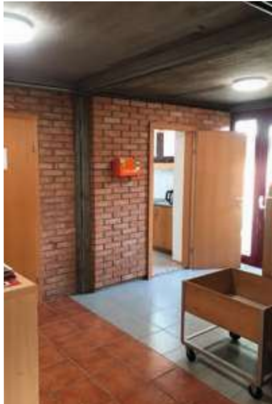
Abb.124 Die nachträglich verlegten hellgrauen Fliesen bilden einen starken Kontrast zu den ursprünglich verwendeten Terracotta-Fliesen aus der Bauzeit.
