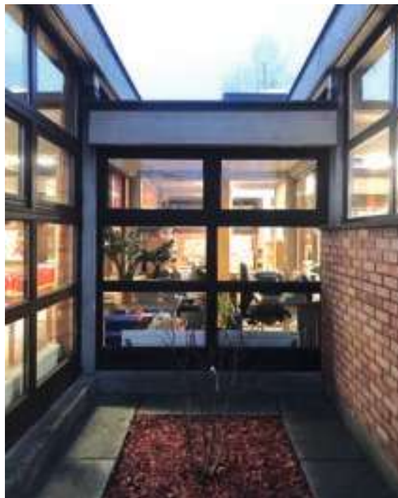
Abb.87 Blick auf den Zwischenraum an der Südfassade, der sich zwischen dem ehemaligen Bewegungsraum und dem südöstlichen ehemaligen Gruppenraum befindet
