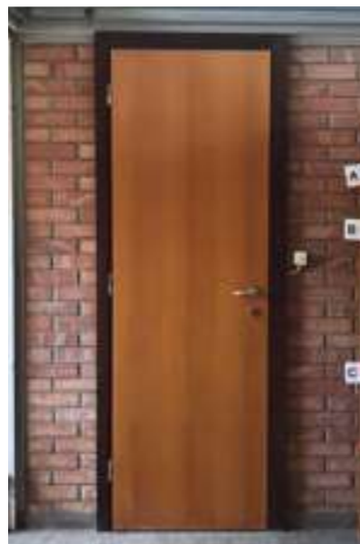
Abb.105 Eine ehemalige Wohnungseingangstür mit dunkelbrauner Zarge und hellbraunem Türblatt aus Holz verfügt über einen metallenen Türgriff.
