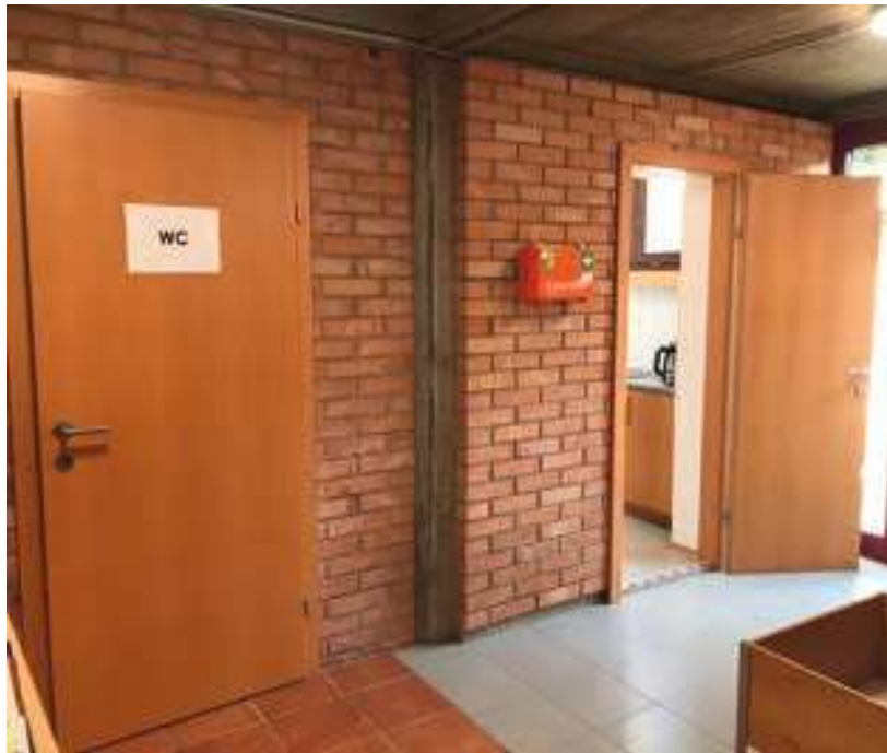
Abb.123 Die helbraunen Holztüren der Gemeinschafts-WCs und der Teeküche, die im Zuge der Umbauten im Jahr 2016 eingesetzt wurden, harmonisieren nicht mit dem Material- und Farbkonzept des Gebäudes und beeinträchtigen daher die architektonische Qualität des Gesamtbildes.
