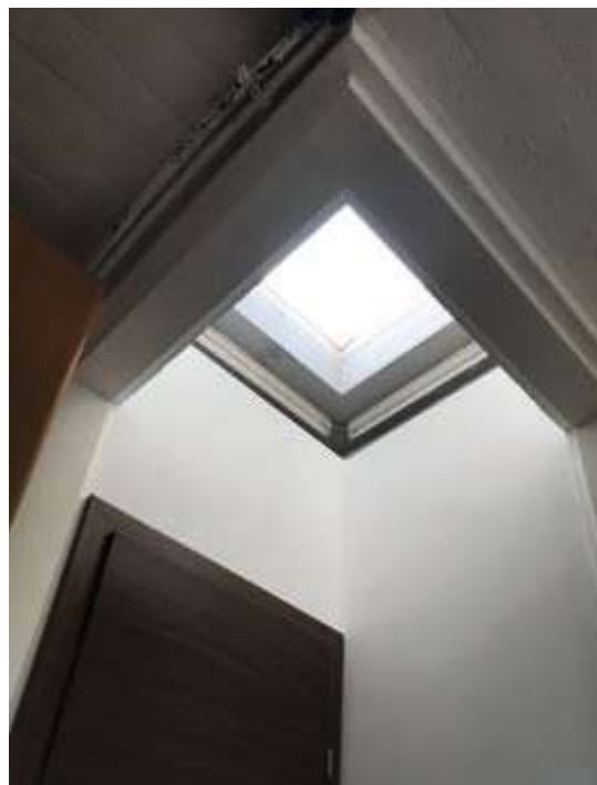
Abb.120 Die unter der Lichtkuppel errichteten Trennwände wurden konstruiert, um einen Abstellraum in der Teeküche abzugrenzen. Das Bild zeigt den Blick aus der Teeküche hinauf zur Lichtkuppel.
