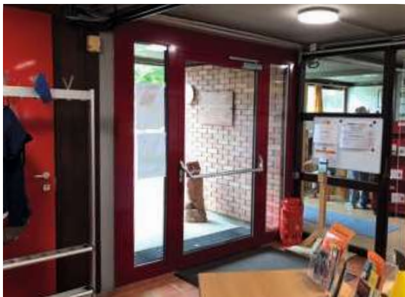
Abb.100 Haupteingang mit einer roten Fluchttür aus Aluminium und Glas, versehen mit einer metallenen Druckstange, betrachtet von innen.
