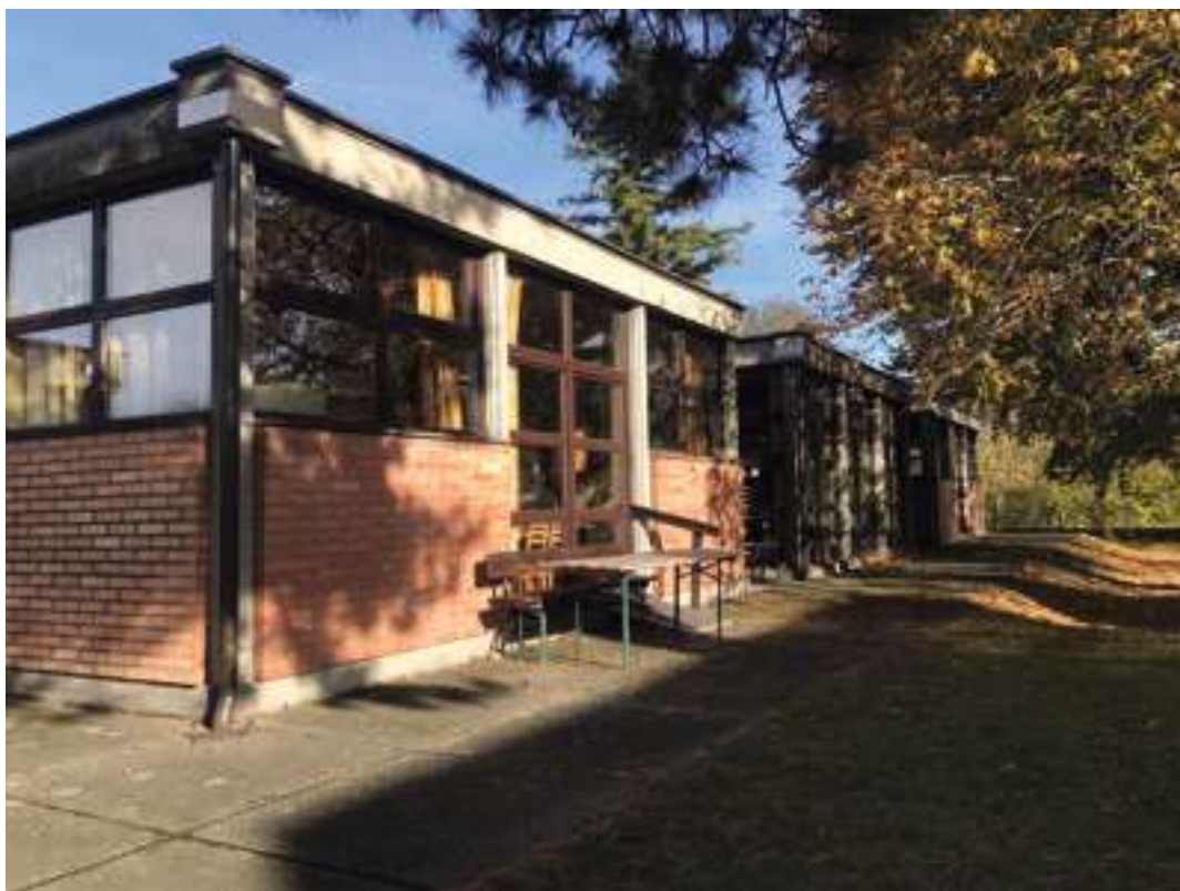
Abb.57 Blick auf die Südfassade nach der Sanierung. Aufnahme datum September 2023.
