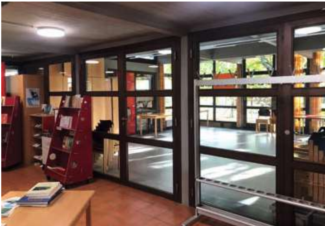
Abb.74 Der ehemalige Bewegungsraum ist von der Eingangshalle durch drei doppelflügelige Drehtüren aus einer Holz-Glas-Konstruktion getrennt und an der Südfassade von dreiseitigen Holz-Glas-Fassadenelementen umschlossen. Dadurch erstreckt sich der Blick von der Eingangshalle bis hin zum Südgarten.
