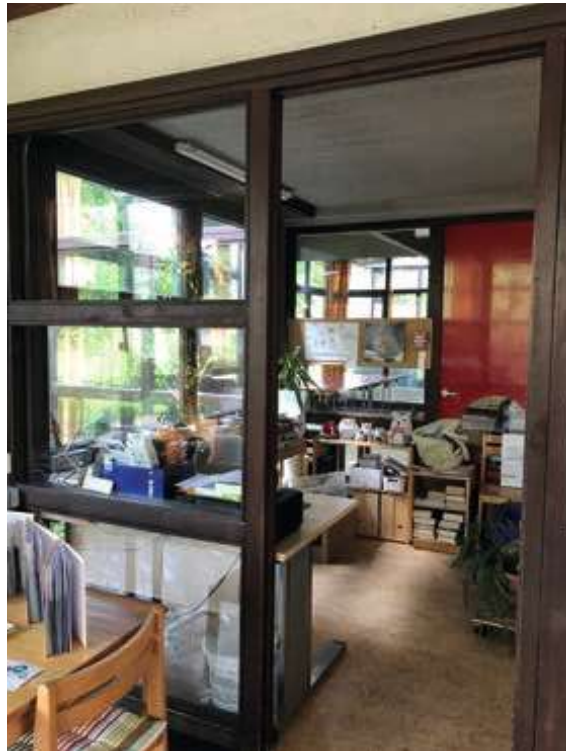
Abb.86 Der Raum zwischen dem ehemaligen Bewegungsraum und dem südöstlichen ehemaligen Gruppenraum ist an drei Seiten von Holz-Glas-Fassadenelementen umgeben.
