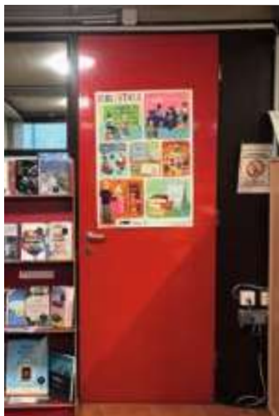
Abb.104 Die Bürotür ist rot lackiert und aus Holz gefertigt, sie entspricht in Material und Farbe den anderen roten Türen der ehemaligen Gruppenräume, allerdings ist sie ohne Glasscheibe.
