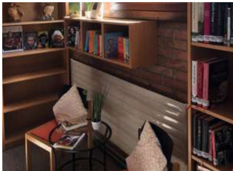
Abb.118 An den Ziegelwänden sind größere und dünnere Heizkörper angebracht, die ebenfalls aus der Kindergartenzeit stammen und noch heute für die Beheizung der Räume sorgen.
