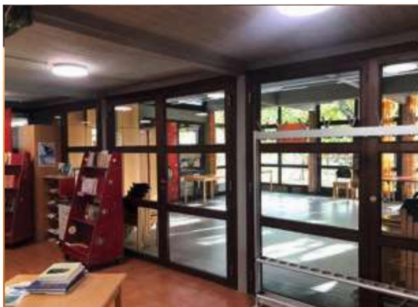
Abb.102 Die Eingangshalle und der ehemalige Bewegungsraum werden durch drei doppel­flü­gelige Drehtüren getrennt, die sich zwischen den Stahlbetonstützen erstrecken.
