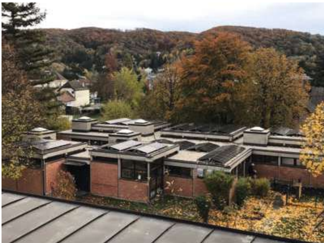
Abb.55 Blick auf die Dachlandschaft nach der Sanierung. Aufnahme datum September 2023.
