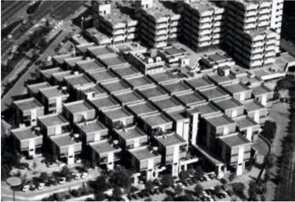
Abb.14 Herman Hertzberger, Luftbild von Centraal Beheer Bürogebäude in Apeldoorn 70er Jahre.
