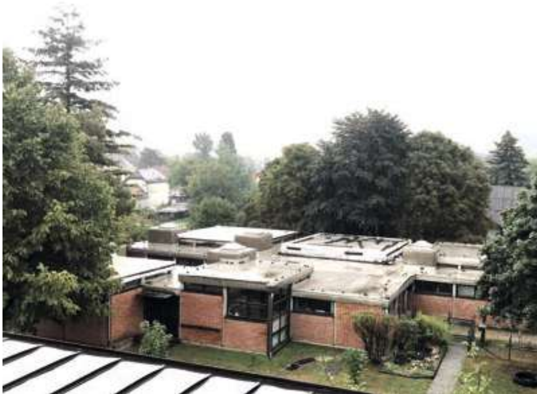
Abb.54 Blick auf die Dachlandschaft vor der Sanierung. Aufnahme datum März 2022.
