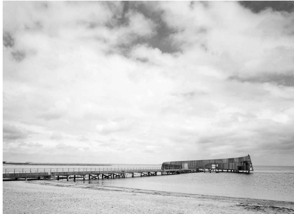
42 / D - Kastrup Seabath, White Architekt, Dänemark, Pfahlkonstruktion
