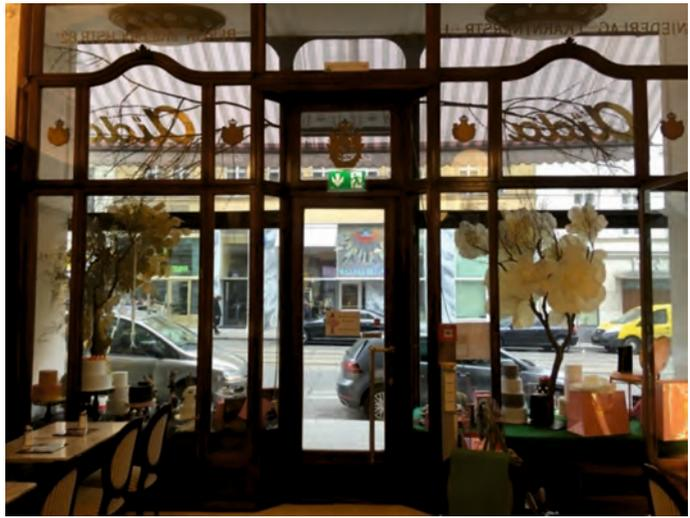
Abb. 6 Portale, Holz-Glas-Konstruktionen, die der eigentlichen Erdgeschosfassade vorgesetzt sind und den Austausch zwischen innen und außen in Szene setzen © Psenner 2020
