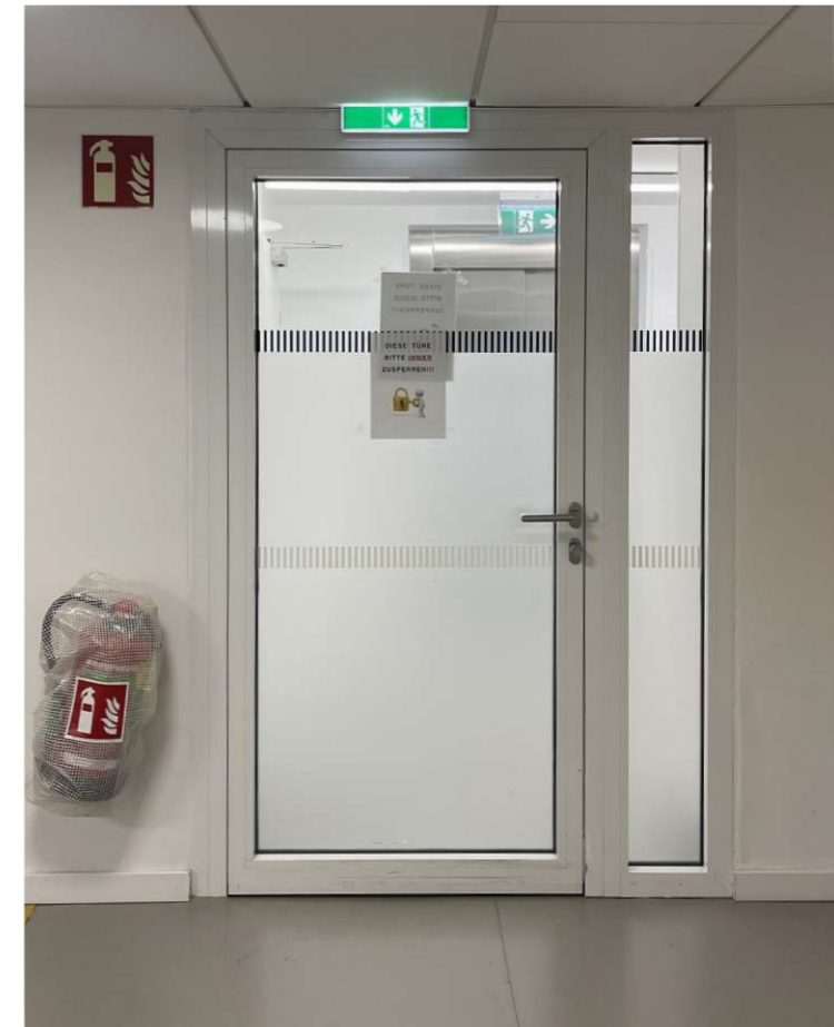
Architekturfotografie: Abb.55: Zugang Lift, Schule am Himmel, Wien © Cassandra Oechsler.
