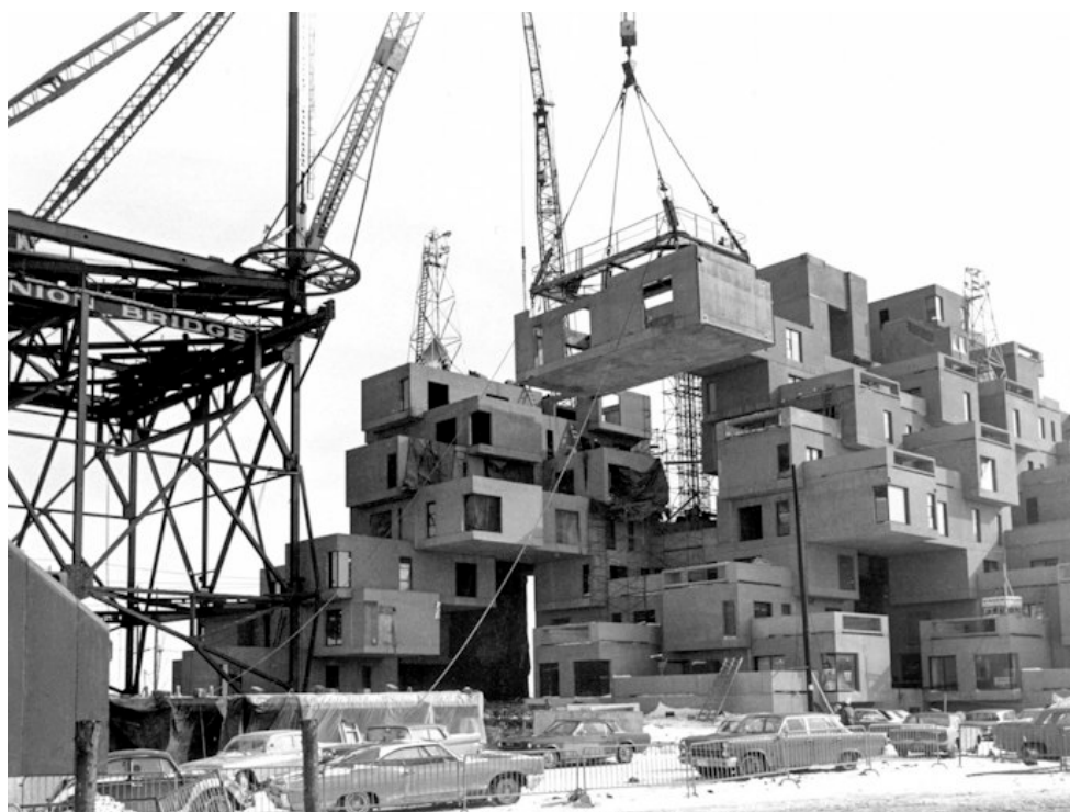
Abb.29: Habitat 67, Vorfertigung und Baustelle
