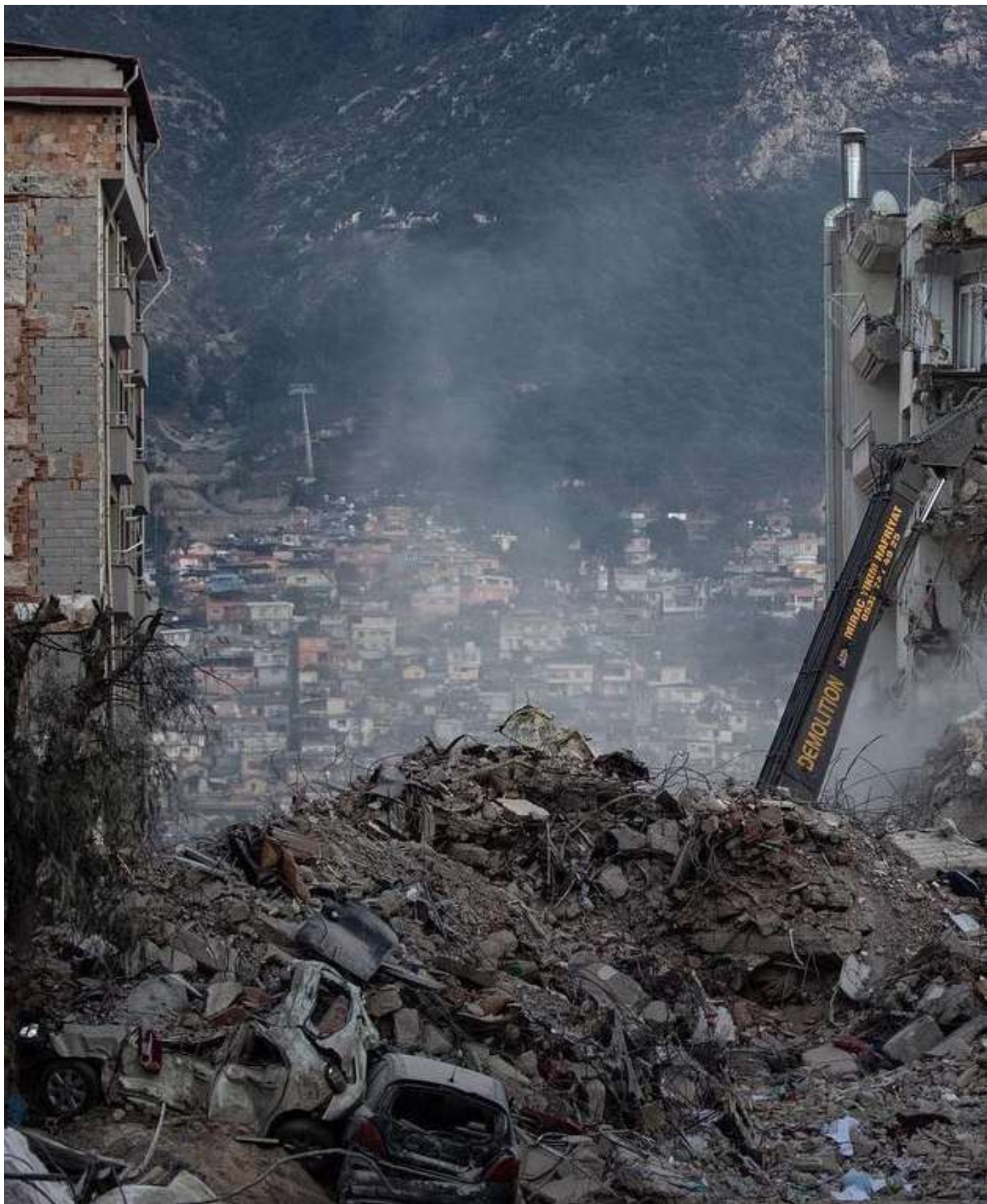
Abb.8: Die Zerstörung in Hatay
