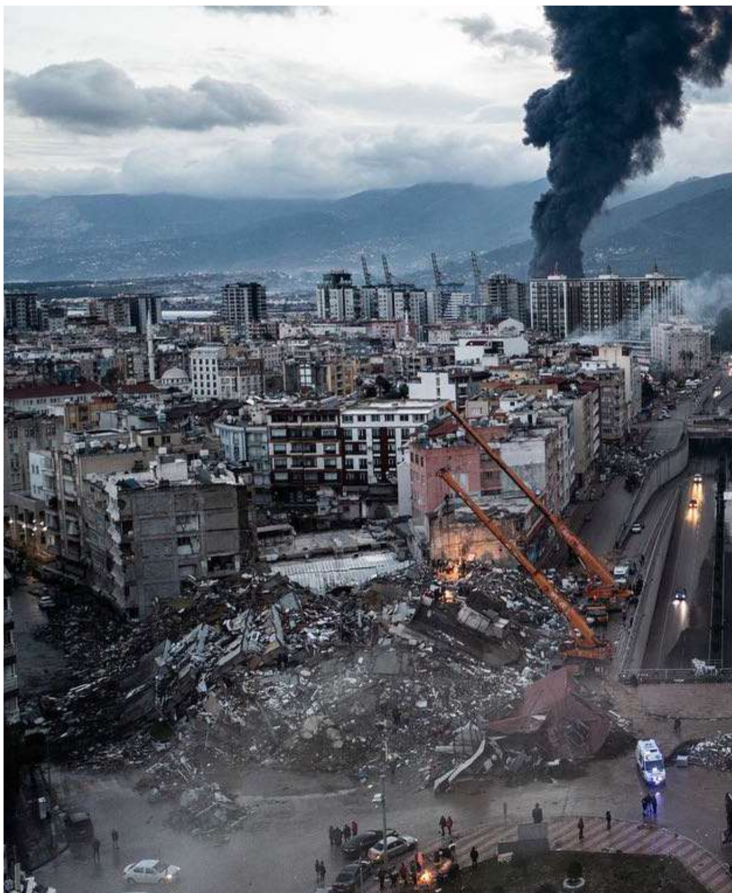
Abb.9: Die Zerstörung in Hatay
