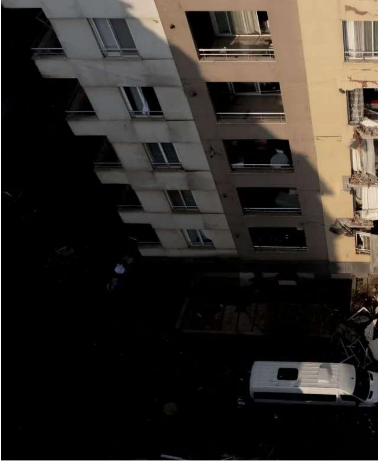
Abb.7: Die Zerstörung in Hatay
