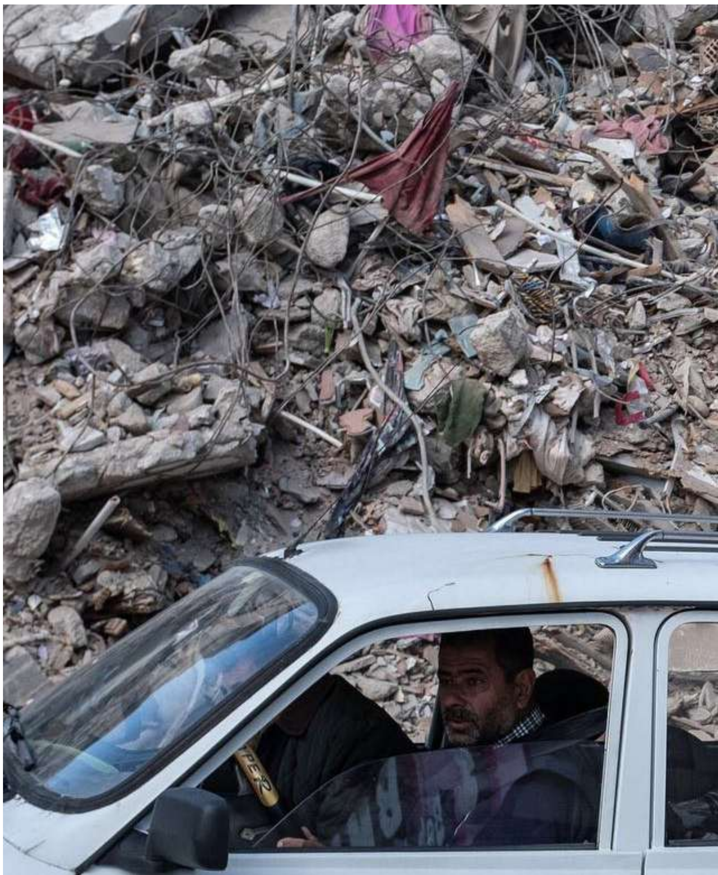
Abb.10: Die Zerstörung in Hatay
