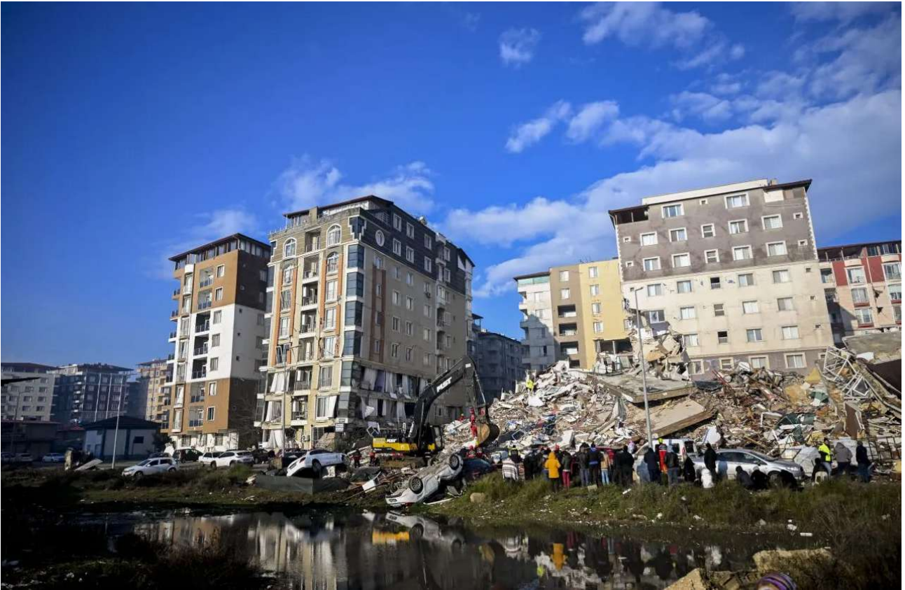
Abb.5: Die Zerstörung in Hatay
