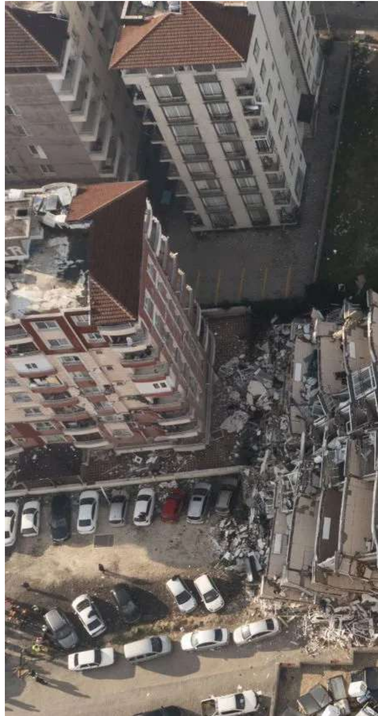
Abb.4: Die Zerstörung in Hatay
