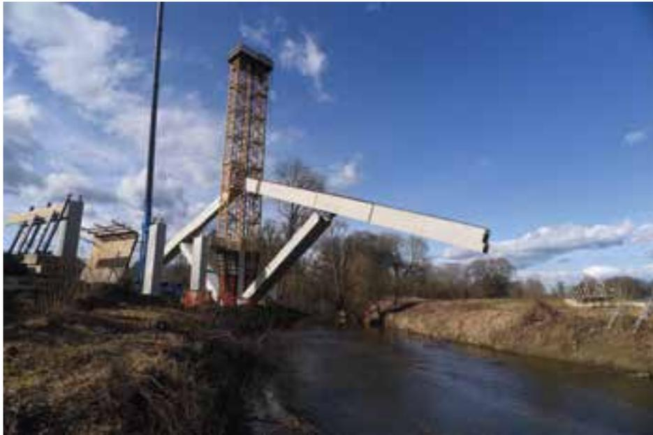
11 *Brückenkippverfahren: erster von vier Stegen bei der Brücke über die Lafnitz im Februar 2020*
