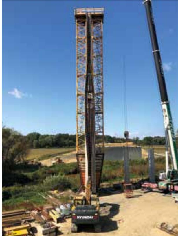
8 Vertikale Montage der dünnwandigen Brückenträger bei der Brücke über den Lahnbach © Technische Universität Wien
