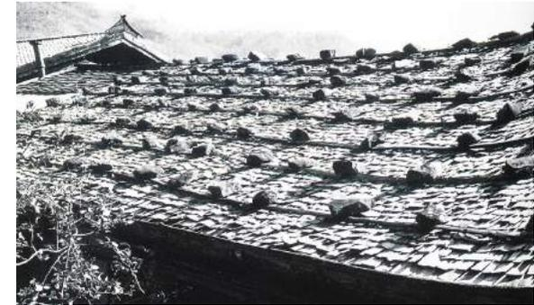
Abb.24 Dach mit Holzbrettern eines Minka Hauses
