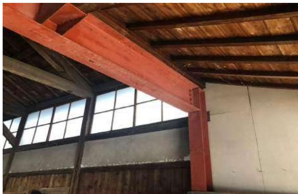
Abb.216 Konstruktionverstärkung des Eingangs 2
