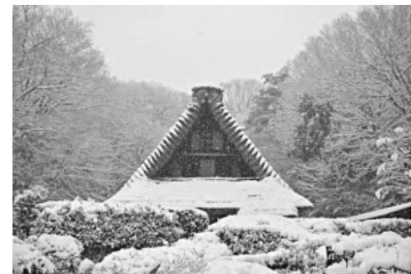
Abb.26 Steiles Strohdach eines Minka Hauses
