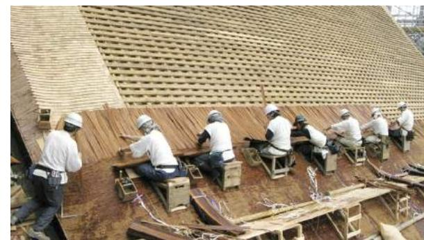
Abb.140 Erneuerung der Strohdeckung eines Daches
