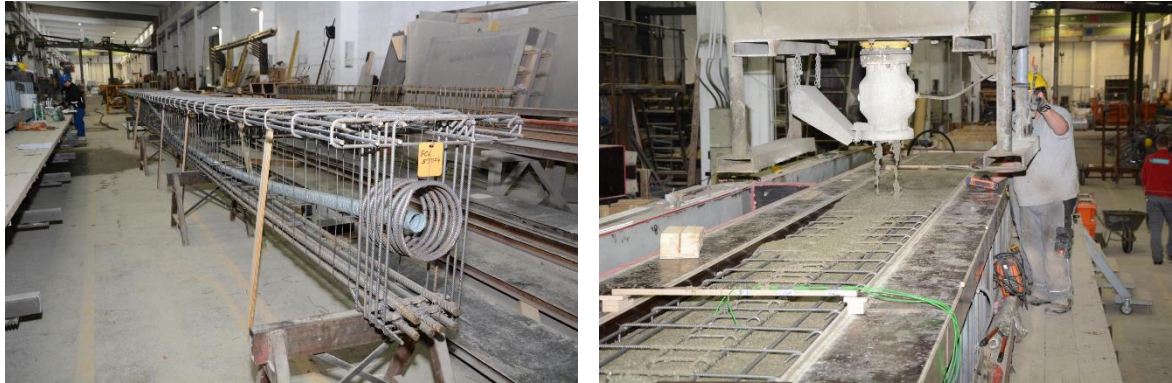
Abbildung 3.5: Fotos der Fertigung: Bewehrungskorb mit Hüllrohr (links) und Betonieren des Trägers (rechts)
