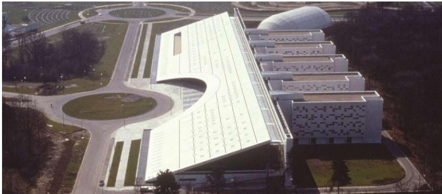
Abb. 95: Ingenieurschule von Dominique Perrault
