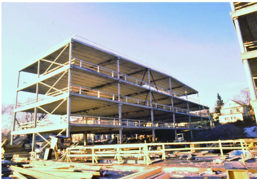
Abb. 58: Klassentrakte im Bauzustand
