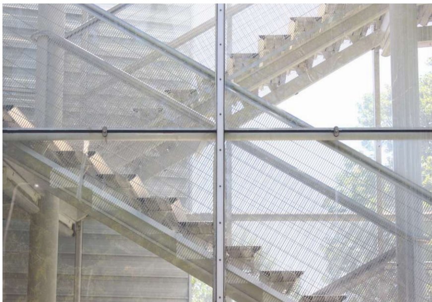
Abb. 75: Glashalterung Fluchtstiege
