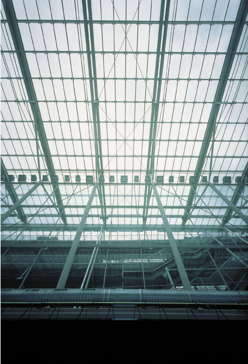
Abb. 47: Dachkonstruktion von Innen
