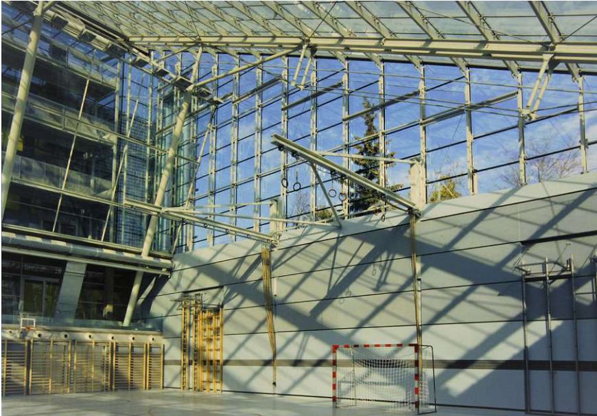
Abb. 39: Ostseite der Sporthalle
