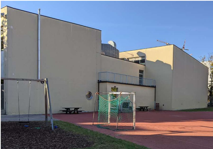
Abb. 116: Ostseite des Gebäudes
