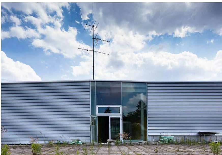
Abb. 79: Zugang zur Dachterrasse, Block II
