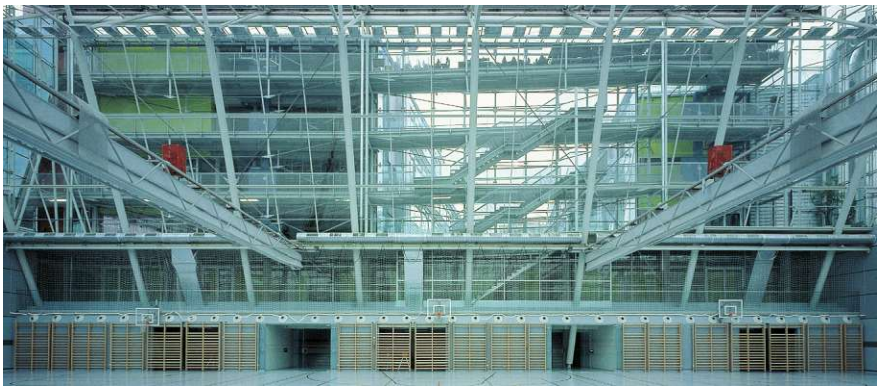
Abb. 87: Blick auf Erschließungsgang mit Weitwurfdüsen
