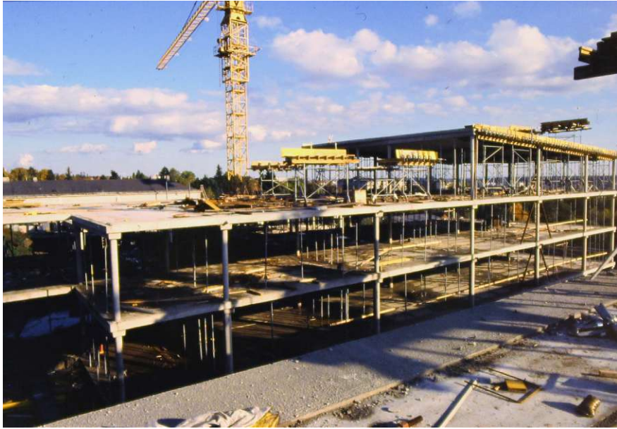
Abb. 63: Klassentrakte im Bauzustand
