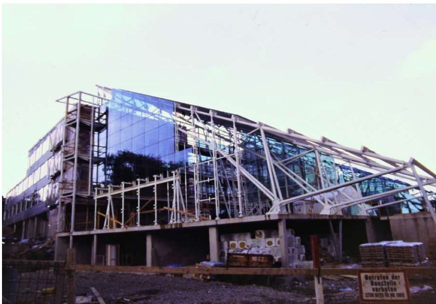
Abb. 32: Glaserarbeiten an der Aula
