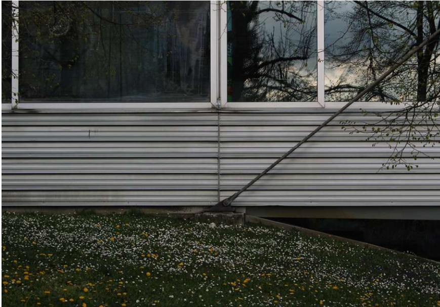
Abb. 61: Außenfassade mit Aussteifung
