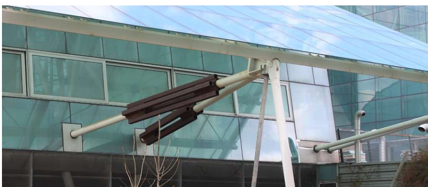
Abb. 108: Ergänzung der korrodierten Stahlträger der Aula
