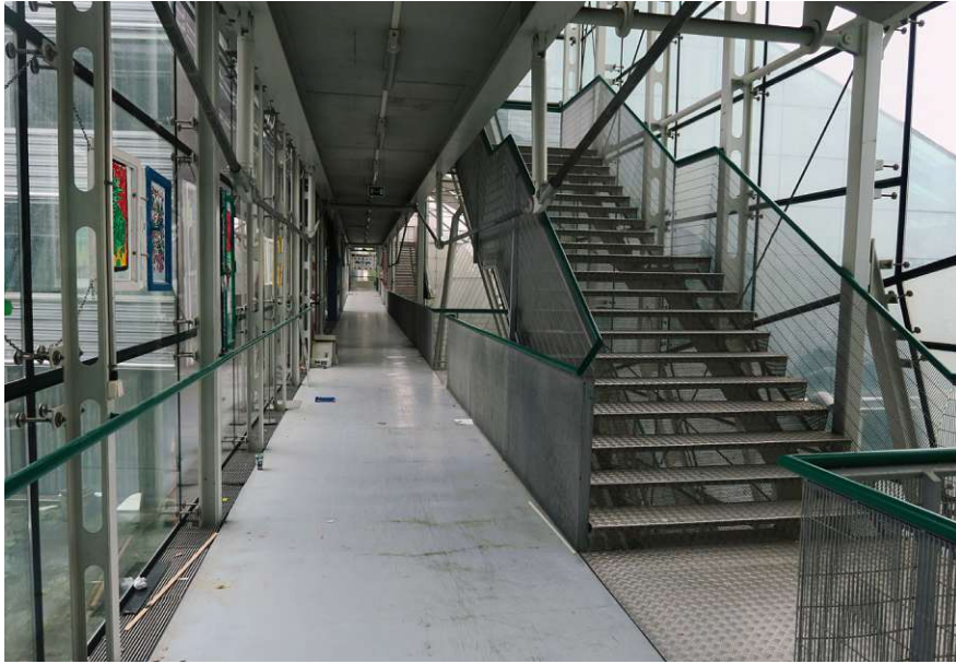
Abb. 50: Erschließungsgang mit Stiege
