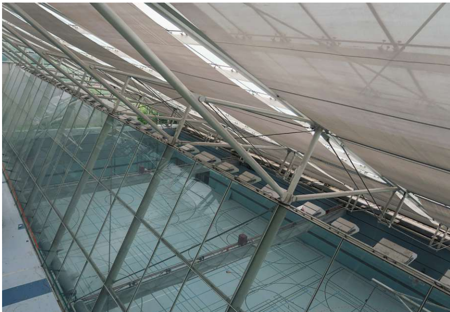
Abb. 36: Schrägverglasung zwischen Turnhalle und Erschließungsgang
