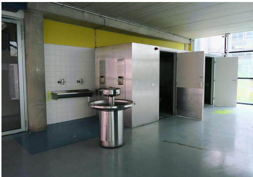
Abb. 55: Hofsituation bei Block II
