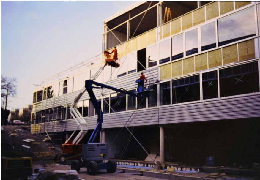
Abb. 64: Fassadenarbeiten, Block II
