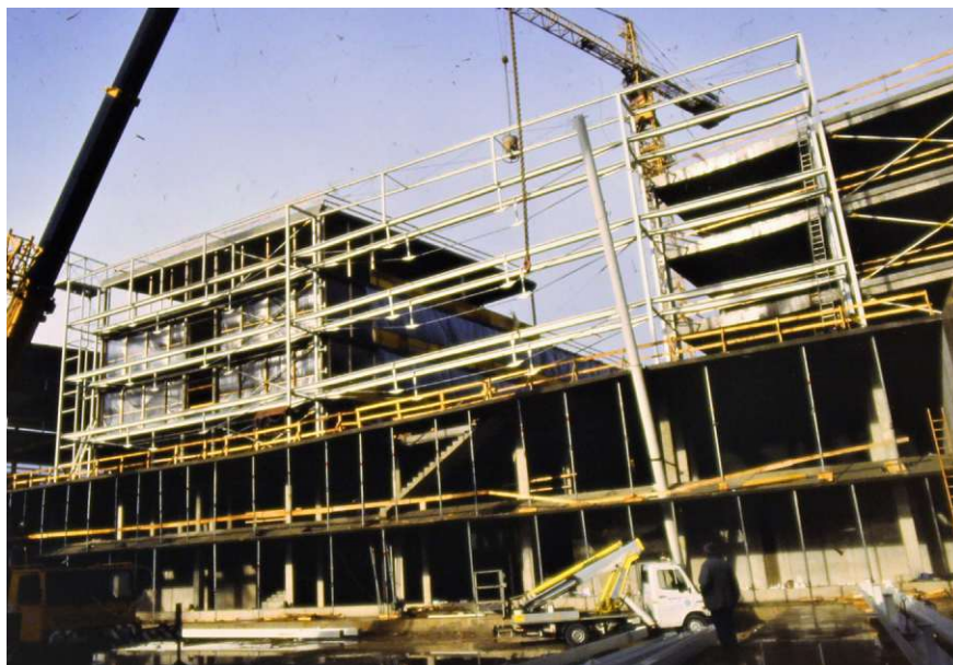
Abb. 52: Erschließungsgang im Bauzustand
