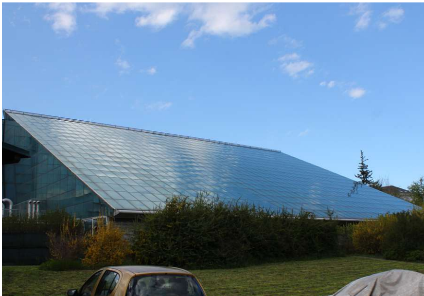
Abb. 37: Hallendach von Außen
