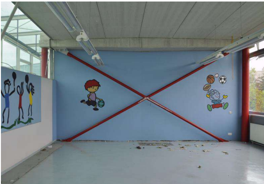
Abb. 62: Klassenzimmer mit Aussteifung
