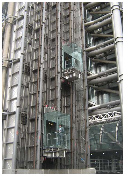
Abb. 94: Außenlifte am Lloyd's Building
