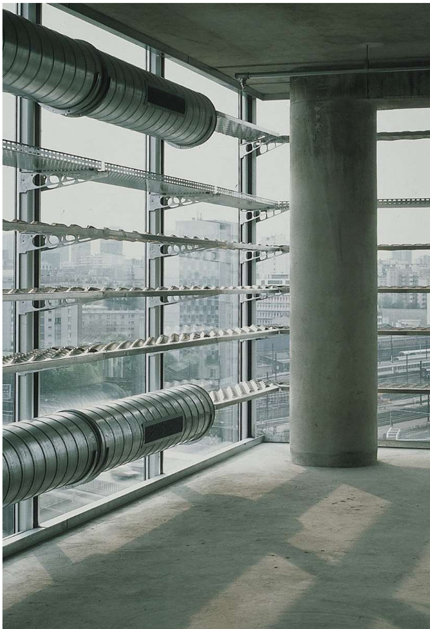
Abb. 126: Fassade vor der Sanierung, Hôtel Industriel Berlier
