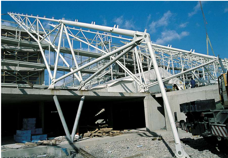
Abb. 31: Stahlkonstruktion Aula im Bauzustand
