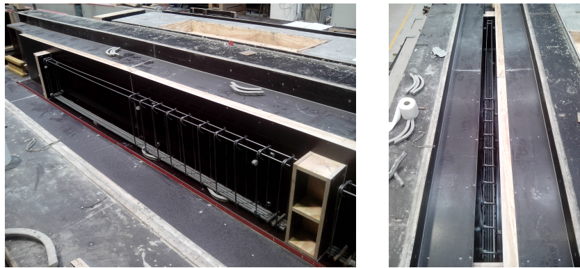
Abb. 3.19: Schalung und eingelegte Bewehrung der Stahlbetonträger
