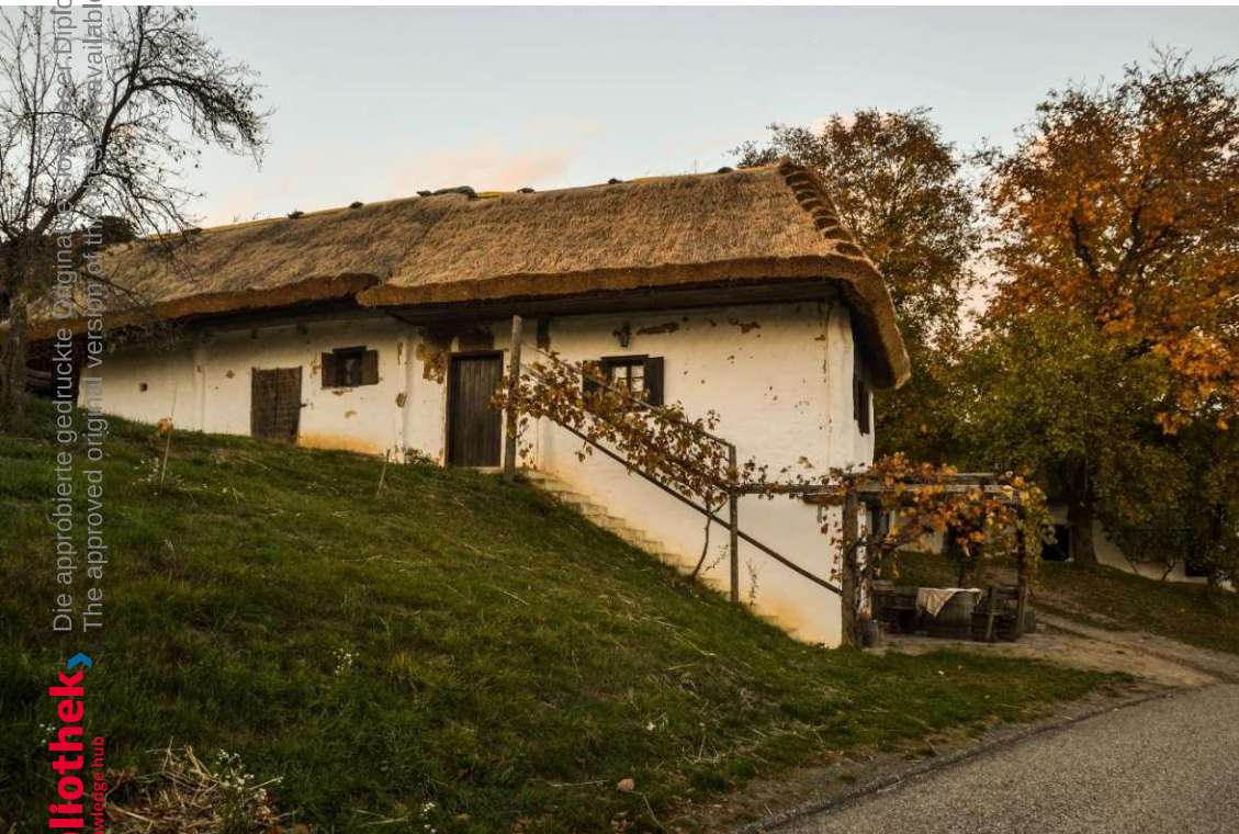
Abb.: 9 - Kellerviertel Heiligenbrunn, Dachdeckung mit Stroh
