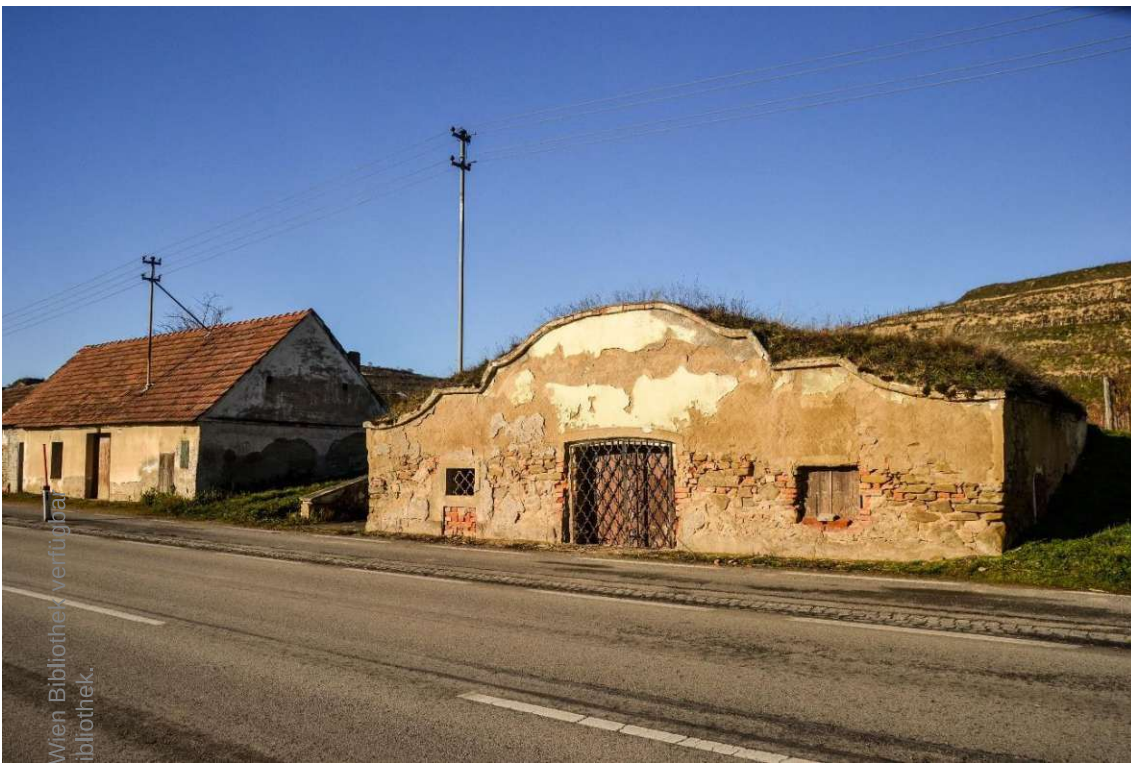
Abb.: 10 - Kellergasse zwischen Gedersdorf und Hadersdorf, Schildmauer mit Barock Elementen
