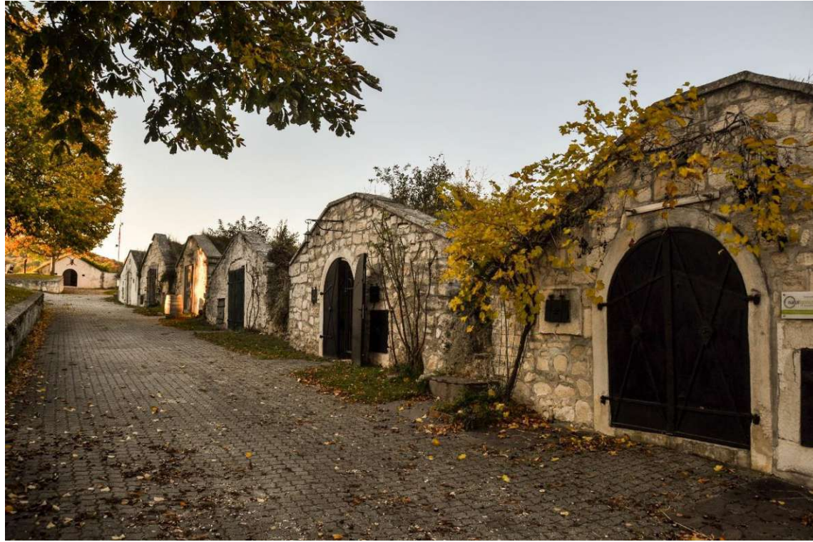
Abb.: 8 - Kellergasse Breitenbrunn, Schildmauer
