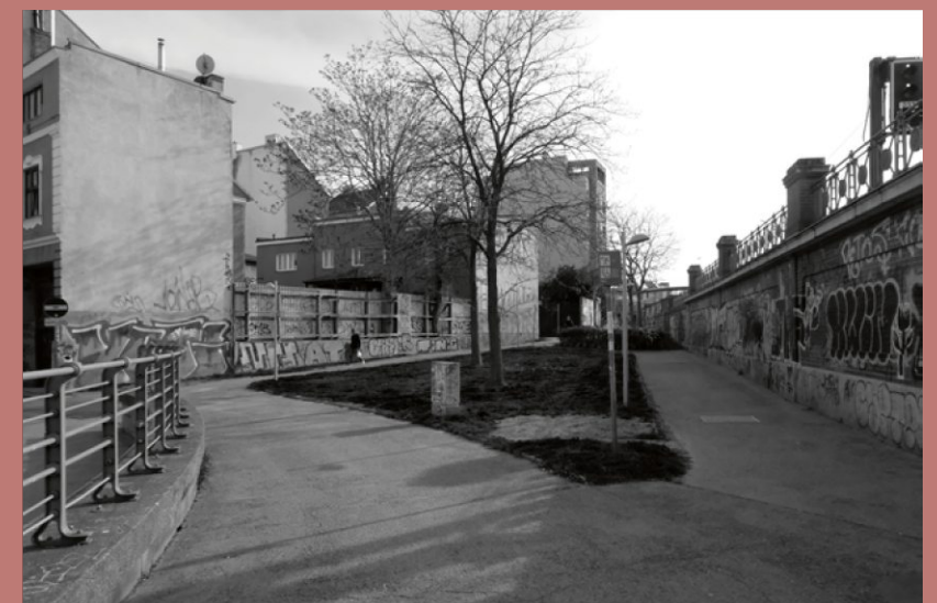
Blick von Koblingergasse Richtung OL sowie Fußgängerweg entlang der Stadtbahn
