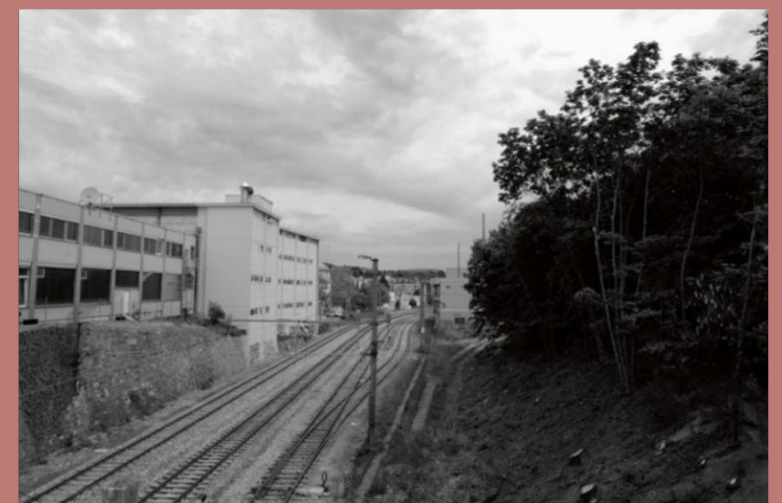
Zu sehen: die Brachfläche, Leerstände links sowie das Stellwerk rechts
