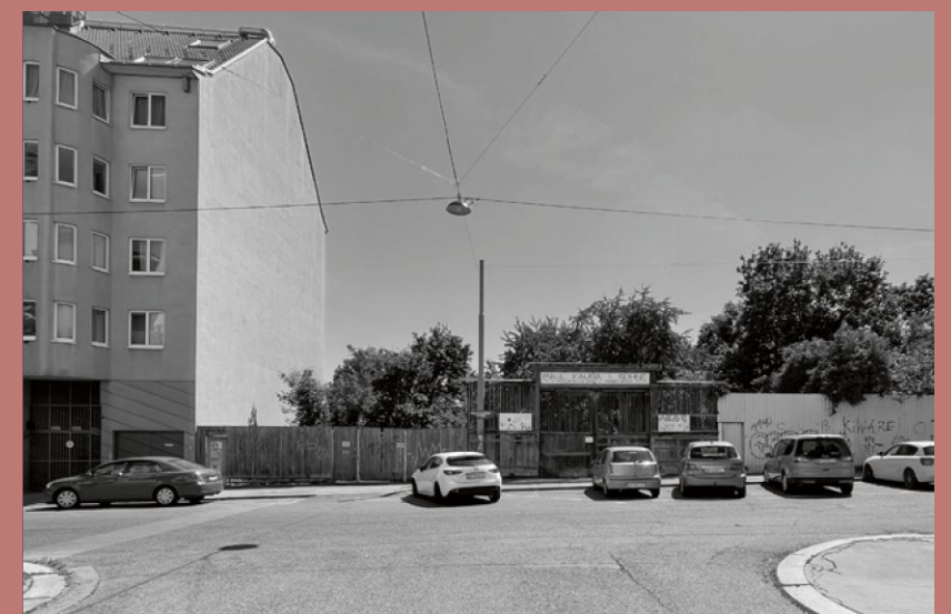
Blick von der Goldschlagstraße - Holzabspernung deutet auf eine Zwischennutzung
