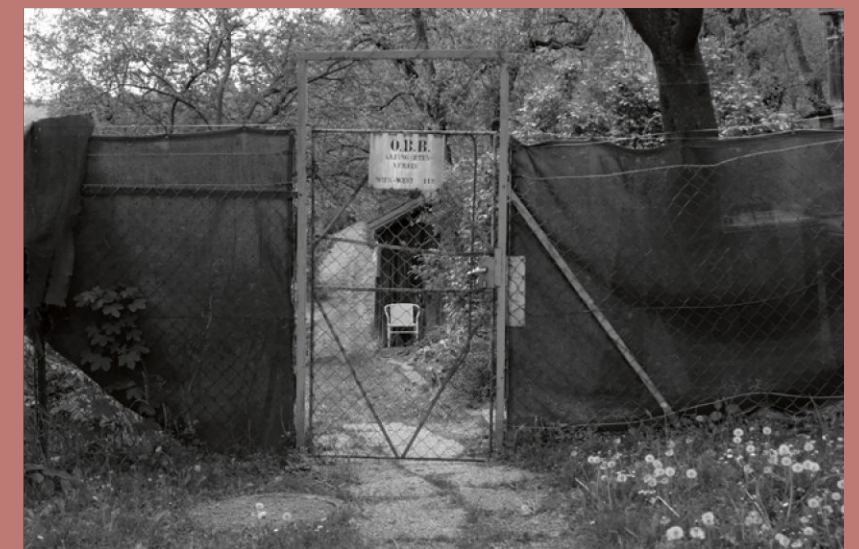
Eingangssituation von der Lazargasse, Ecke Lidlgasse (1)
