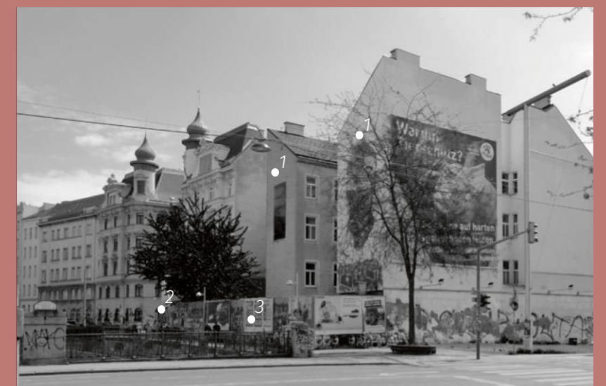
Blick über die Reinprechtsdorfer Brücke Richtung des OLs
