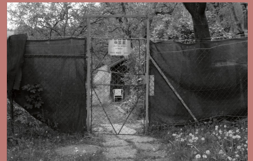
Eingangssituation von der Lazargasse, Ecke Lidlgasse (1)
