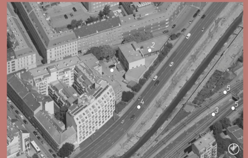
Luftbild - ohne Baulücke des Grundstückes 194/5
