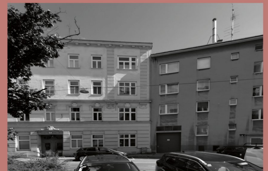
Ansicht auf die Gebäude Pillergasse 7-9
