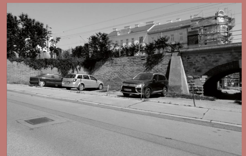
Blick von der Amortgasse Richtung des OLS sowie Öffnung des Bogens zur 2. Fläche
